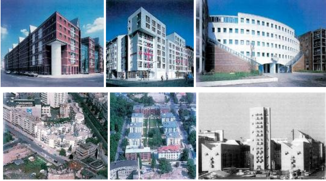
Şekil 5.20 : IBA 1987 Uluslararası Yapı Sergisi Kapsamında İnşa Edilen Yeni Yapılardan Örnekler (Url-2)
