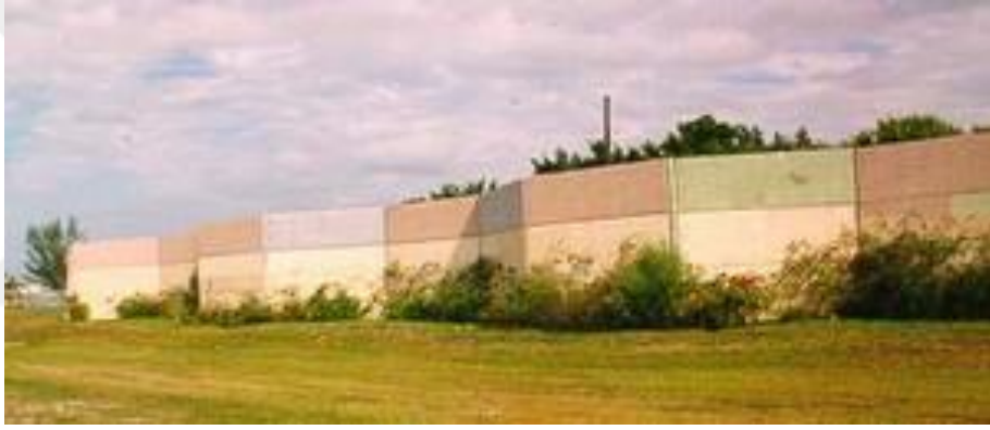
Şekil 3.13 : Bağımsız gürültü duvarı [78].
