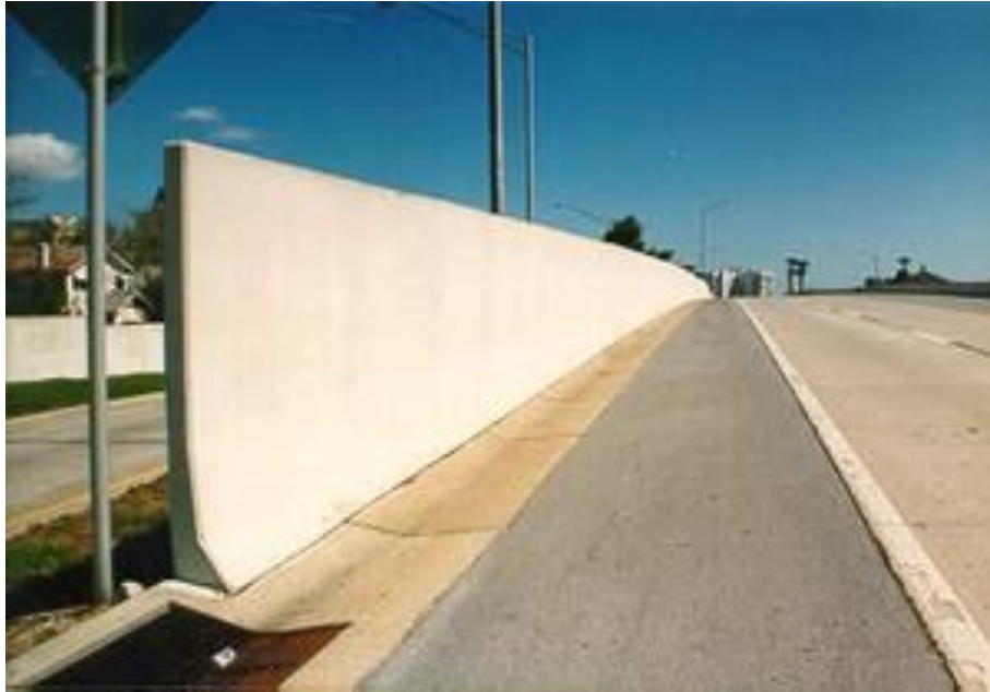
Şekil 3.16 : Yerinde dökme beton ses duvarı [78].
