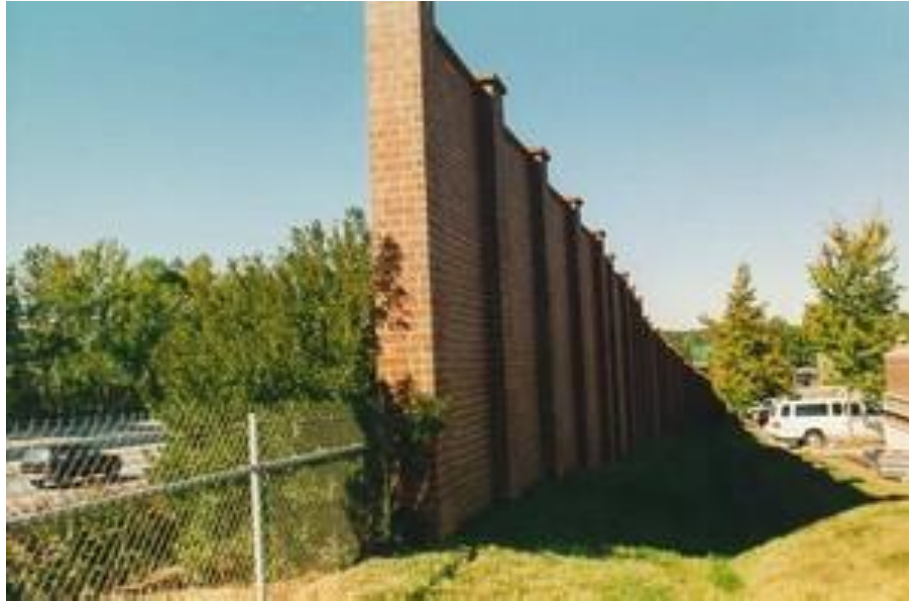
Şekil 3.11 : Tuğla ses duvarı [78].
