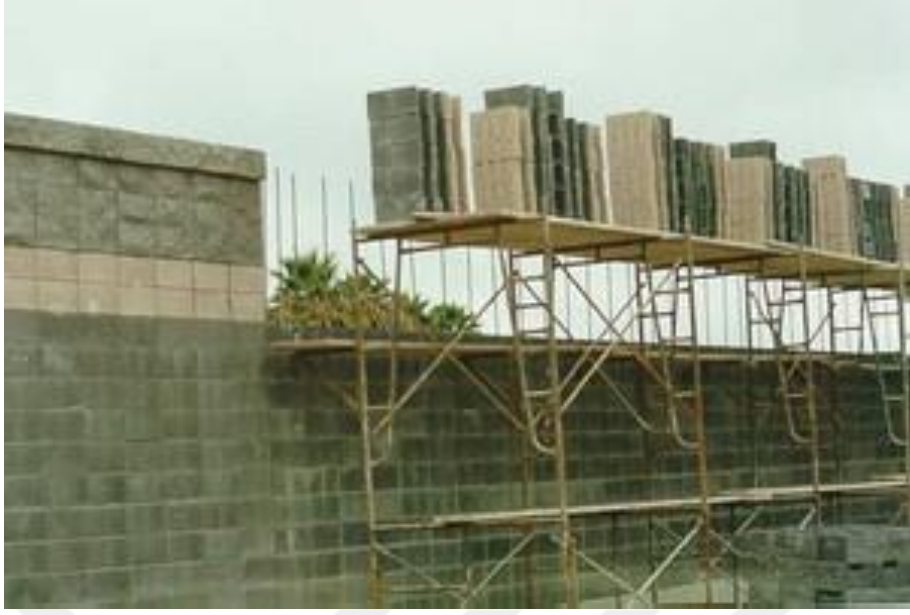
Şekil 3.12 : Yığma blok ses duvarı [78].
