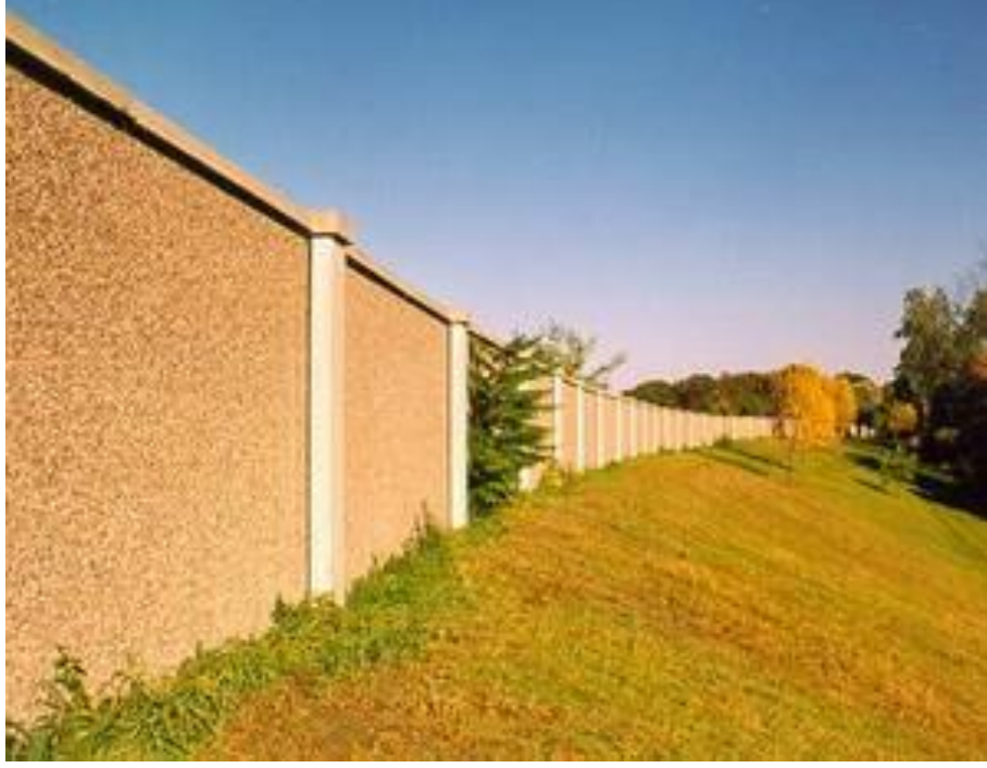
Şekil 3.10 : Direk ve panel gürültü duvarı [78].
