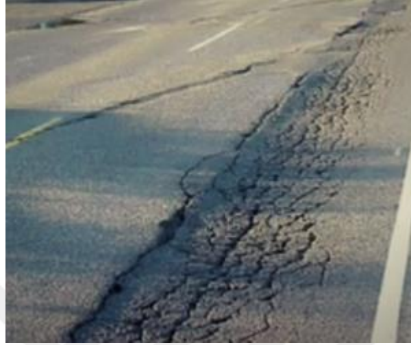
Şekil 2.18: Yorulma çatlakları.
