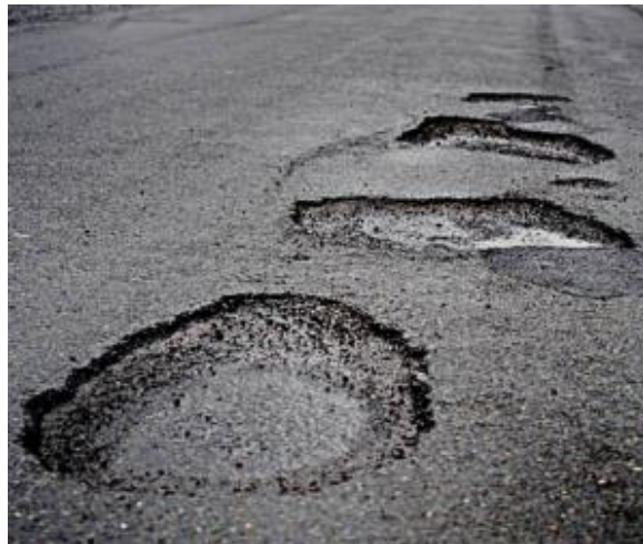
Şekil 2.16: Çökmeye örnek.
