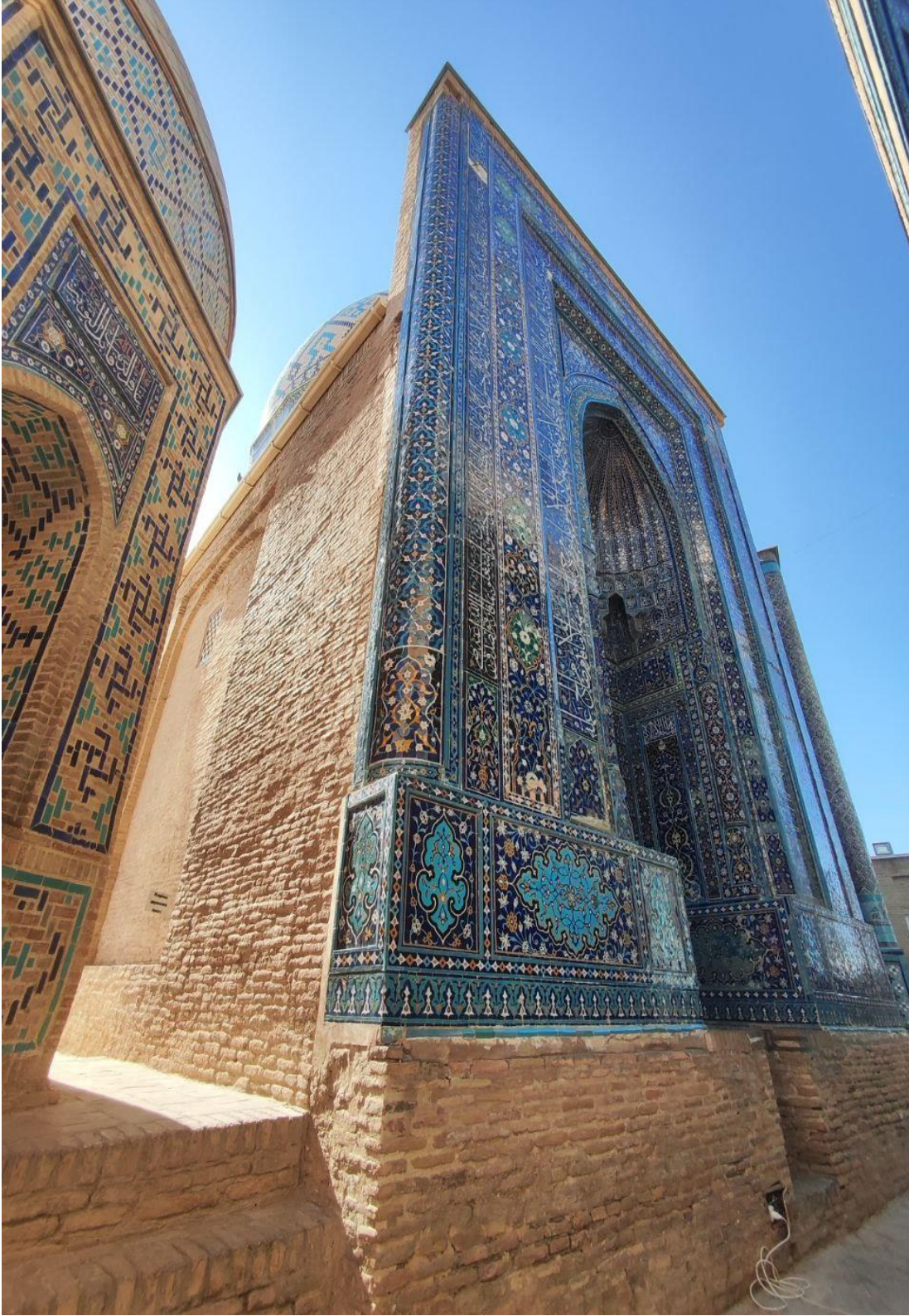
Fotoğraf 4.116: Şirin Bike Aka Türbesi Kuzeybatı Cephe
