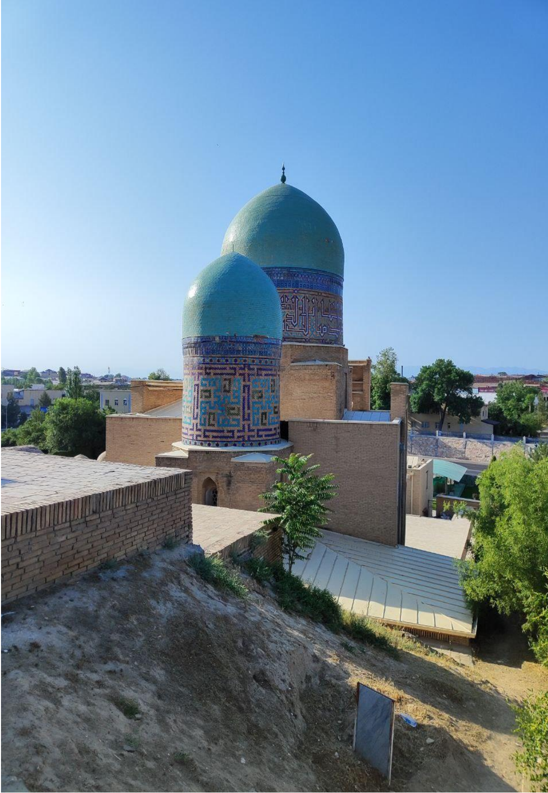
Fotoğraf 4.149: Kadızade-i Rumi Türbesi Kuzey Cephe
