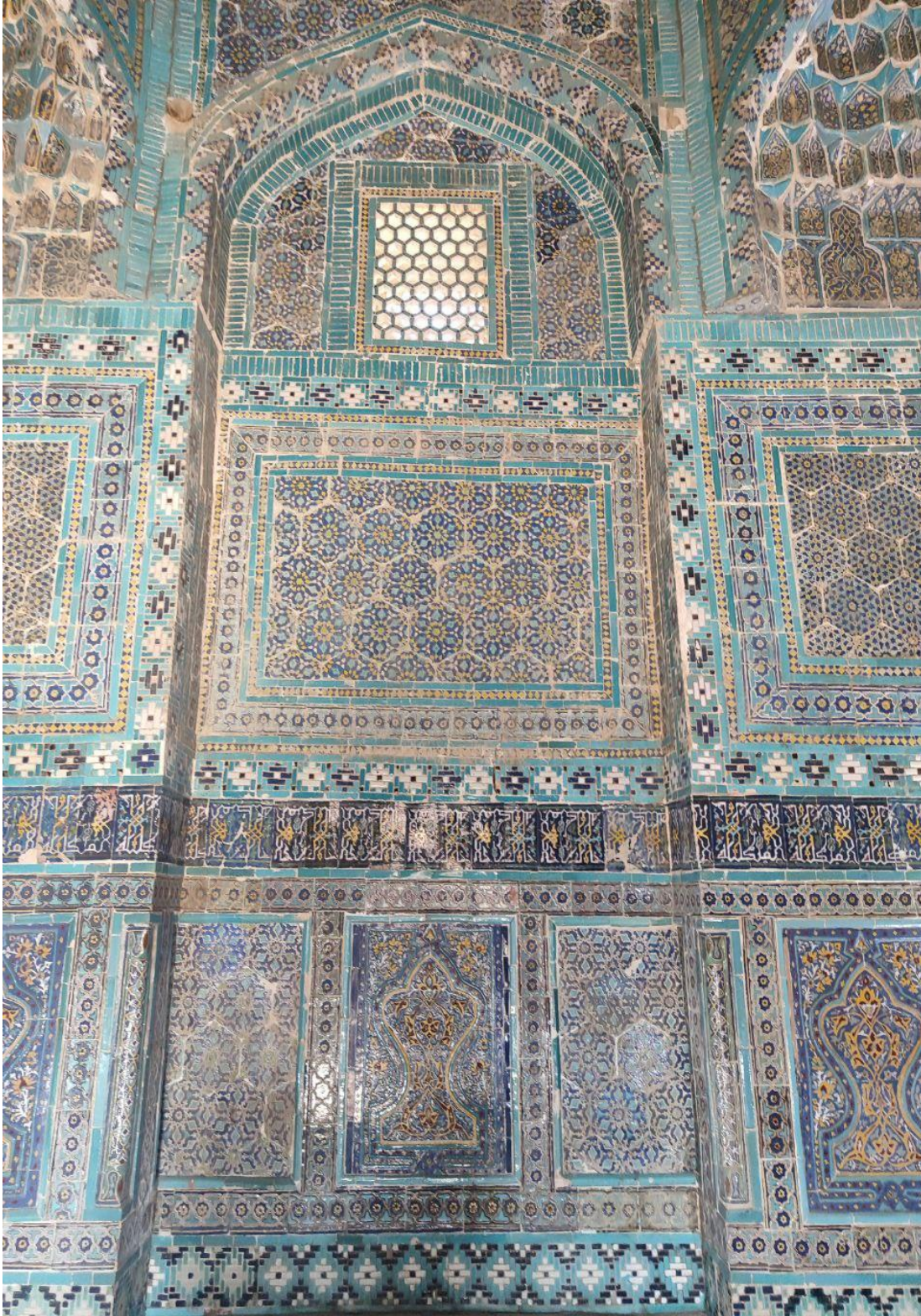
Fotoğraf 4.53: Üstat Ali Neseî T rbesi İ  Batı Cephe  ini Detay
