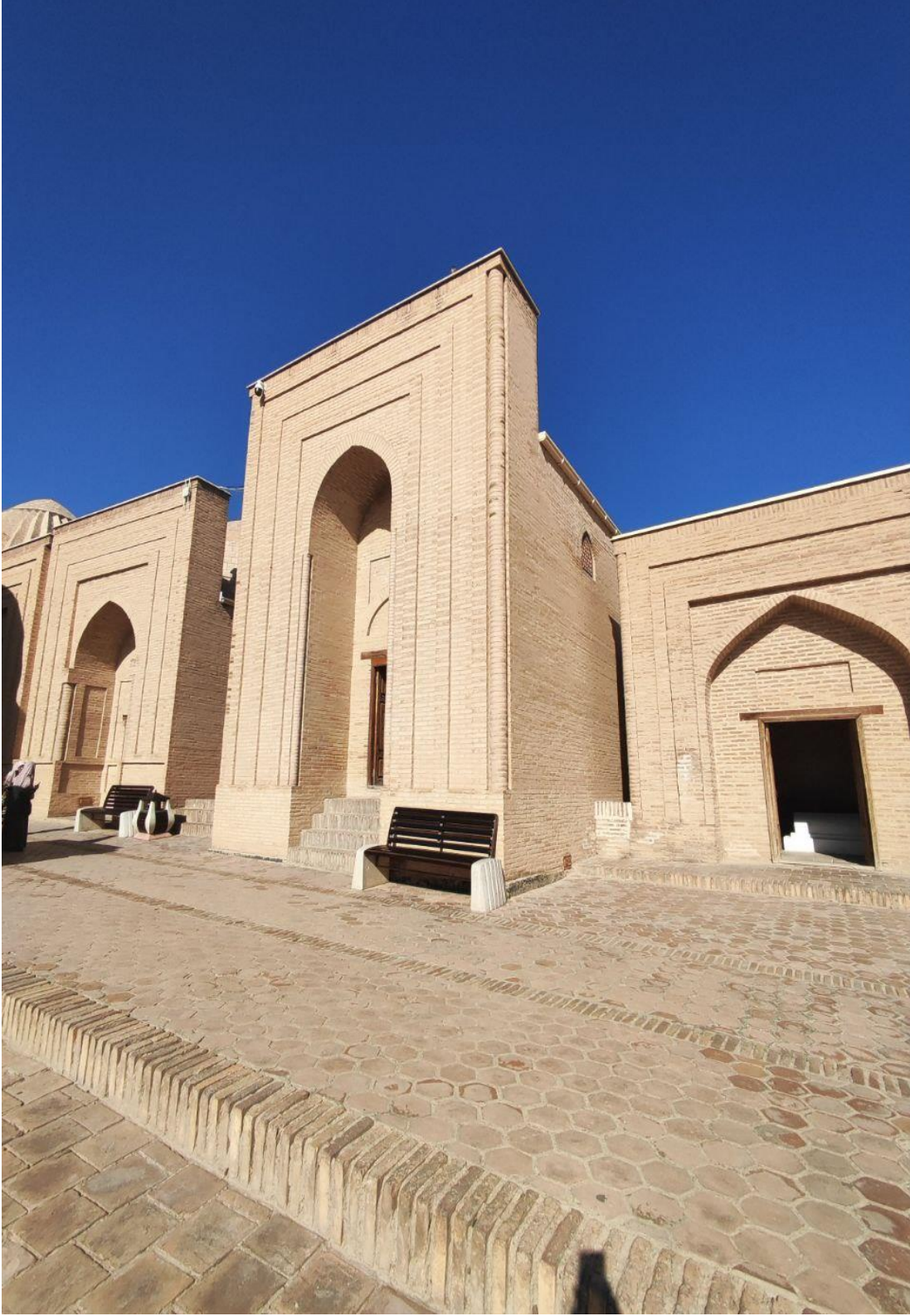
Fotoğraf 4.226: 34 Numaralı Anonim Türbe Kuzeydoğu Cephe
