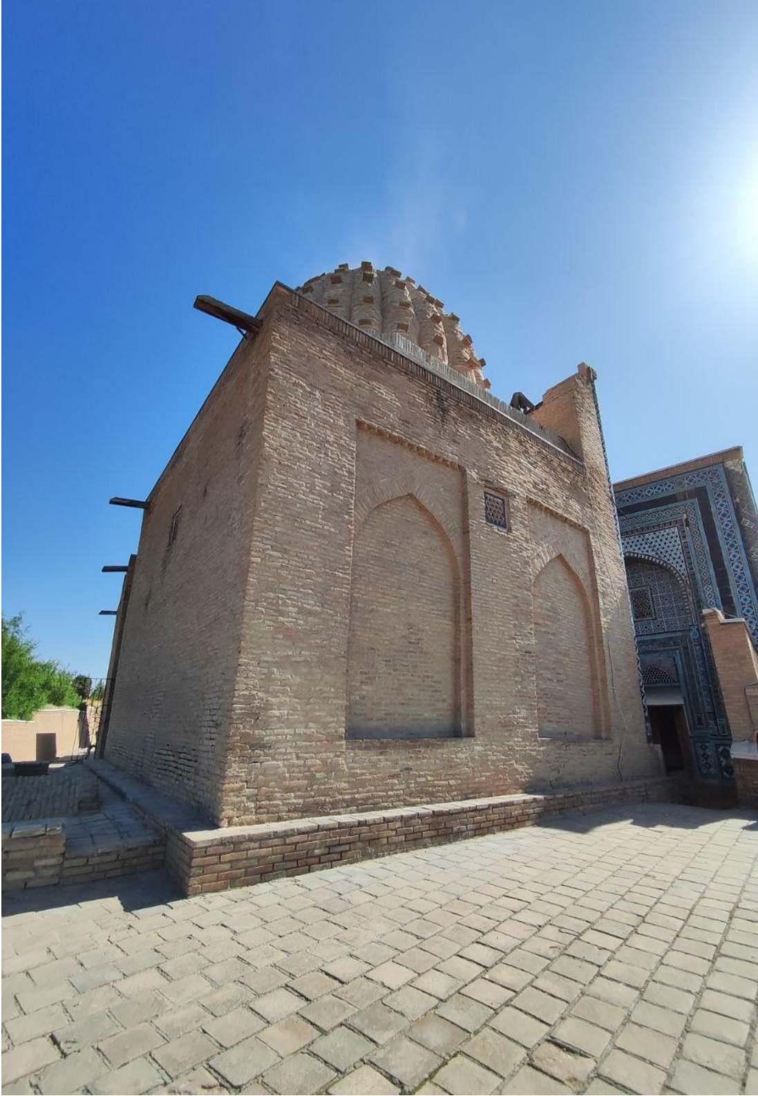
Fotoğraf 4.131: Emir Zade Türbesi Güneybatı Cephe
