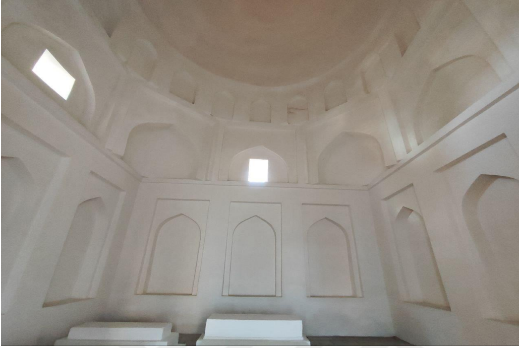
Fotoğraf 4.141: Emir Zade Türbesi Batı Cephe
