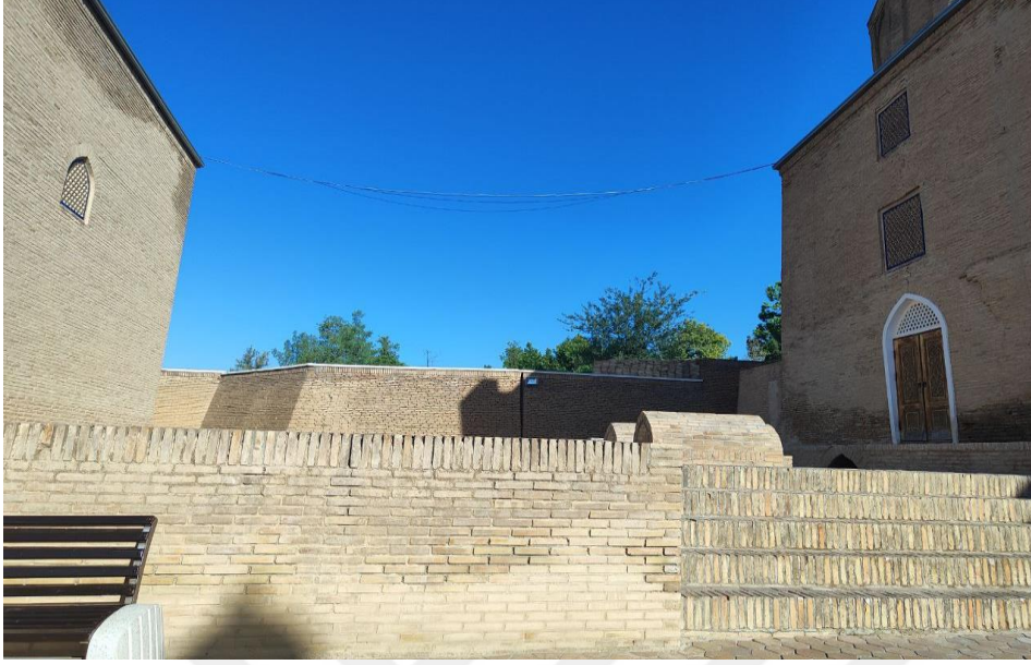
Fotoğraf 4.271: 36 Numaralı Anonim Türbe Kalıntısı Doğu Cephesi
