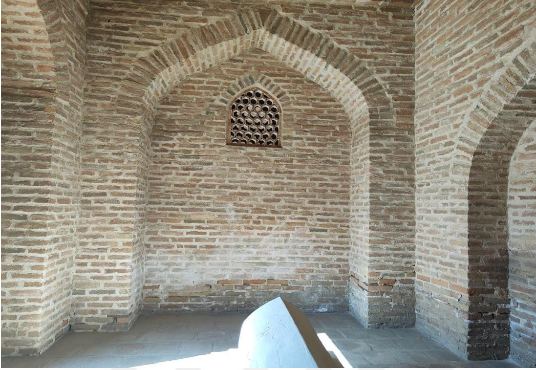
Fotoğraf 4.244: 33 Numaralı Anonim Türbenin Güney İç Cephesi
