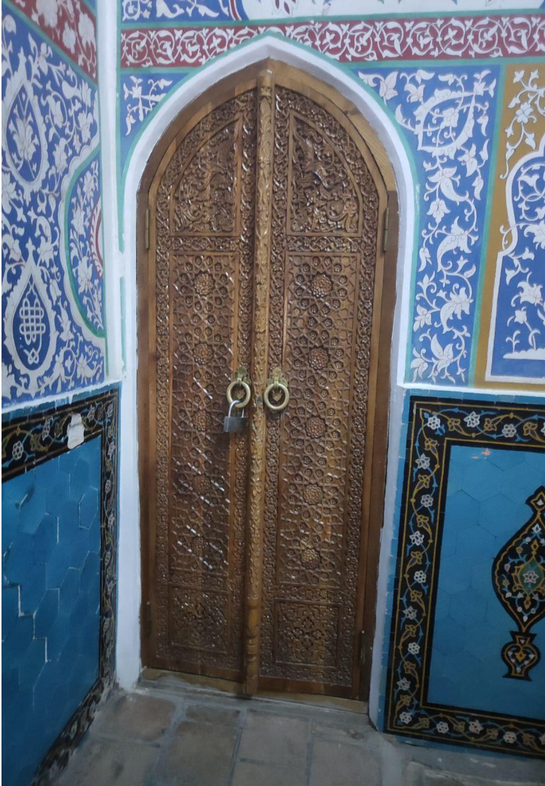
Fotoğraf 4.25: Kusem Bin Abbas Türbesinin Ahşap Giriş Kapısı
