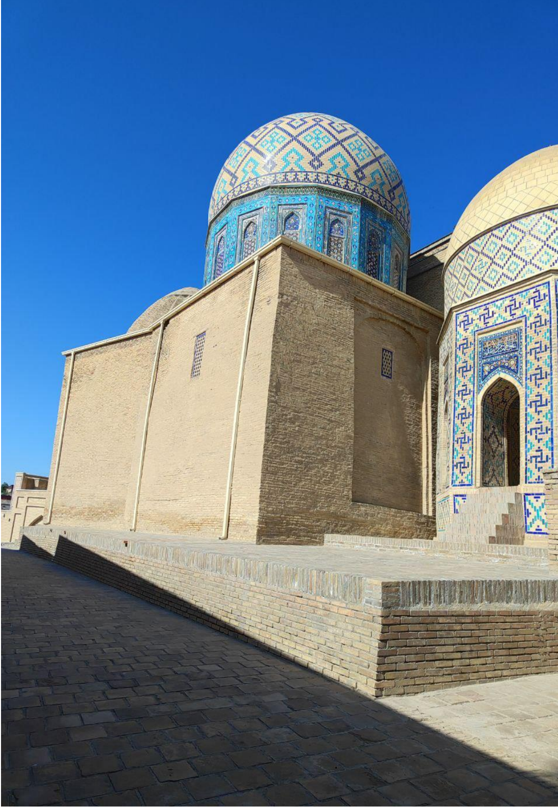
Fotoğraf 4.115: Şirin Bike Aka Türbesi Kuzeydoğu Cephe
