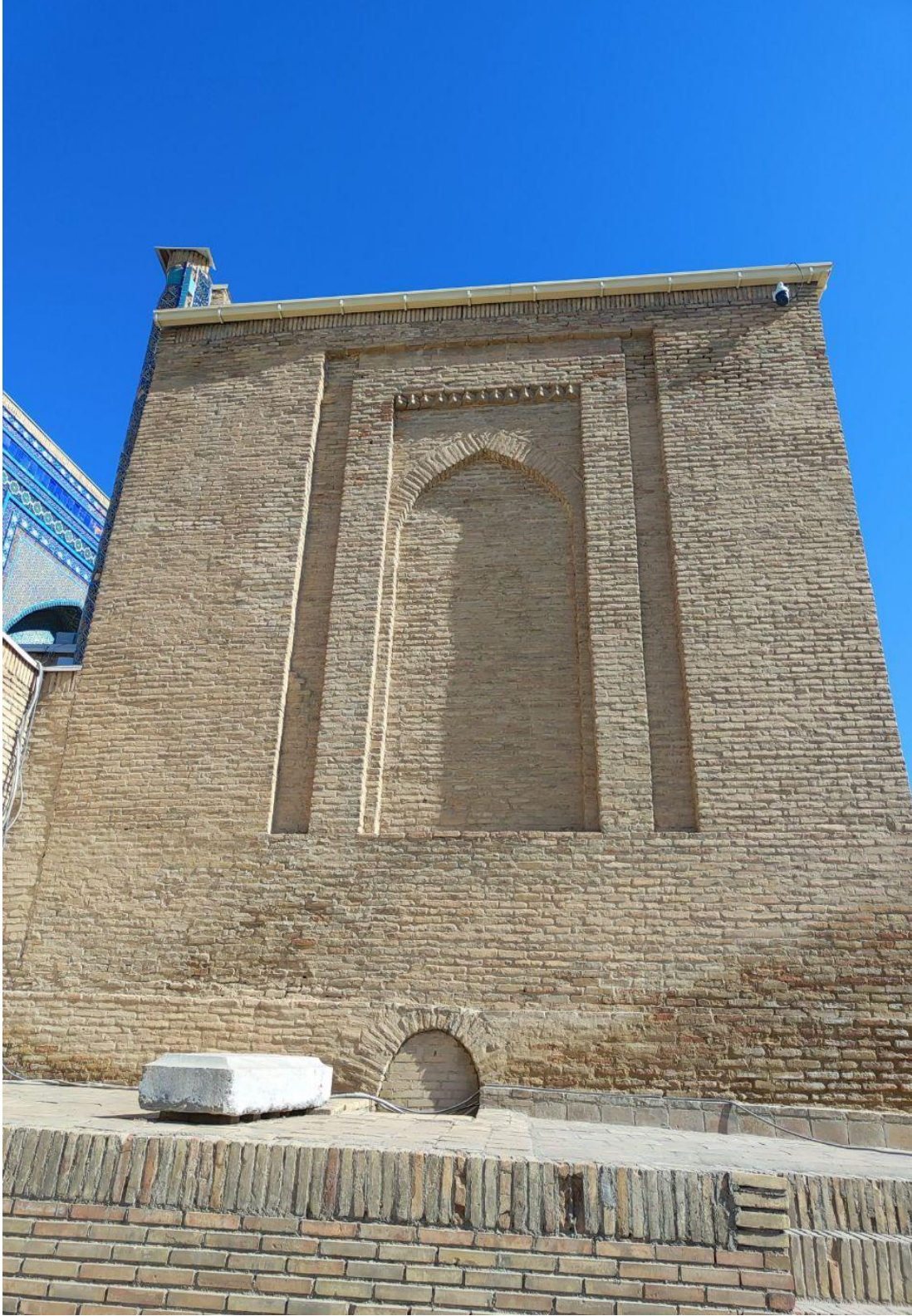
Fotoğraf 4.173: Tuğluk Tekin (Emir Hüseyin) Türbesi Güney Cephe
