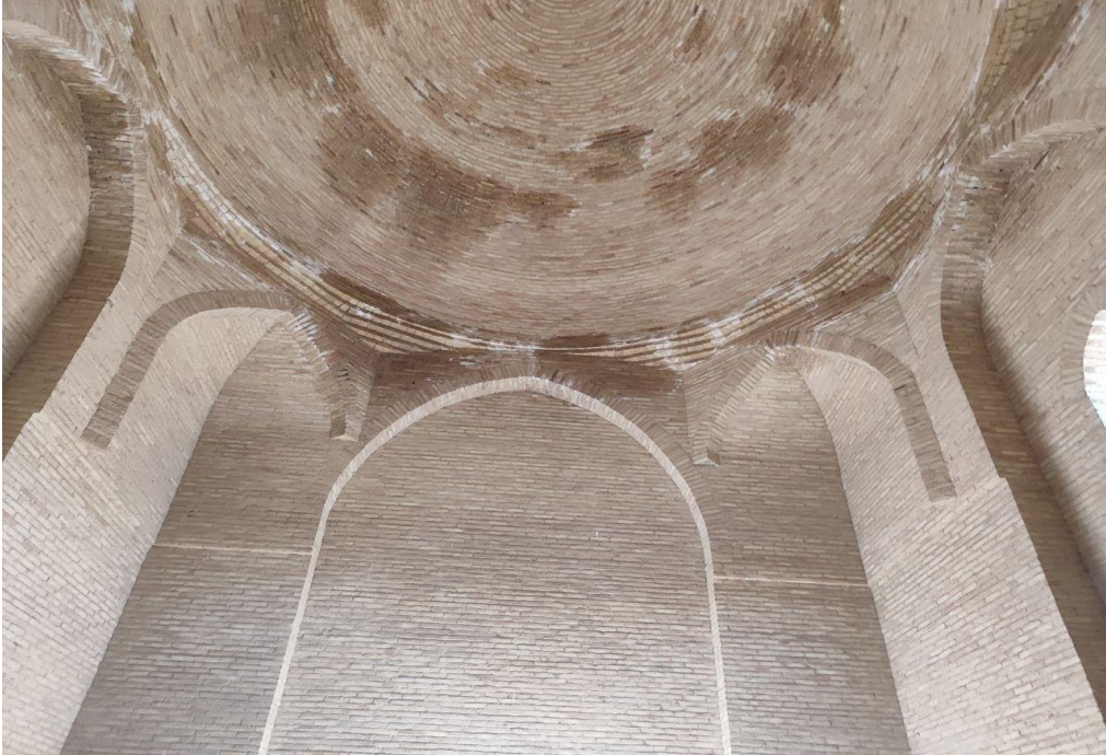
Fotoğraf 4.262: 12 Numaralı Anonim Türbe İç Mekan
