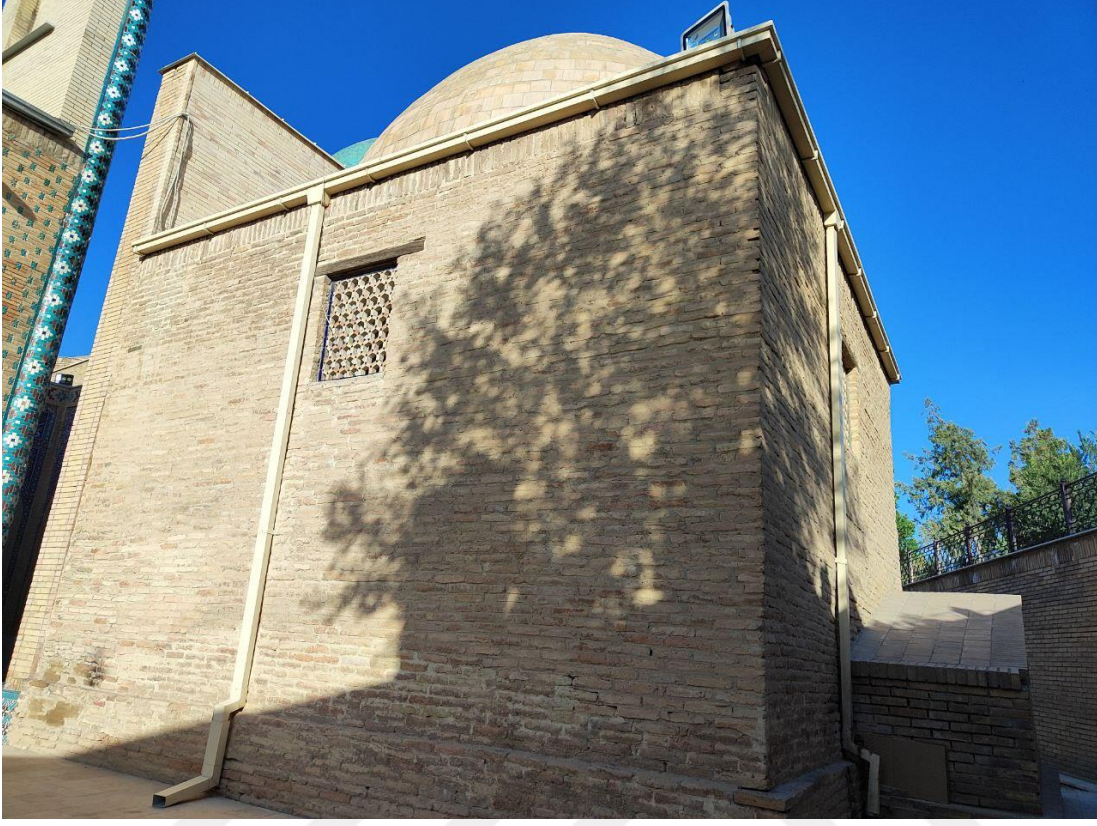
Fotoğraf 4.58: Hoca Ahmet Türbesi Kuzeydoğu Cephe
