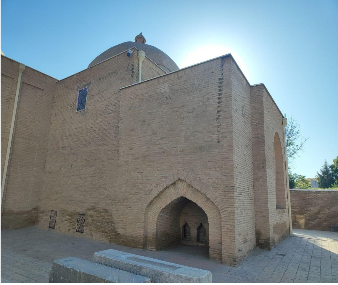
Fotoğraf 4.7: Kusem Bin Abbas Türbesi Batı Cephesi
