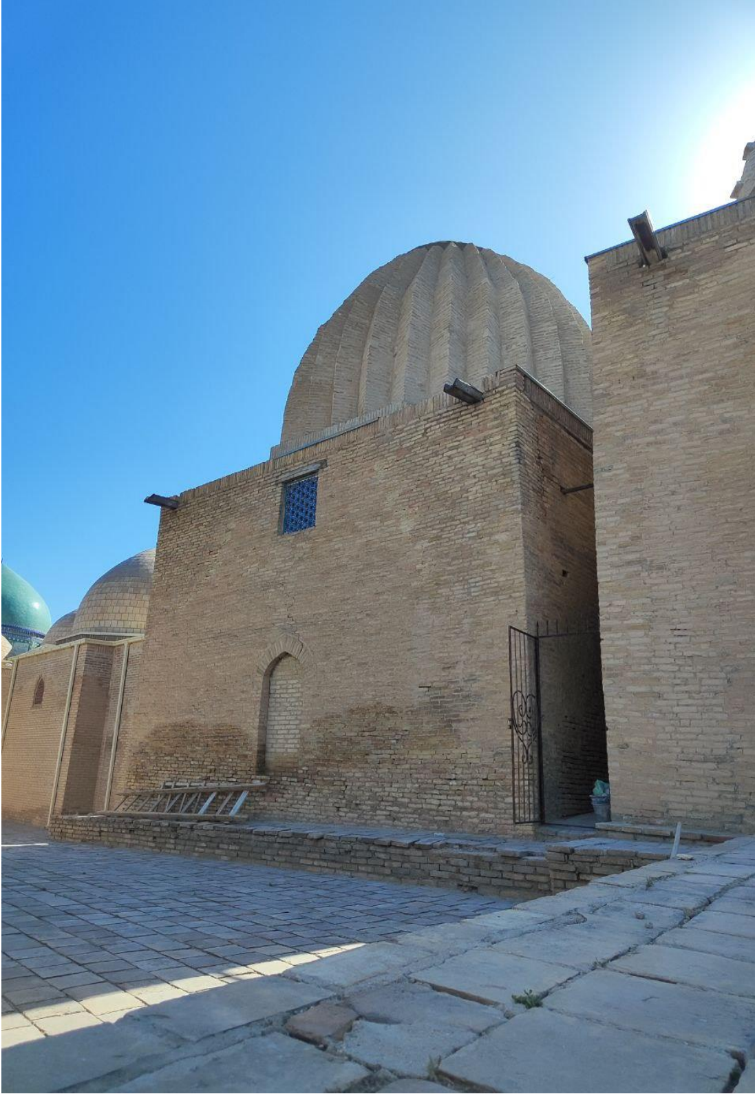
Fotoğraf 4.98: Şad-ı Mülk Türbesi Batı Cephe, Güneybatı Köşeden
