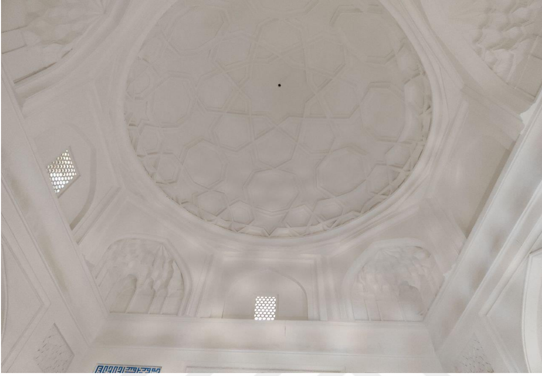
Fotoğraf 4.81: Emir Burunduk Türbesi Kubbeli Mekan
