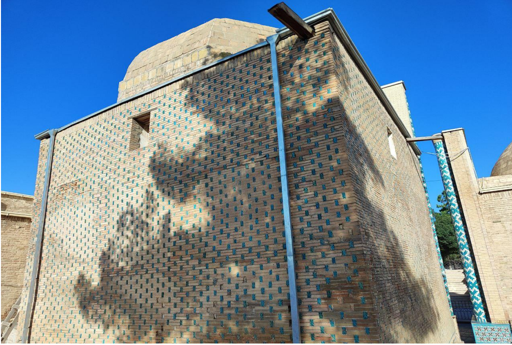
Fotoğraf 4.188: Kutluk Aka Türbesi Kuzeybatı Cephe
