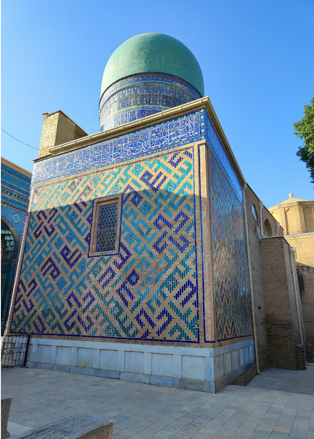
Fotoğraf 4.85: Tuman Aka Türbesi Kuzeybatı Cephe
