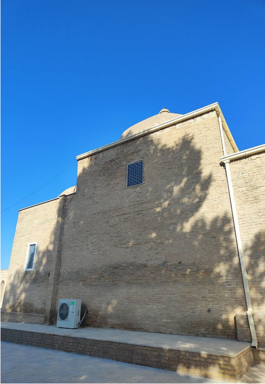
Fotoğraf 4.5: Kusem Bin Abbas Türbesi Doğu Cephesi
