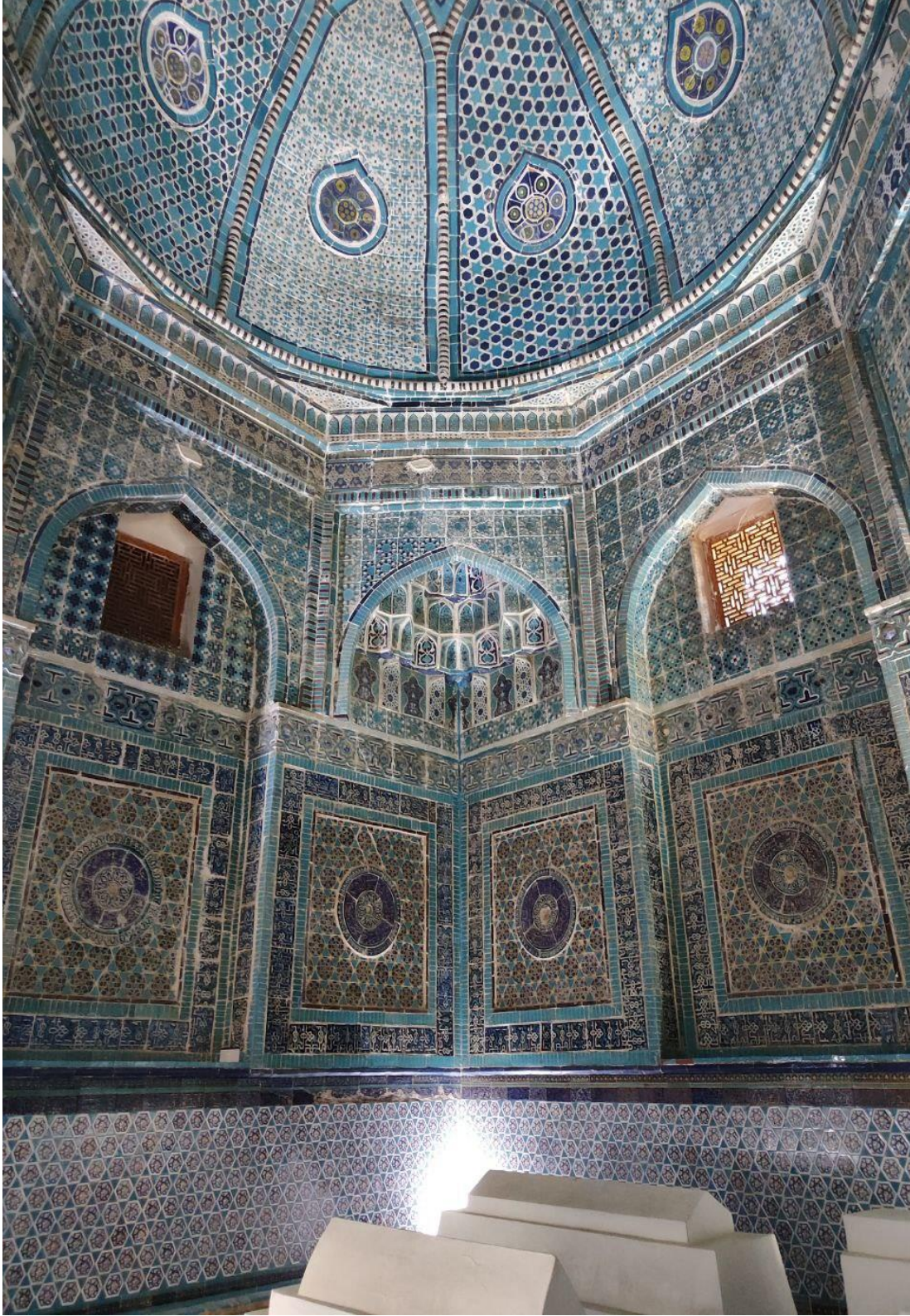
Fotoğraf 4.107: Şad-ı Mülk Türbesi Kuzeybatı köşesi
