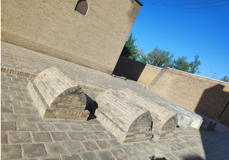
Fotoğraf 4.272: 36 Numaralı Anonim Türbe Sandukaları Kuzeydoğu Cephe
