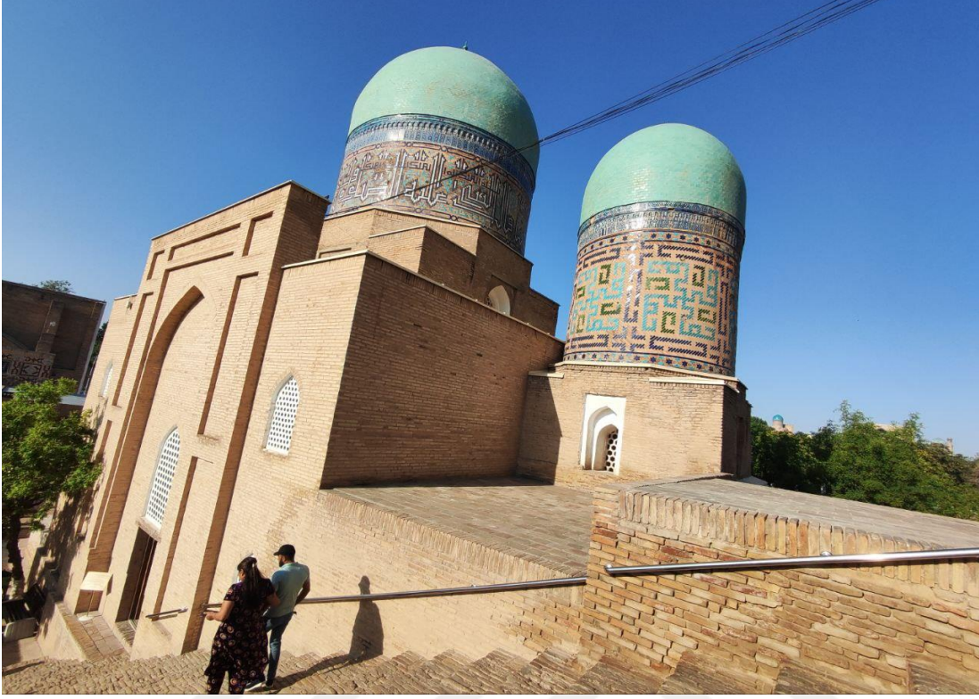
Fotoğraf 4.148: Kadızade-i Rumi Türbesi Kuzeydoğu Cephe
