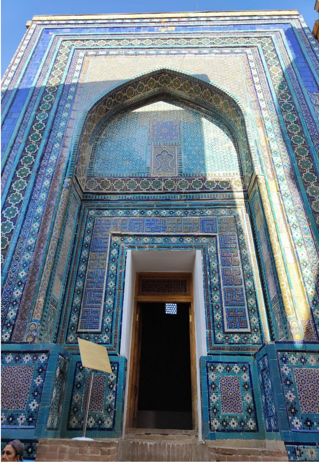
Fotoğraf 4.128: Emir Zade Türbesi Doğu Cephe
