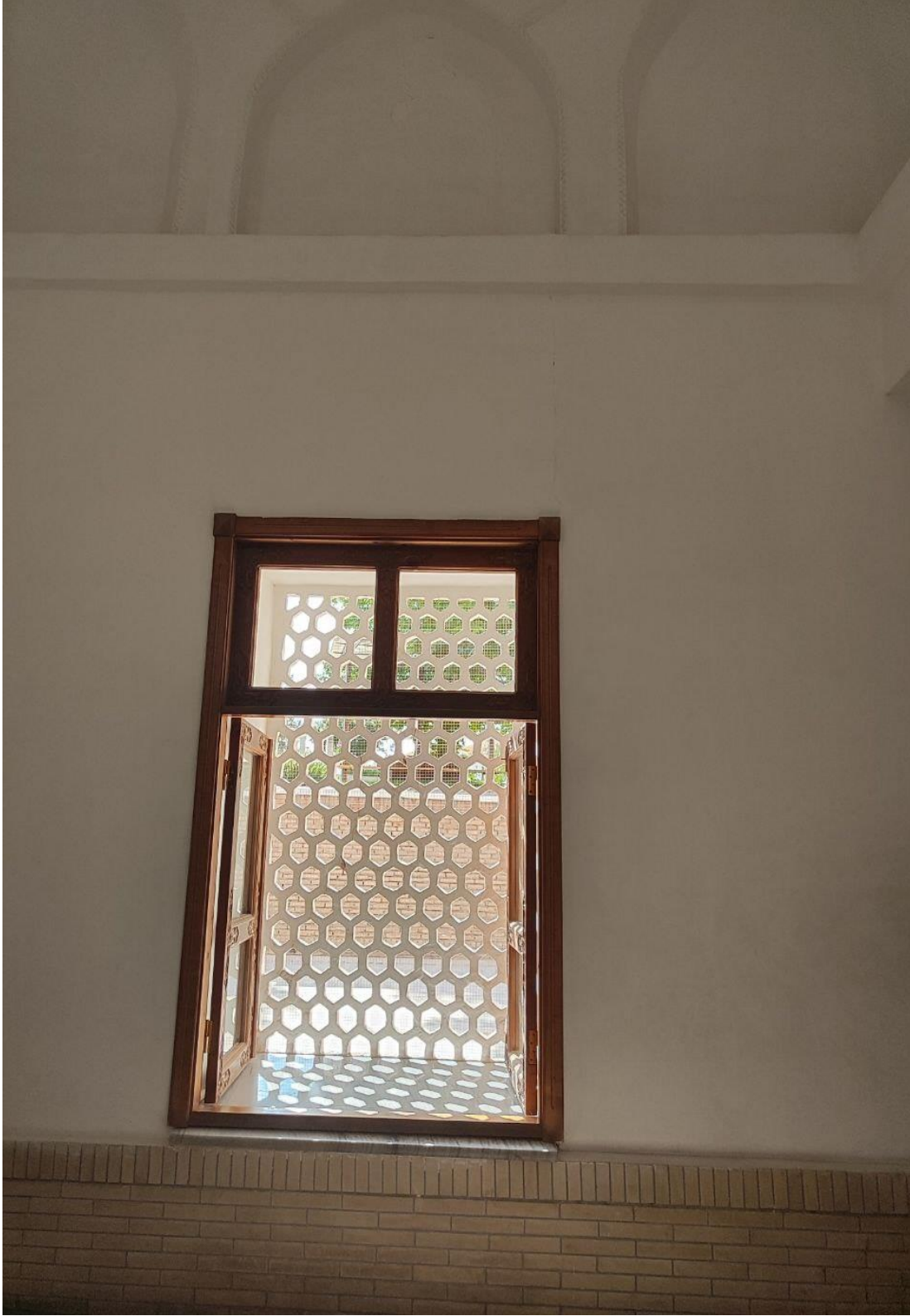
Fotoğraf 4.12: Kusem Bin Abbas Külliyesi Mescidin Doğu Cephesindeki Pencere
