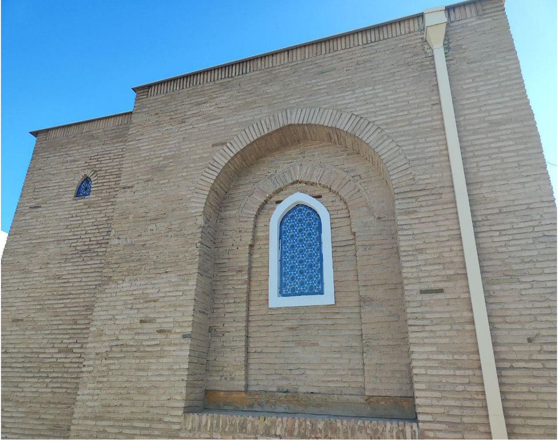
Fotoğraf 4.6: Kusem Bin Abbas Türbesi Güney Cephesi
