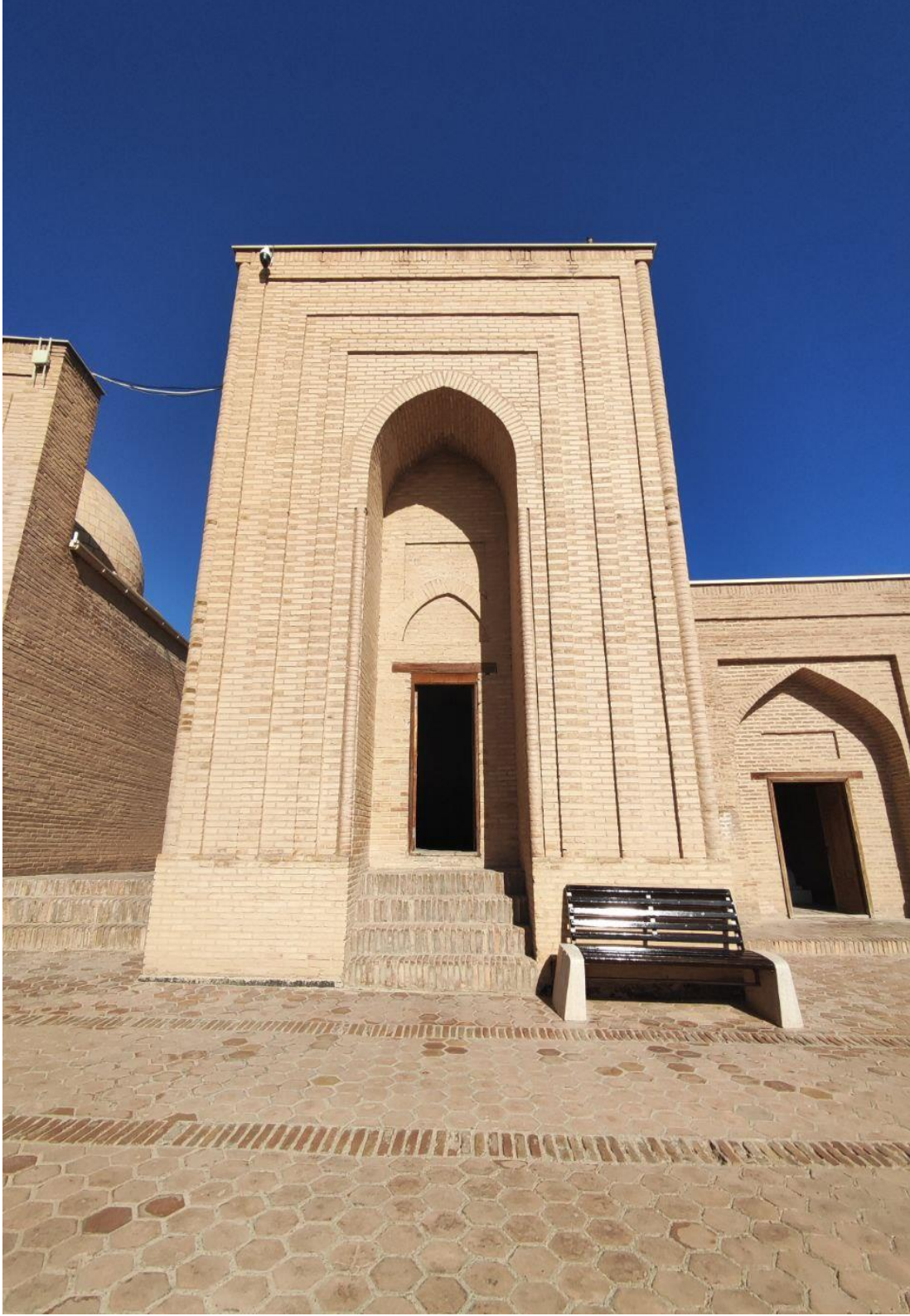
Fotoğraf 4.225: 34 Numaralı Anonim Türbe Doğu Cephe
