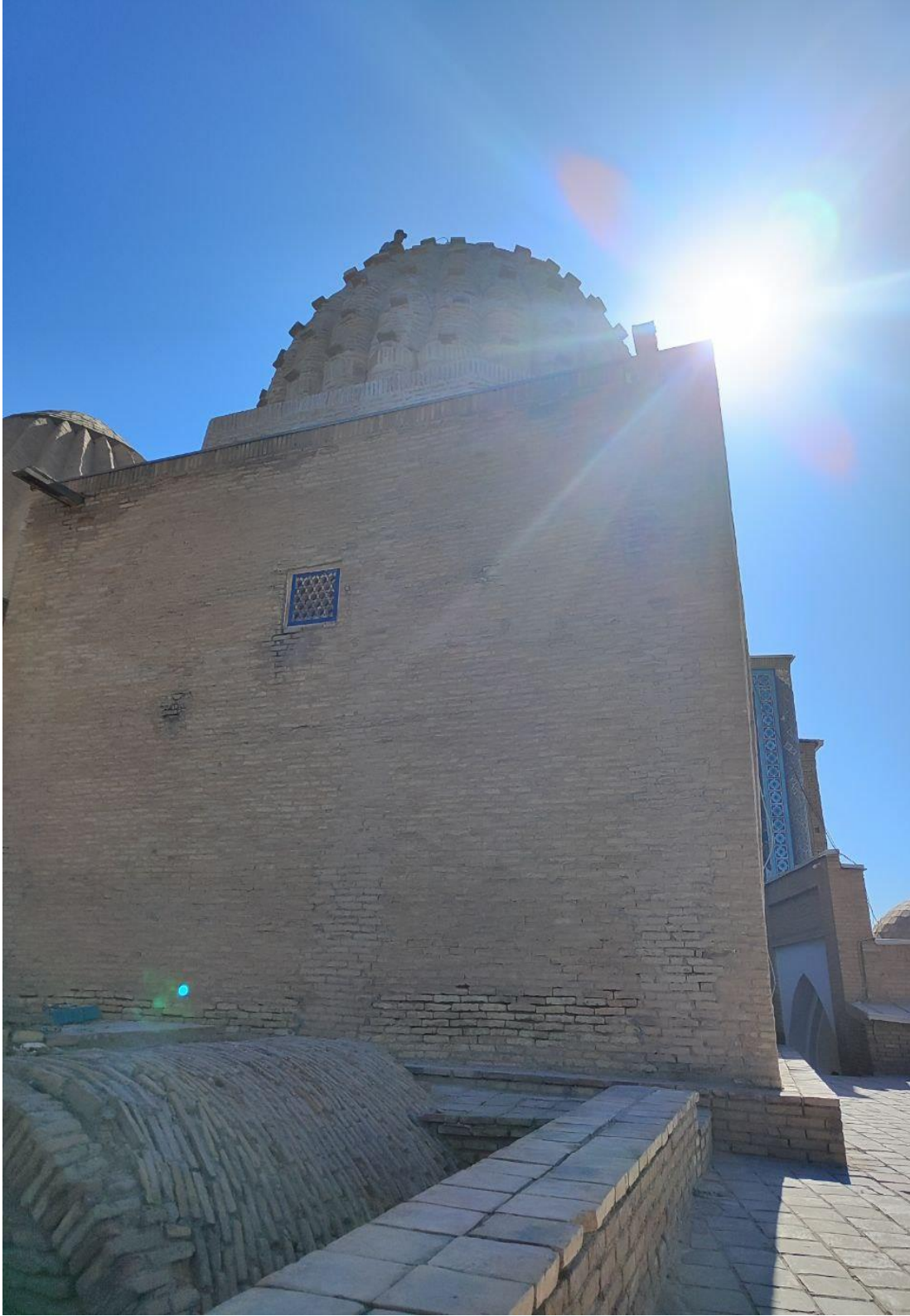
Fotoğraf 4.132: Emir Zade Türbesi Batı Cephe
