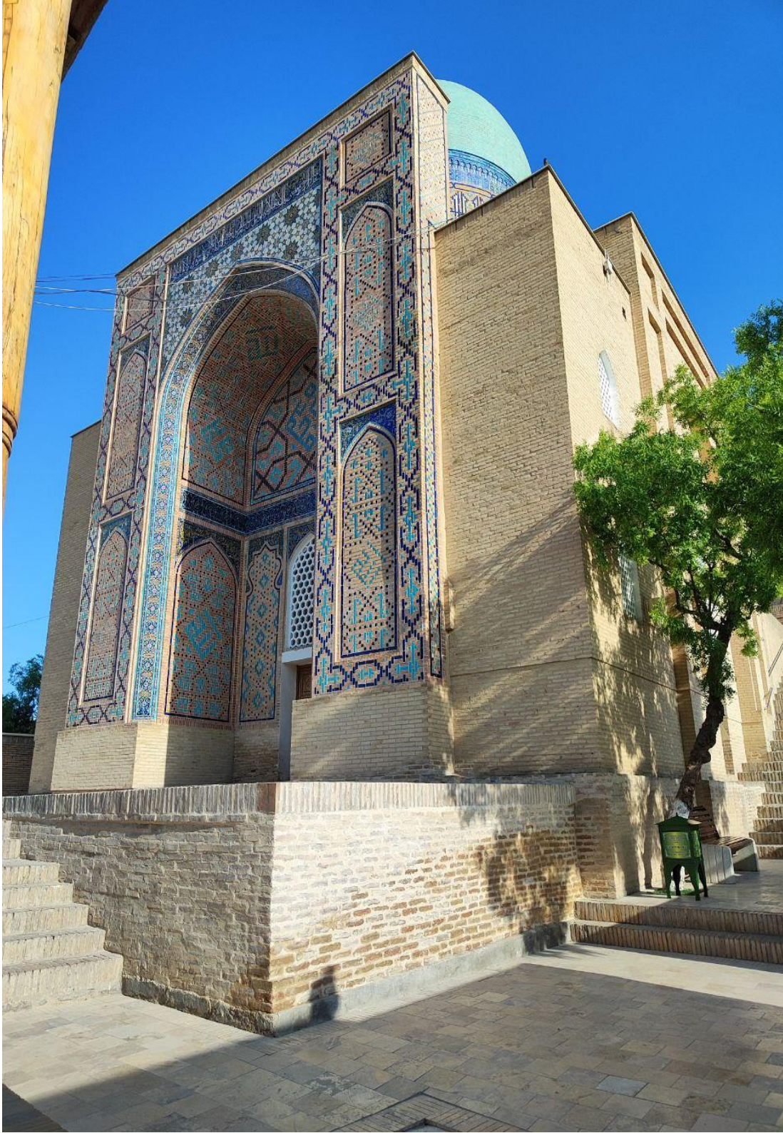
Fotoğraf 4.145: Kadızade-i Rumi Türbesi Güneydoğu Cephe
