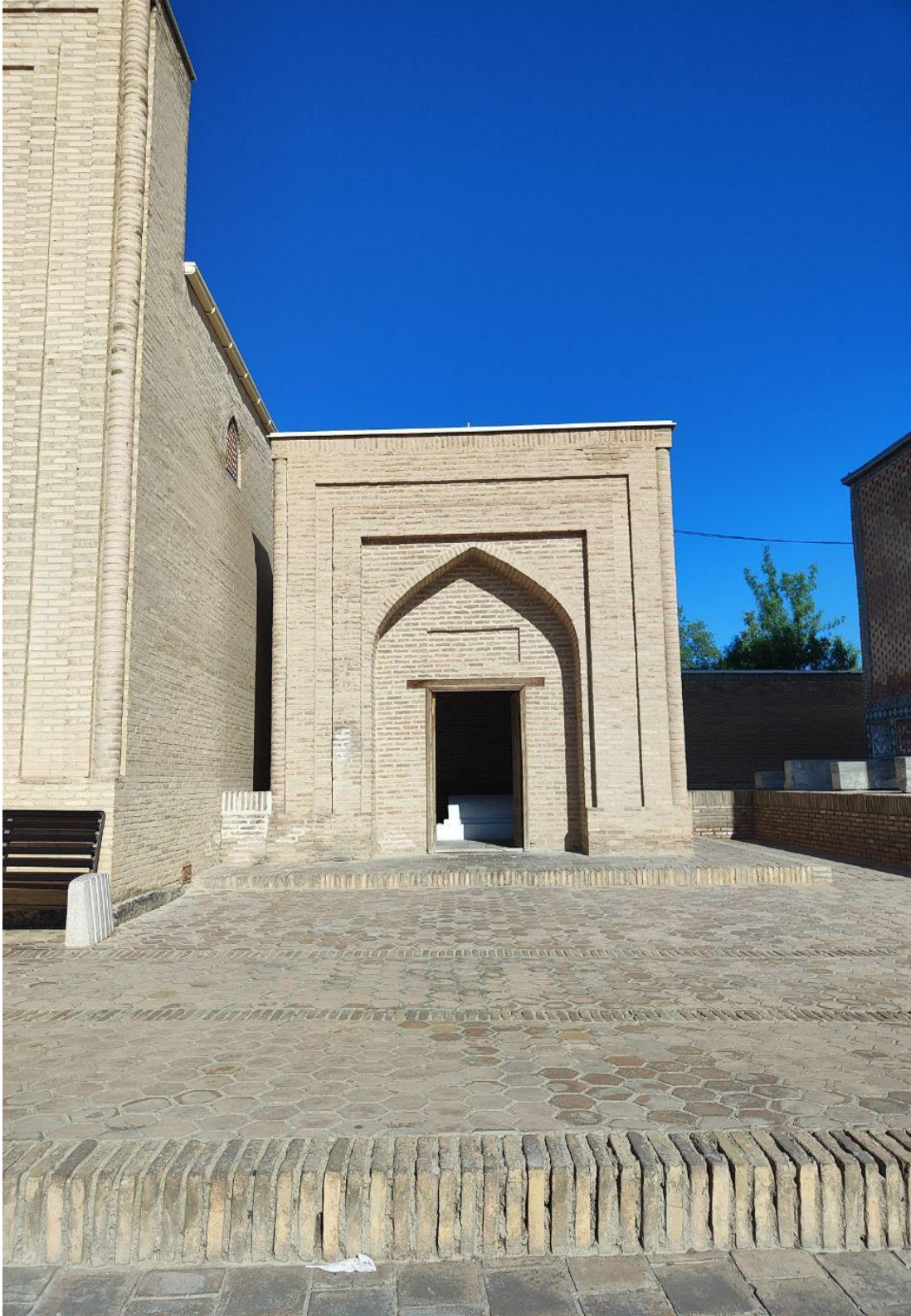
Fotoğraf 4.237: 33 Numaralı Anonim Türbe Doğu Cephe
