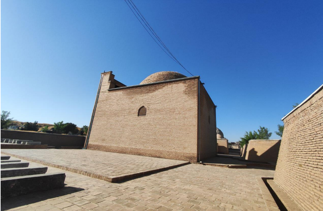
Fotoğraf 4.251: 12 Numaralı Anonim Türbe Kuzey Cephe
