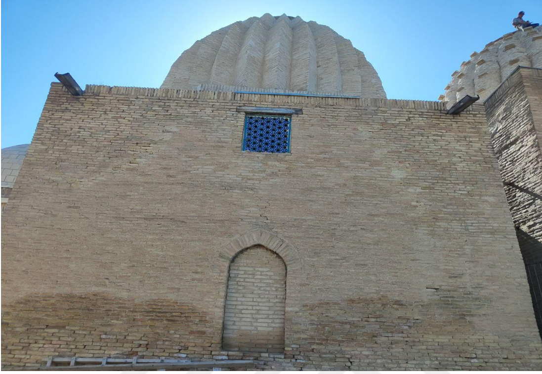
Fotoğraf 4.97: Şad-ı Mülk Türbesi Batı Cephe
