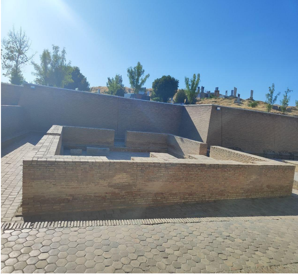
Fotoğraf 4.267: 45 Numaralı Laçın Bey Türbesi Batı Cephesi
