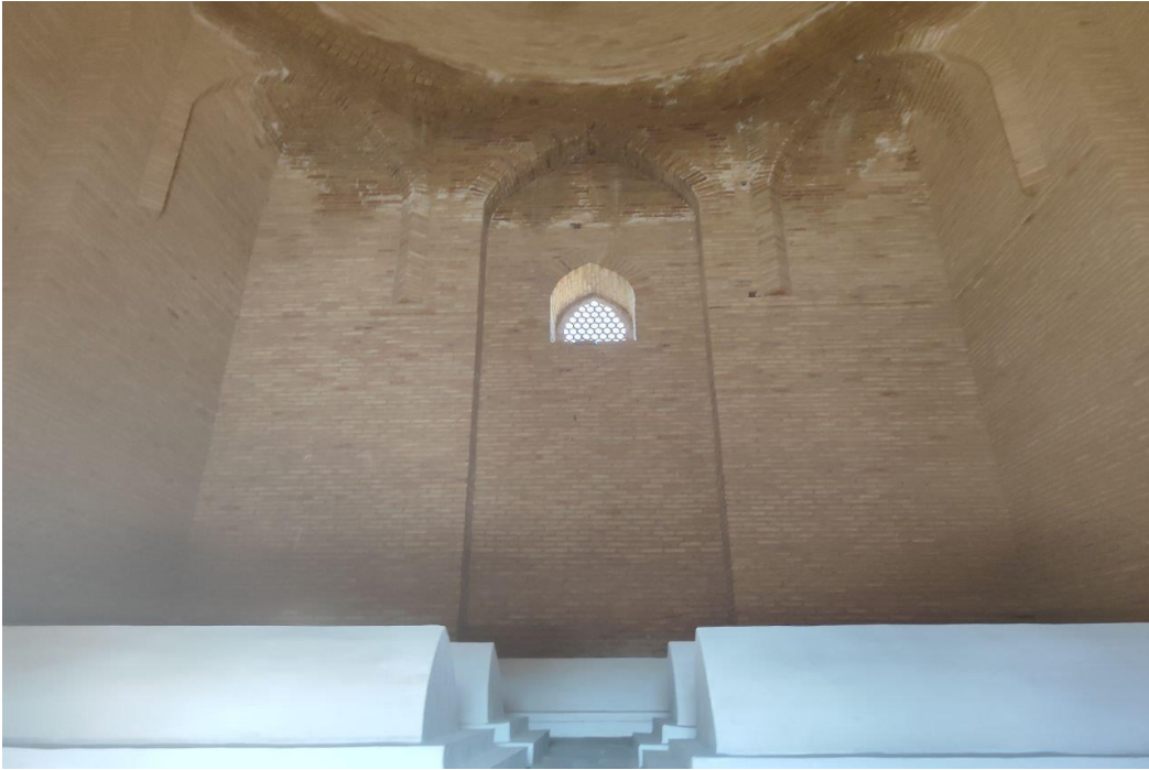
Fotoğraf 4.258: 12 Numaralı Anonim Türbe Batı İç Cephe
