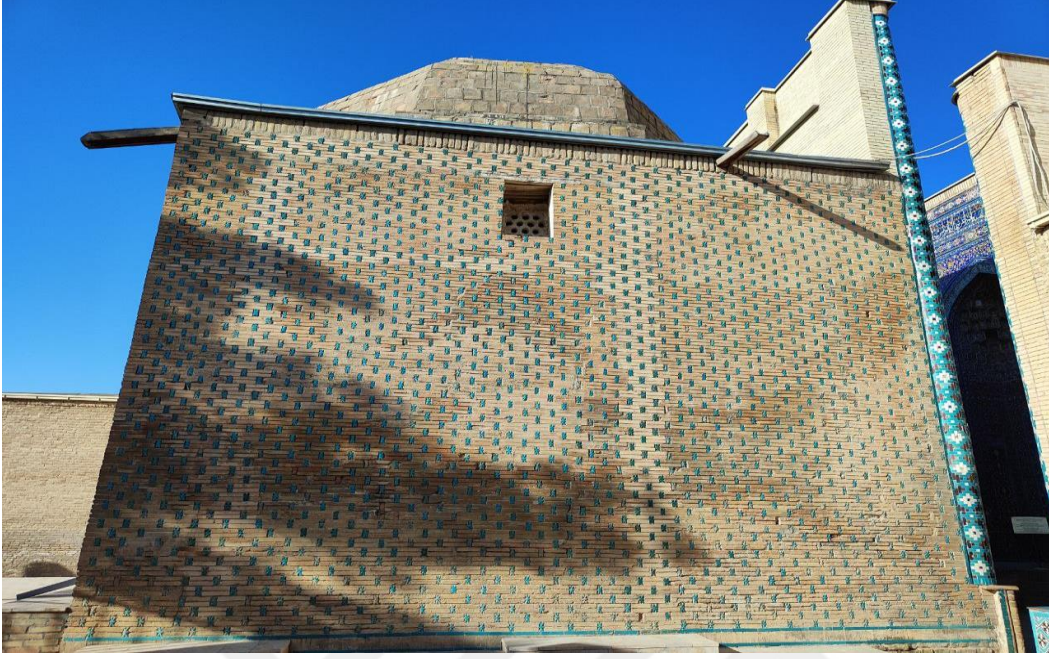
Fotoğraf 4.187: Kutluk Aka Türbe Kuzey Cephe
