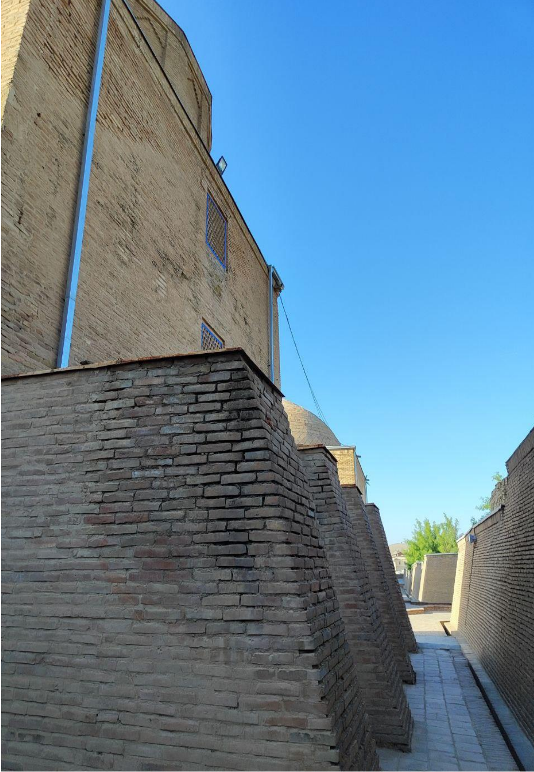
Fotoğraf 4.73: Emir Burunduk Batı Cephesi, Kuzeybatı Köşeden
