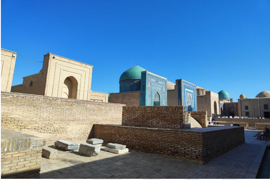
Fotoğraf 4.275: 26 Numaralı Anonim Türbe Kalıntısı Güneydoğu Cephe
