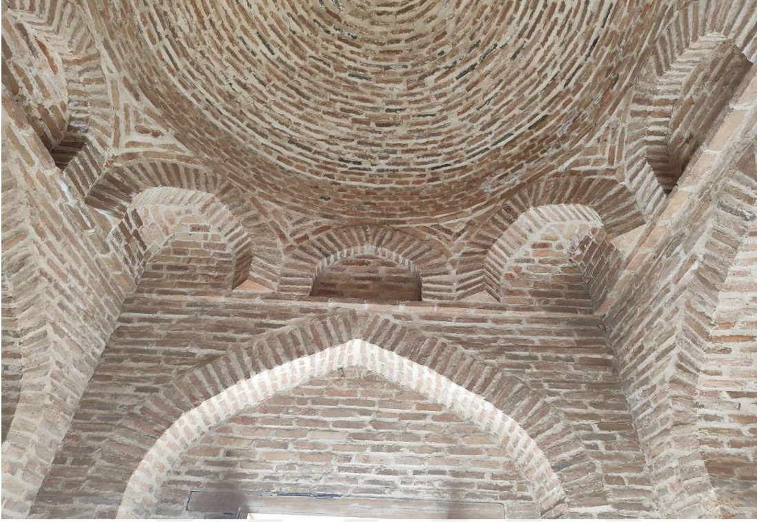
Fotoğraf 4.247: 33 Numaralı Anonim Türbe İç Mekan
