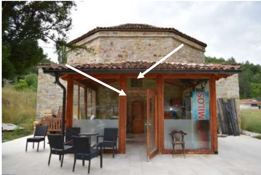
Fotoğraf 215. Novi Pazar Kaplıcası'ndaki Hamam (1593/1594), Ana Cephe
