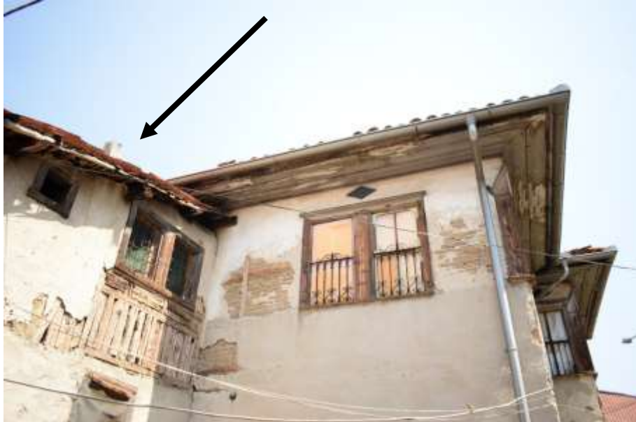
Fotoğraf 256. Hamzagić Konağı (1910), Batı Cephedeki Ek Yapı
