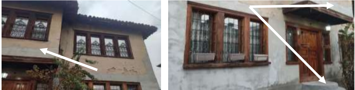
Fotoğraf 270. Šušević Konağı (1912), Ana Cephe
