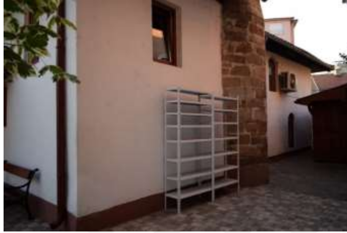
Fotoğraf 101. Çalapverdi Camisi (16. Yüzyıl), Güneybatı Cephe
