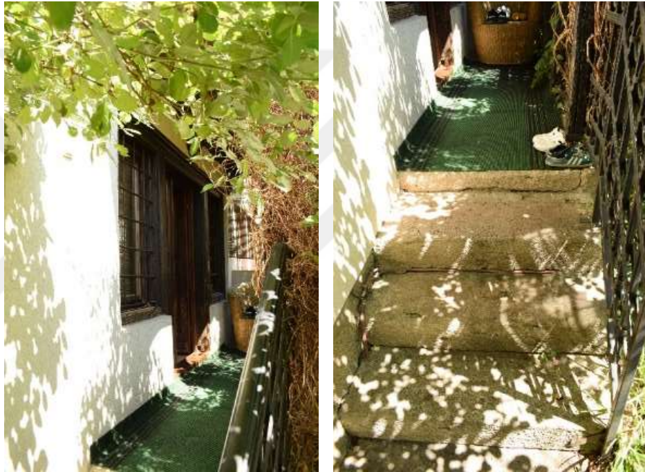
Fotoğraf 235. Gicić Konağı (1902), Ana Cephedeki Giriş Kapısı
