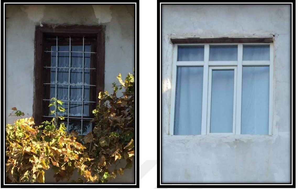
Şekil 4.347. 41 numaralı konutun zemin (solda) ve birinci kat (sağda, PVC ile değiştirilmiş) pencere örnekleri
