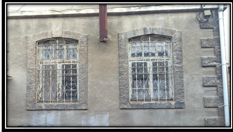
Şekil 4.316. 36 numaralı konutun zemin katında yer alan pencerelerin etrafındaki taş söve ve üzerindeki metal parmaklıklar
