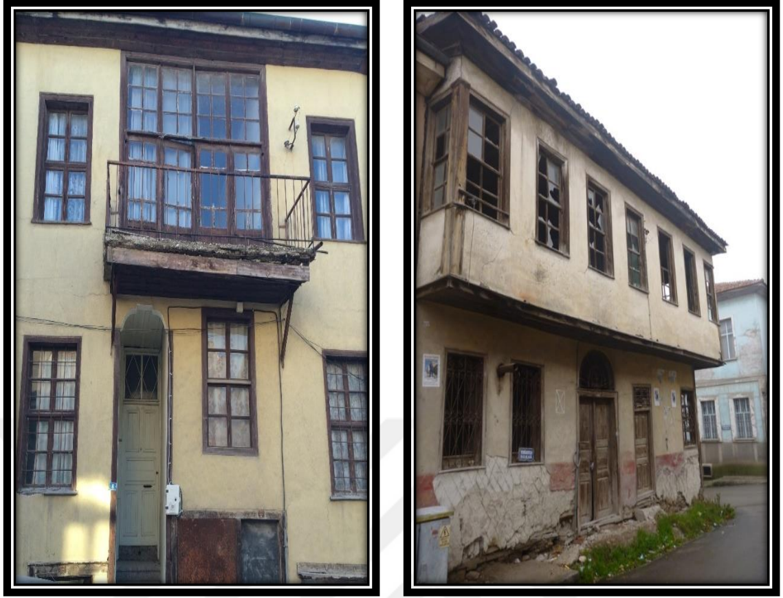
Şekil 4.17. Geleneksel Burdur Evleri'nde ahşap pencere kullanım örnekleri
