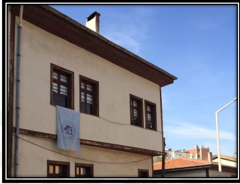
Şekil 4.400. 48 numaralı konut dođu cephesinde yer alan çıkma
