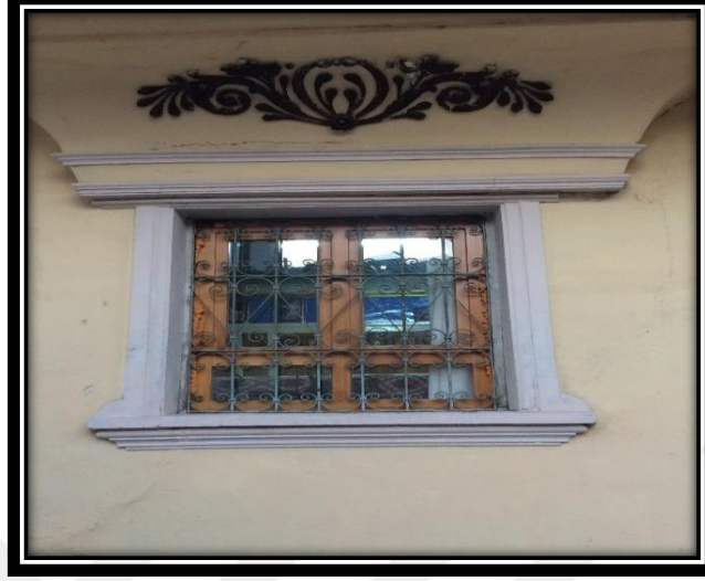
Şekil 4.247. 27 numaralı konutun birinci katında yer alan çıkmanın altında bulunan pencere
