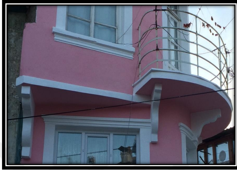
Şekil 4.256. 28 konutun çıkmalarının altında yer alan konsollar
