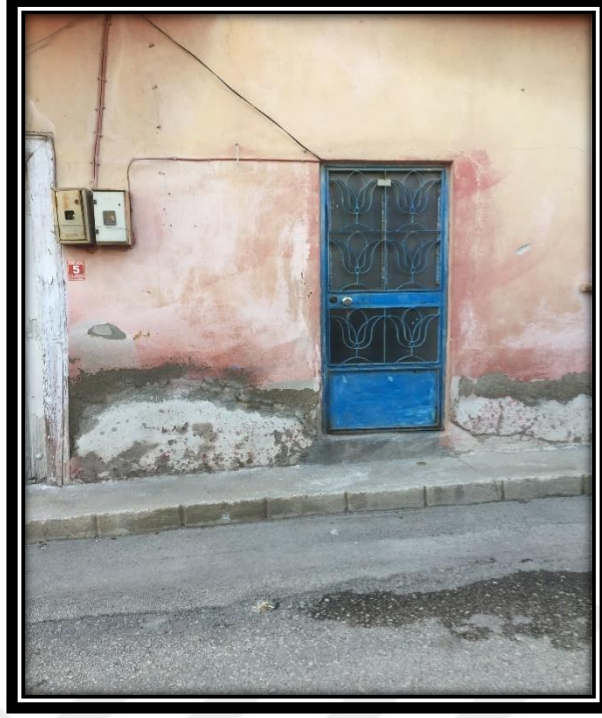
Şekil 4.568. 73 numaralı konutun giriş çıkış sağlayan ikinci kapısı
