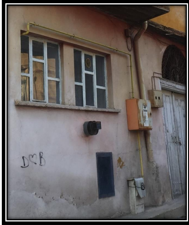
Şekil 4.569. 73 numaralı konutun bodrum ve zemin kat pencere örnekleri
