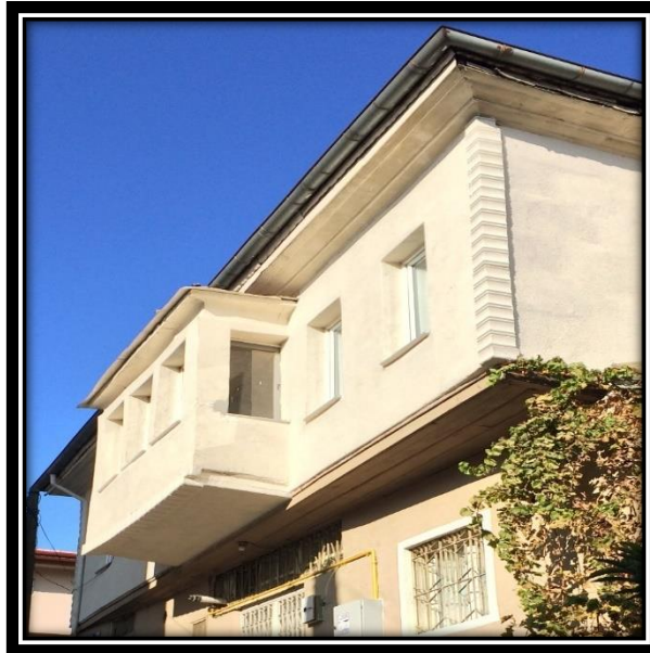
Şekil 4.175. 16 numaralı konutta batı cephesinde yer alan çıkmalar
