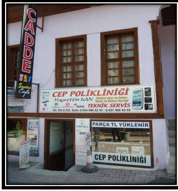
Şekil 4.466. 58 numaralı konutun bodrum ve zemin kat pencere örnekleri
