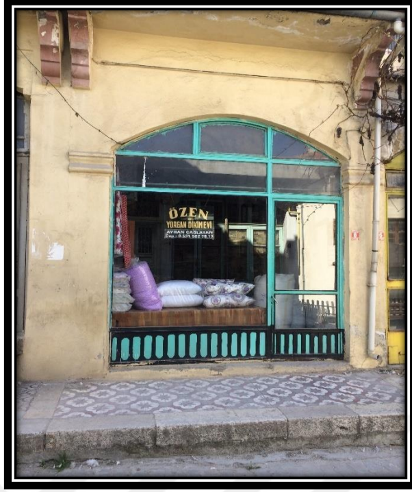
Şekil 4.487. 61 numaralı konutun zemin katında yer alan dükkan
