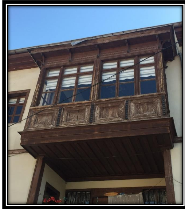
Şekil 4.401. 48 numaralı konut kuzey cephesinde yer alan ahşap çıkma
