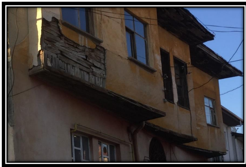
Şekil 4.571. 73 numaralı konutta yer alan kat silmesi
