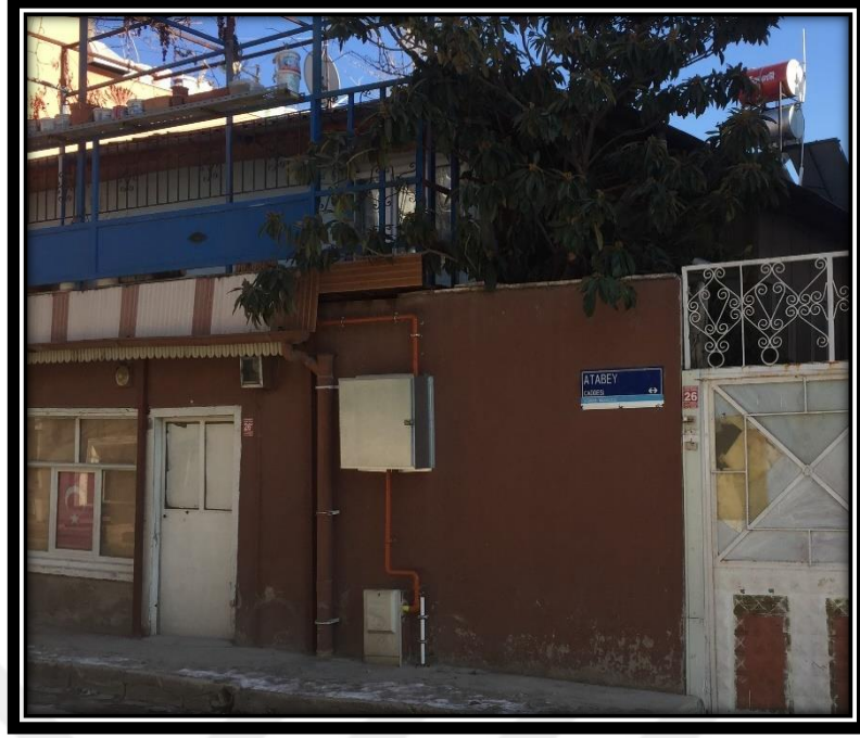
Şekil 4.335. 39 numaralı konut ve yol cephesinde bulunan ek yapısı
