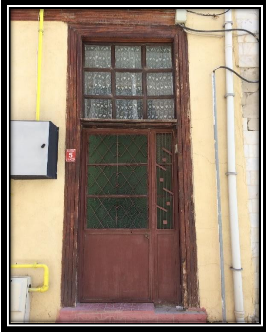
Şekil 4.10. Geleneksel Burdur Evleri'nde demir ve PVC malzeme ile değiştirilmiş konut giriş kapısı örnekleri
