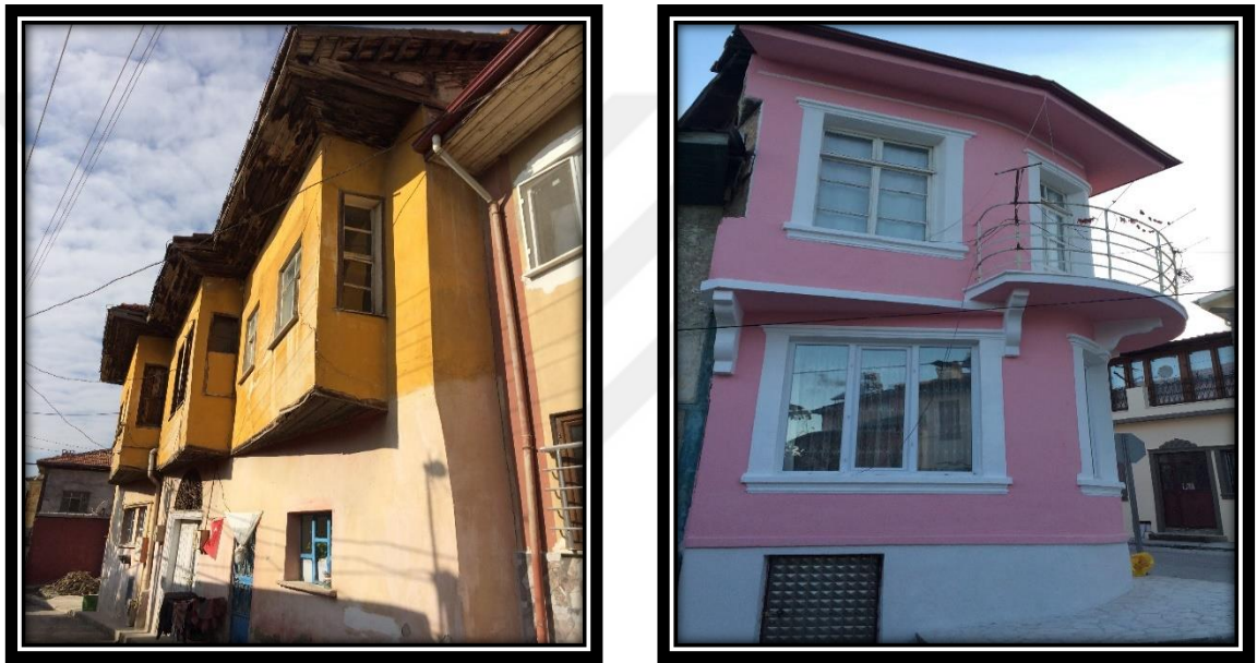
Şekil 4.33. Geleneksel Burdur Evleri'nde gönyeli çıkma örnekleri
