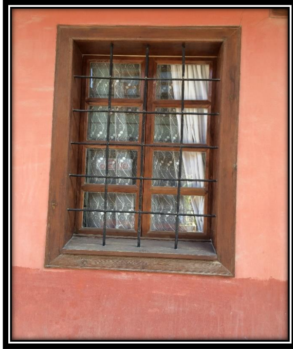
Şekil 4.448. 55 numaralı konutun zemin kat pencere örneği
