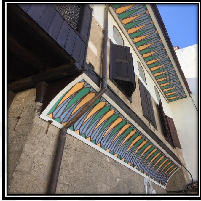
Şekil 4.63. 1 numaralı konutta çıkmanın ve saçığın altında yer alan bezemeler
