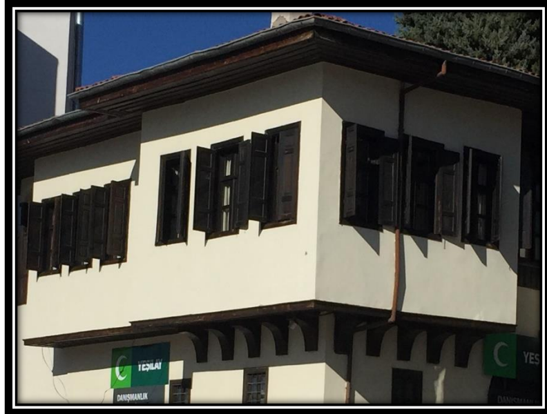
Şekil 4.71. 2 numaralı konutun güney cephesinde yer alan çıkmalar
