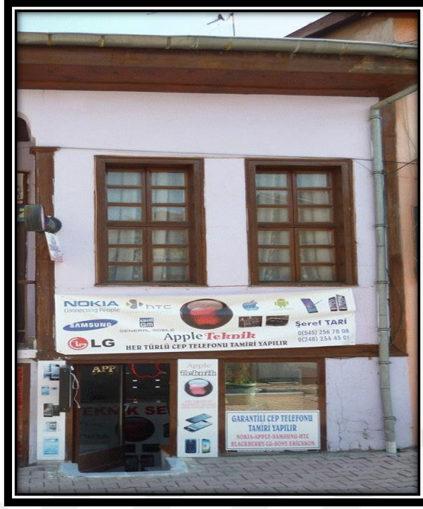
Şekil 4.461. 57 numaralı konutun bodrum ve zemin kat pencere örnekleri
