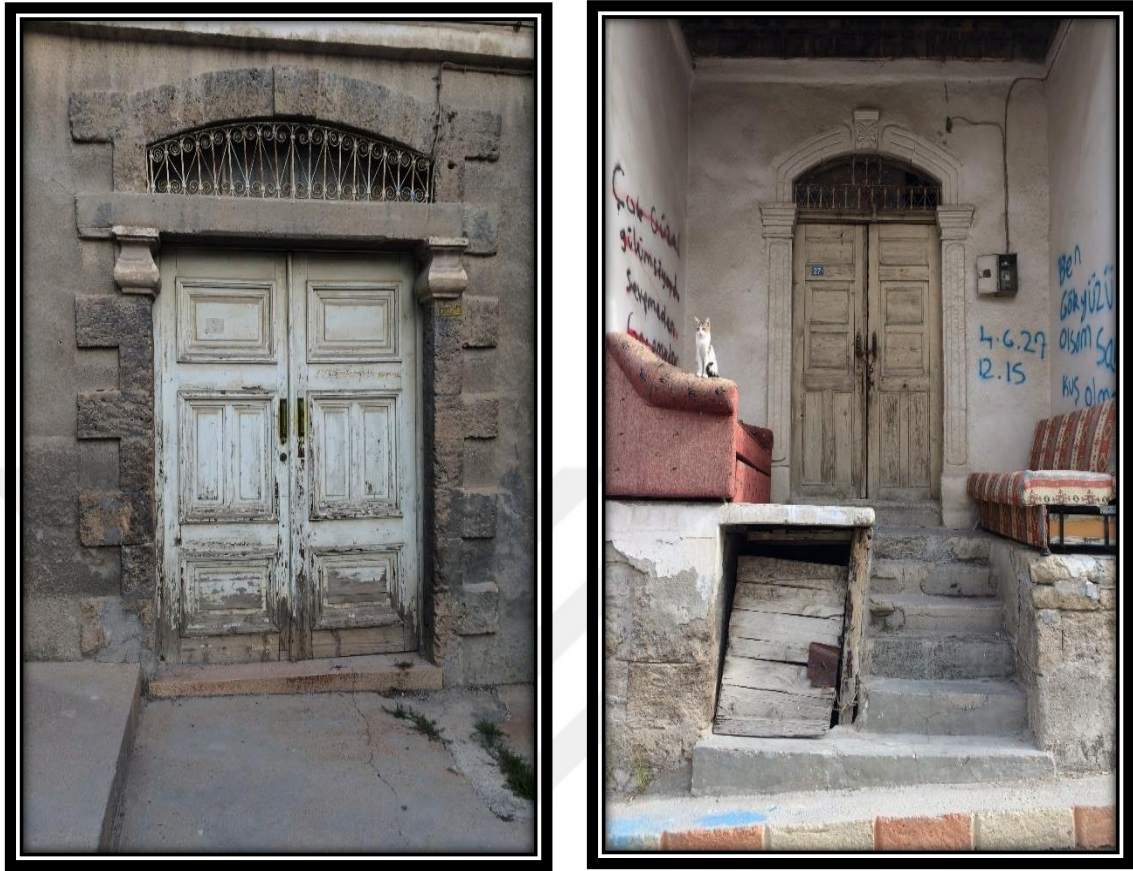
Şekil 4.49. Kapı etrafında yer alan söve örnekleri
