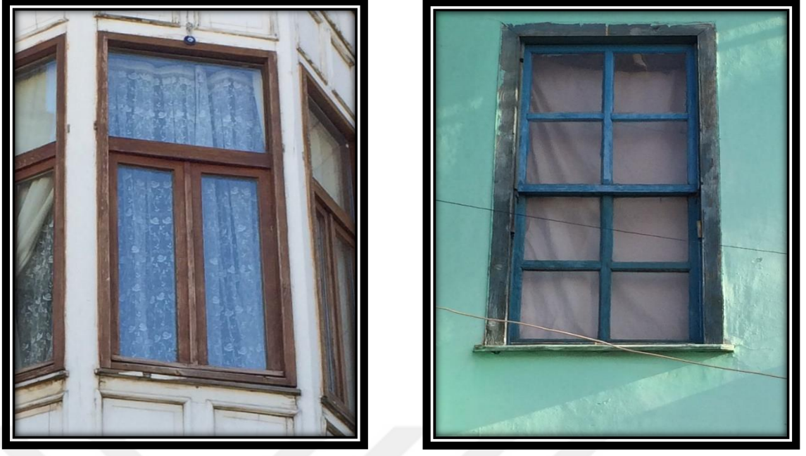
Şekil 4.20. Geleneksel Burdur Evleri’nden kanatlı (solda) ve giyotin (sağda) pencere örnekleri
