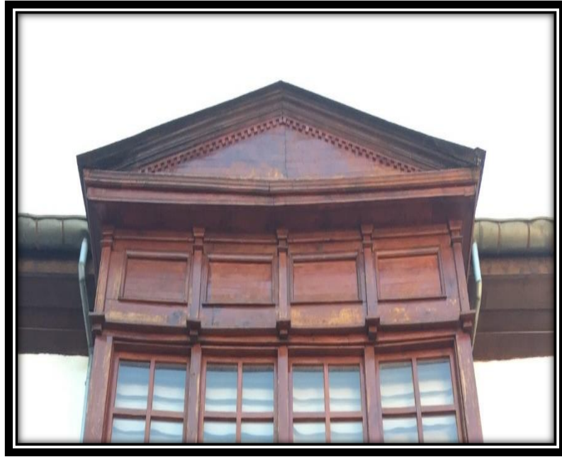
Şekil 4.388. 46 numaralı konutun üçgen alınlıklı çatısının kenarlarındaki ahşap dişli motifler
