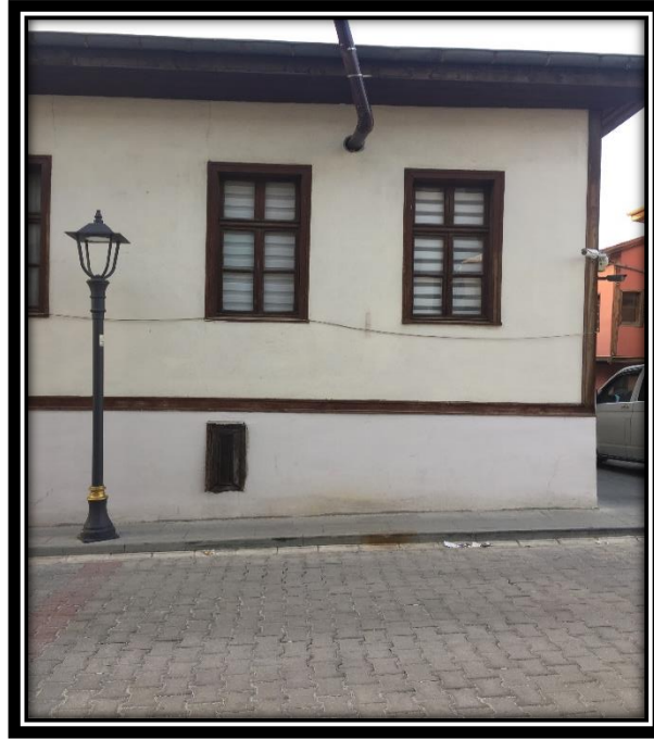
Şekil 4.427. 52 numaralı konutun bodrum ve zemin kat pencere örnekleri
