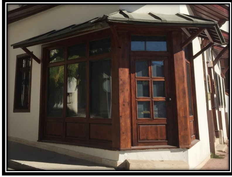
Şekil 4.93. 5 numaralı konutun köşe kısmındaki dükkan
