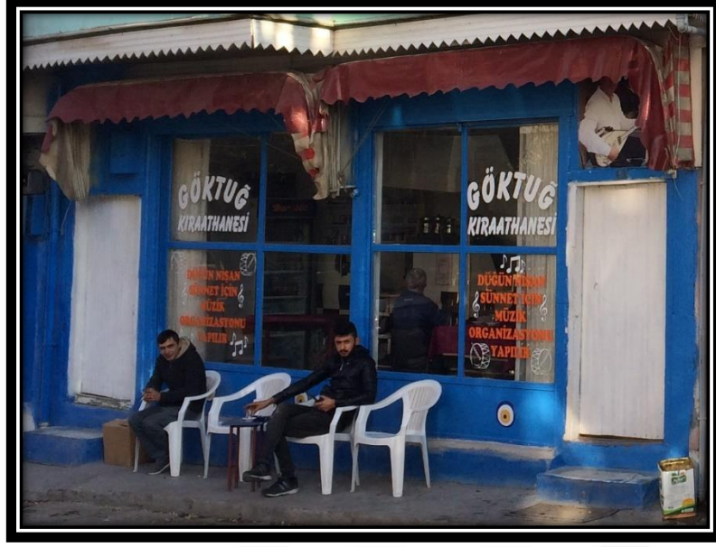
Şekil 4.321. 37 numaralı konutun zemin katında yer alan dükkan
