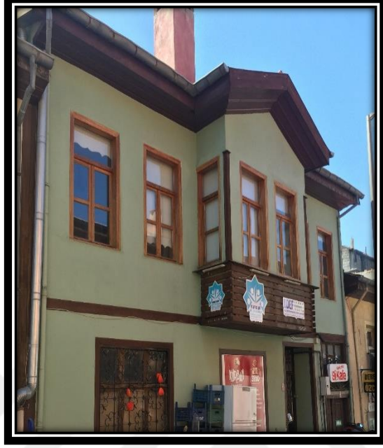
Şekil 4.45. Cephe yüzeyindeki girintileri takip eden saçak örneği
