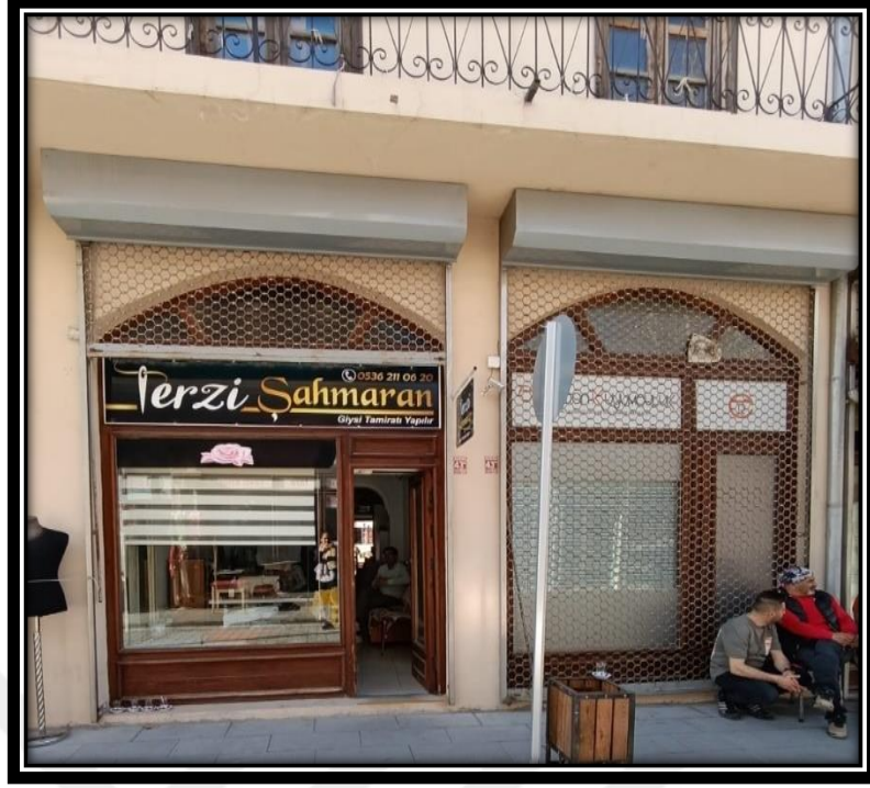
Şekil 4.520. 66 numaralı konutun zemin katında yer alan dükkan
