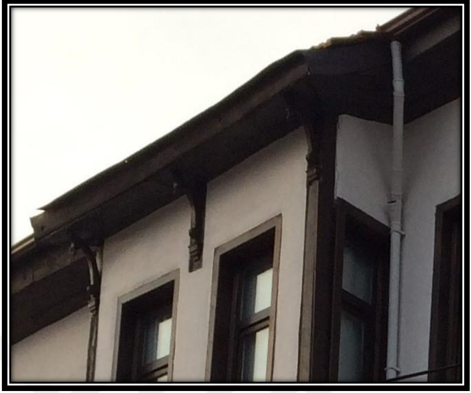
Şekil 4.309. 35 numaralı konutun güney cephesindeki çıkmanın saçak altındaki furuşları
