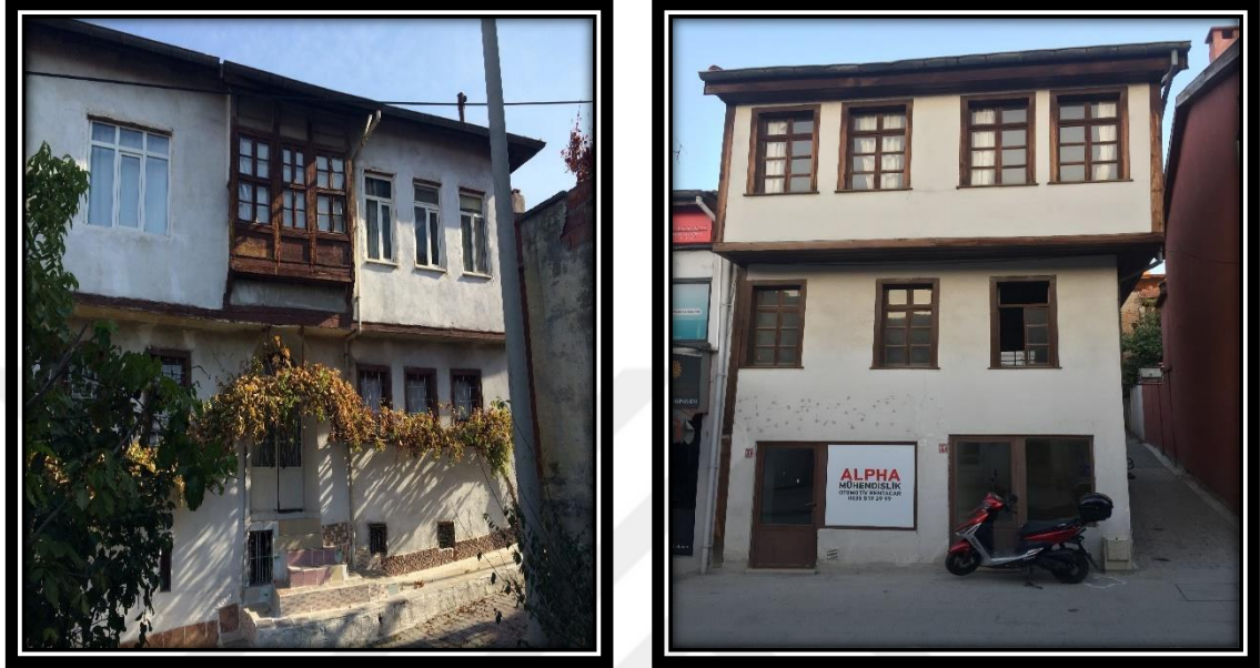
Şekil 4.22. Geleneksel Burdur Evleri'nde 1. katta (sağda) ve 2. katta (solda) yer alan çıkma örnekleri
