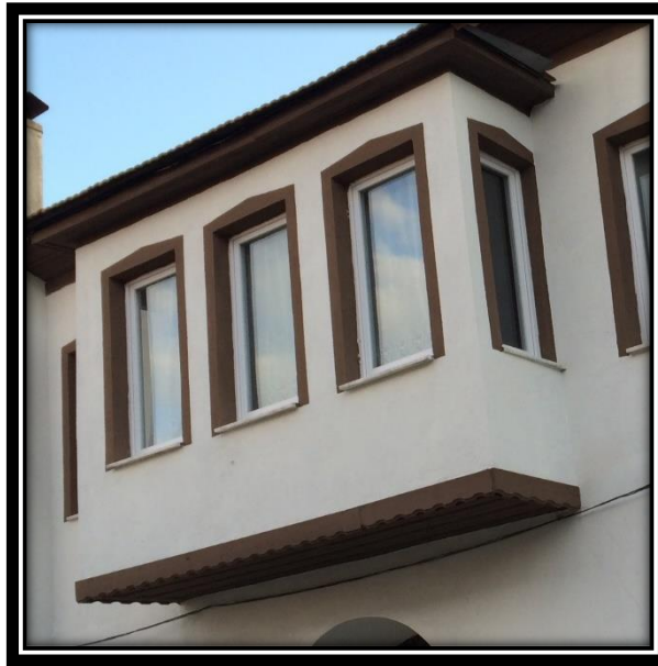
Şekil 4.150. 13 numaralı konutun kuzey cephesinde yer alan çıkma
