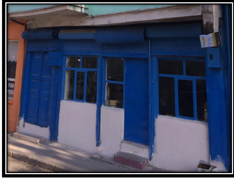
Şekil 4.328. 38 numaralı konutun zemin katında yer alan dükkan
