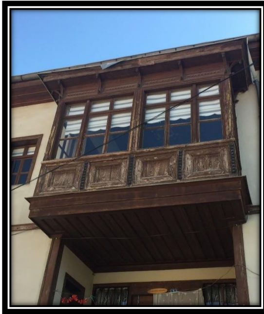
řekil 4.36. Geleneksel Burdur Evleri'nde konsol örneklere
