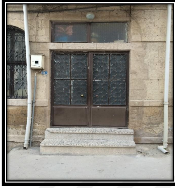
Şekil 4.282. 32 numaralı konutun giriş çıkış sağlayan ikinci kapısı
