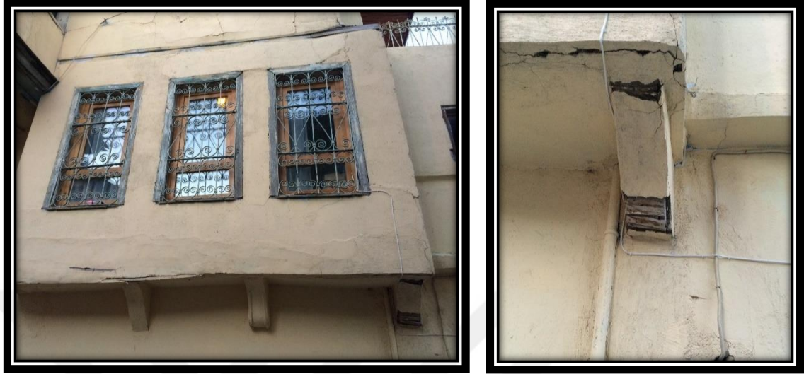
Şekil 4.37. Yüzeyi sıvalı konsol örneđi
