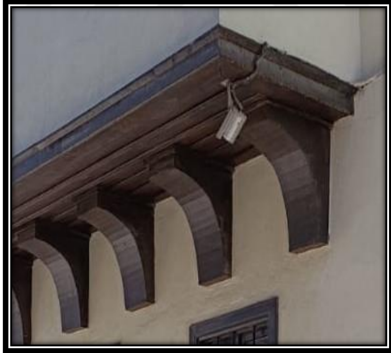
Şekil 4.73. 2 numaralı konutun çıkma altında yer alan ahşap konsollar
