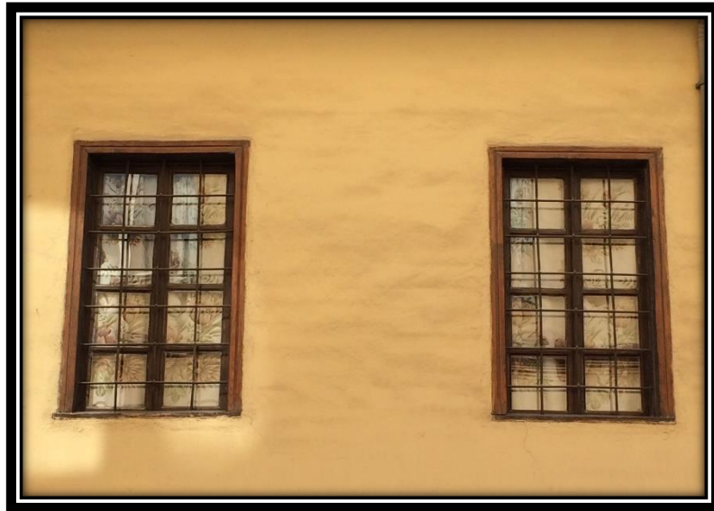
Şekil 4.161. 14 numaralı konutun zemin kat pencerelerinin bazılarının üzerinde yer alan metal parmaklıklar
