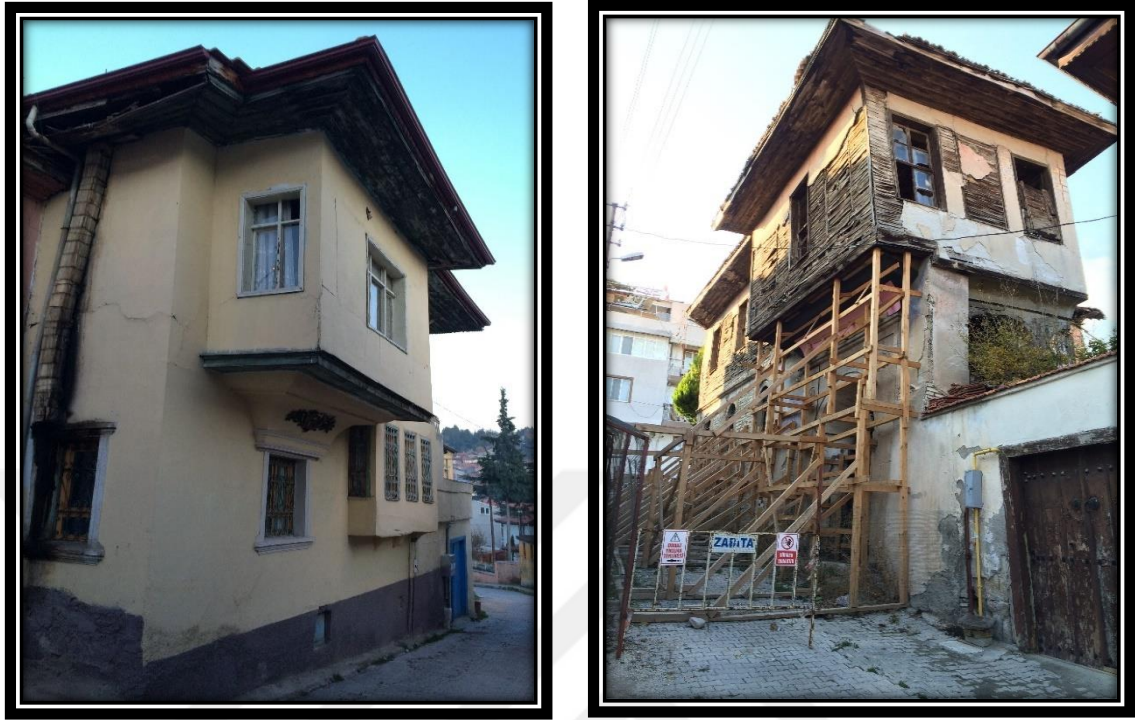
Şekil 4.43. Geleneksel Burdur Evleri'nde saçaklı cephe örnekleri
