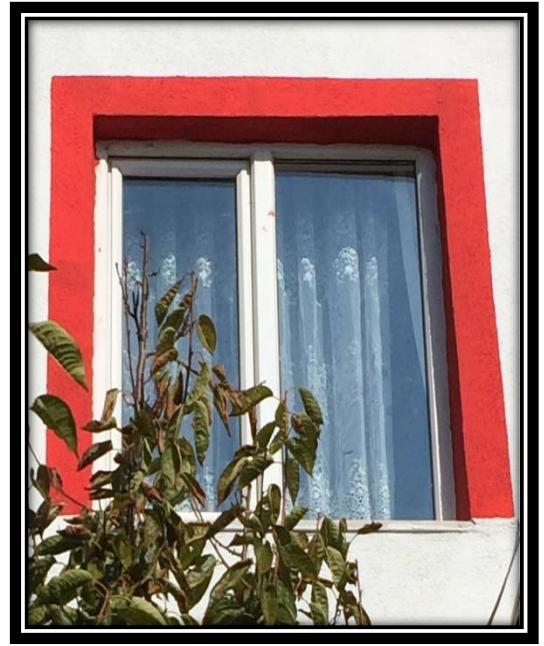
Şekil 4.116. 8 numaralı konutun zemin (solda) ve birinci kat (sağda) PVC malzeme ile değiştirilmiş pencere örnekleri
