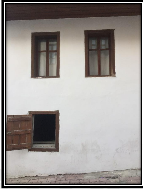
Şekil 4.420. 51 numaralı konutun bodrum ve zemin kat pencere örnekleri
