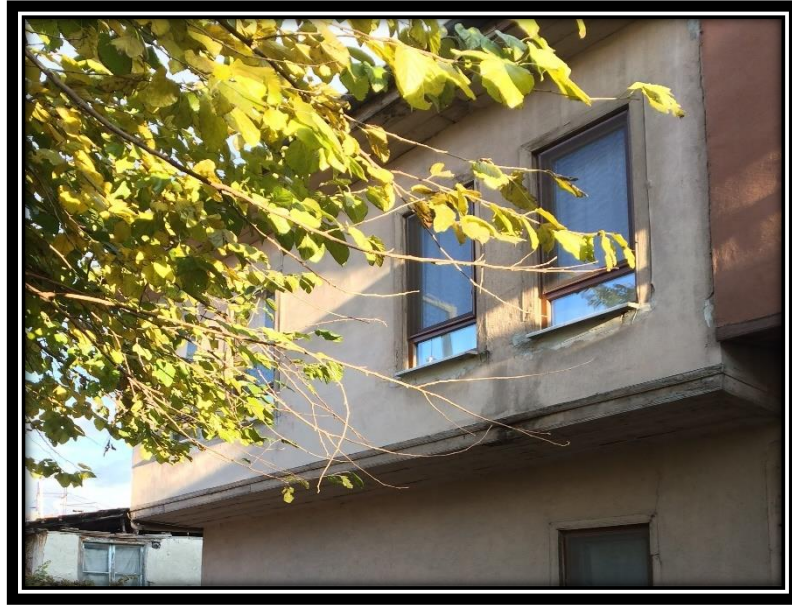
Şekil 4.210. 21 numaralı konutun doğu cephesinde yer alan çıkma
