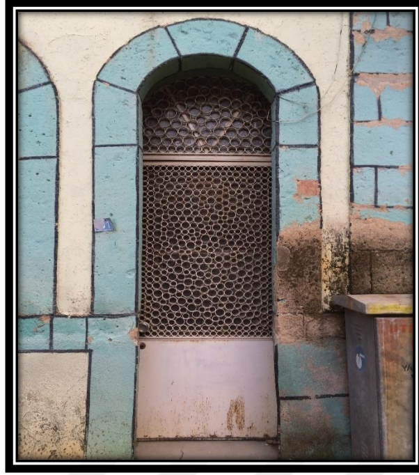
Şekil 4.216. 22 numaralı konutun giriş çıkış sağlayan ikinci kapısı
