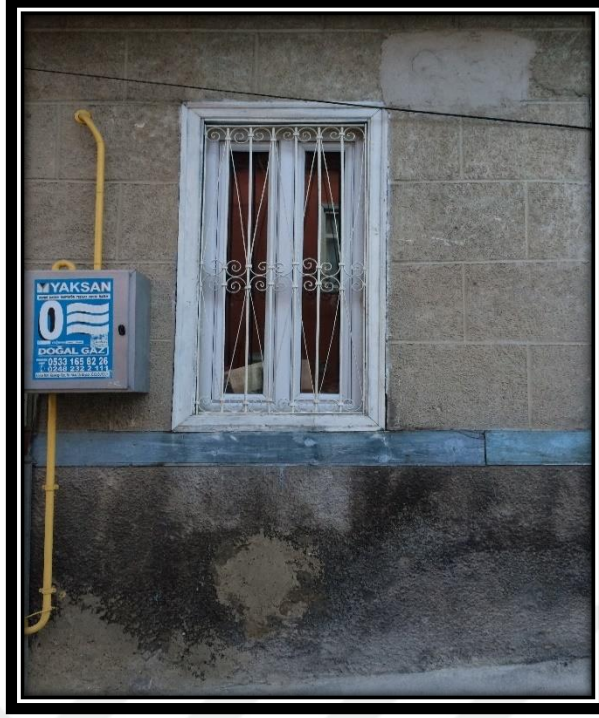
Şekil 4.261. 29 numaralı konutun zemin katında yer alan pencere örneği
