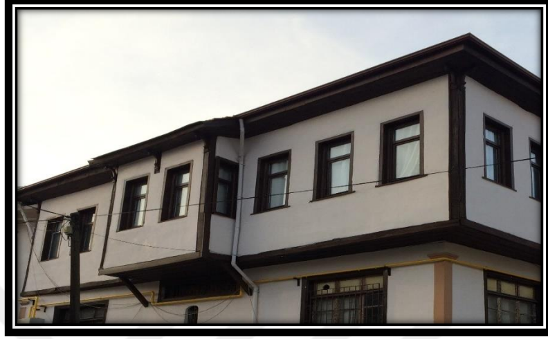
Şekil 4.307. 35 numaralı konutun güney cephesinde yer alan çıkması
