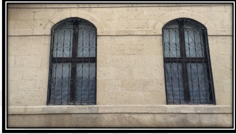
Şekil 4.286. 32 numaralı konutun zemin kat pencerelerinin üst ve alt kısmındaki taş söveler ve üzerindeki metal parmaklıklar
