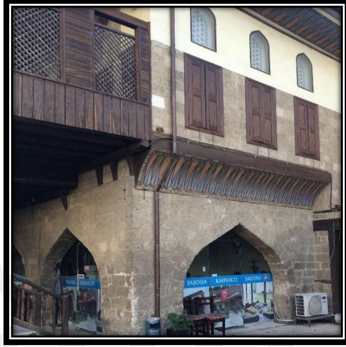
Şekil 4.61. 1 numaralı konutun kuzey cephesinde yer alan zemin ve birinci kat pencereleri
