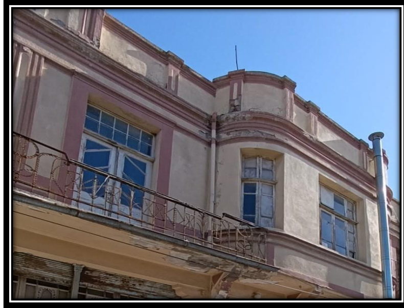
Şekil 4.494. 62 numaralı konutta yer alan açık ve kapalı çıkma
