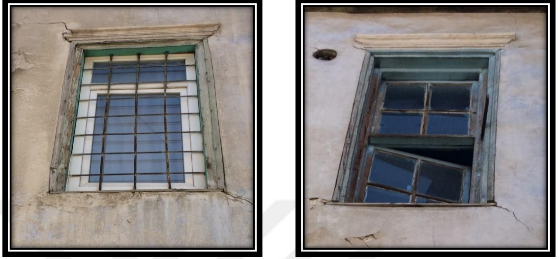
Şekil 4.363. 43 numaralı konutun birinci (solda, PVC ile değiştirilmiş) ve ikinci kat (sağda) pencere örnekleri
