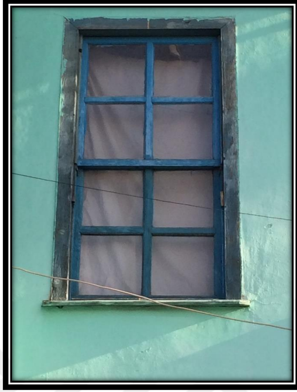
Şekil 4.323. 37 numaralı konutun birinci katında yer alan pencere örneği
