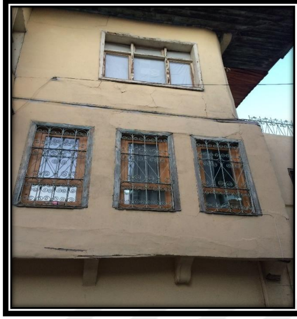
Şekil 4.245. 27 numaralı konutta yer alan zemin kattan başlayarak birinci katta devam eden çıkma
