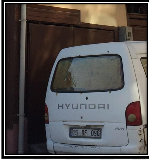
Şekil 4.165. 15 numaralı konutun onarım esnasında kapıya dönüştürülen penceresi
