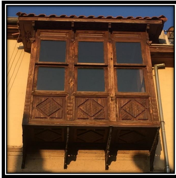
Şekil 4.416. 50 numaralı konutta yer alan çıkmanın üzerindeki cephe süsleme örnekleri
