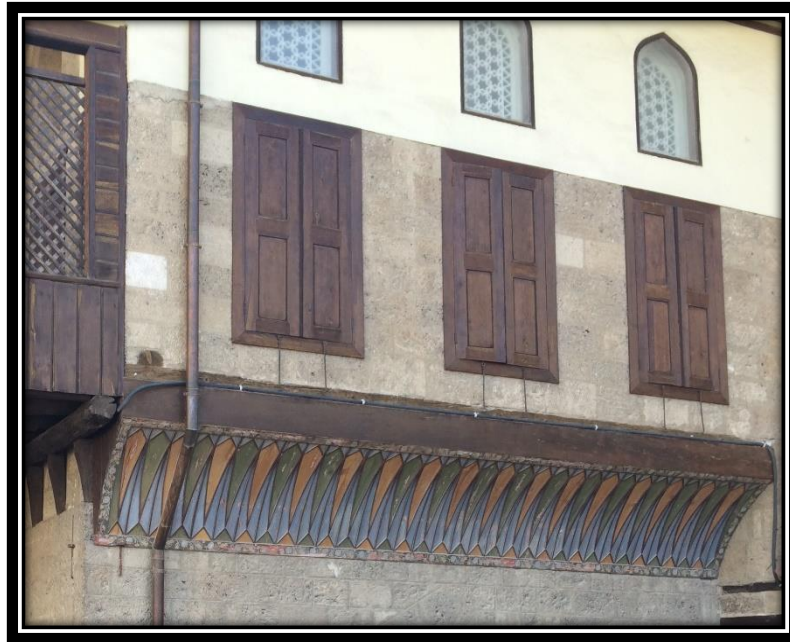
Şekil 4.64. 1 numaralı konutun birinci katındaki pencerelerin üzerindeki ahşap kepenkler
