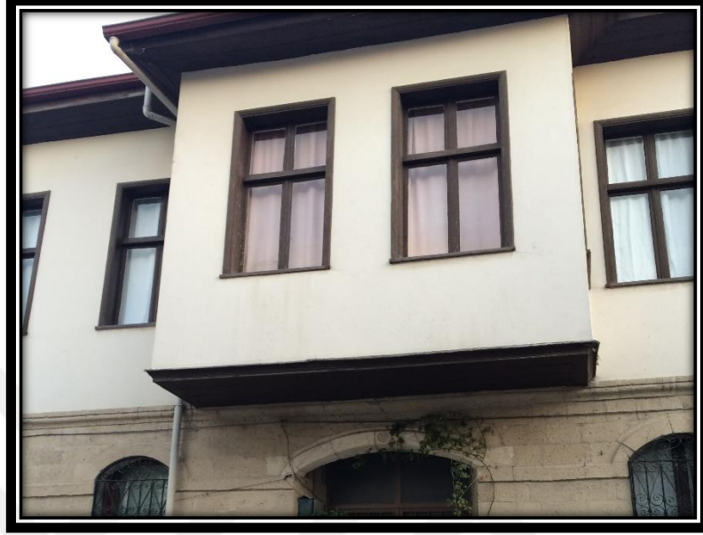
Şekil 4.284. 32 numaralı konutun batı cephesinde ana giriş kapısı üzerinde yer alan çıkması
