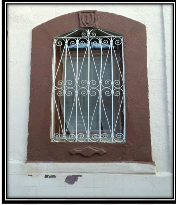
Şekil 4.235. 25 numaralı konutun zemin kat pencere örneği
