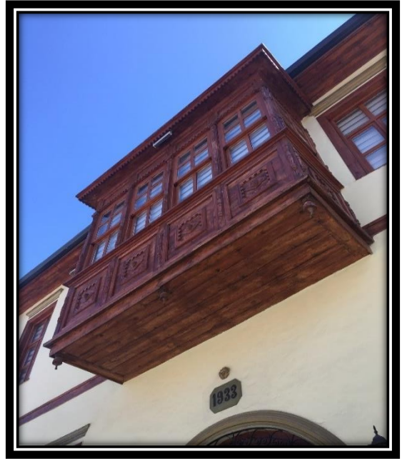
řekil 4.36. Geleneksel Burdur Evleri'nde konsol örneklere
