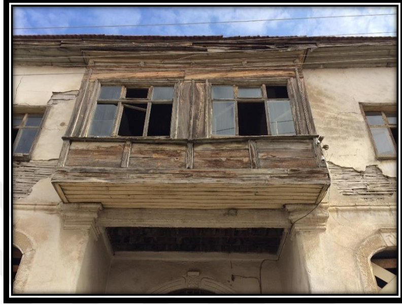
Şekil 4.561. 72 numaralı konutun güney cephesinde yer alan çıkması
