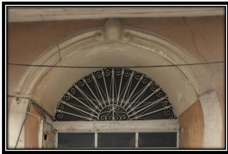
Şekil 4.132. 10 numaralı konutun giriş kapısının üzerindeki söve
