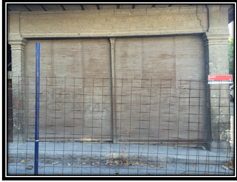
Şekil 4.354. 42 numaralı konutun zemin katında yer alan dükkan
