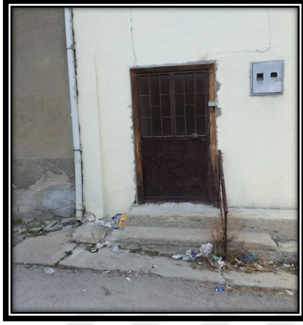
Şekil 4.369. 44 numaralı konutun güney cephesinde zemin kata sokaktan giriş çıkış sağlayan kapısı
