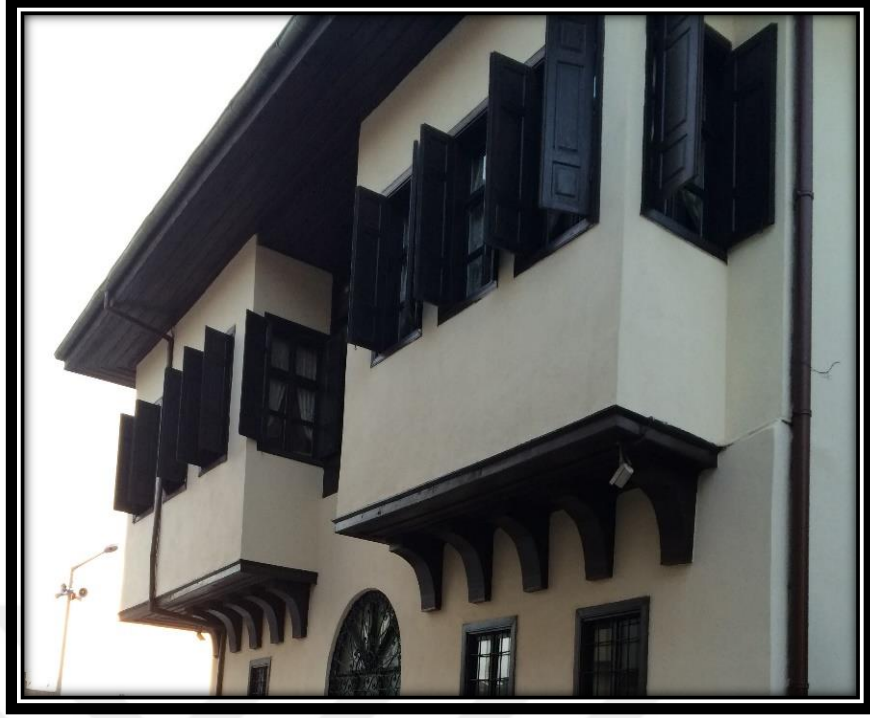
Şekil 4.72. 2 numaralı konutun doğu cephesinde yer alan çıkmalar Çıkmalarda ahşap konsollarla taşınır (Şekil 4.73).
