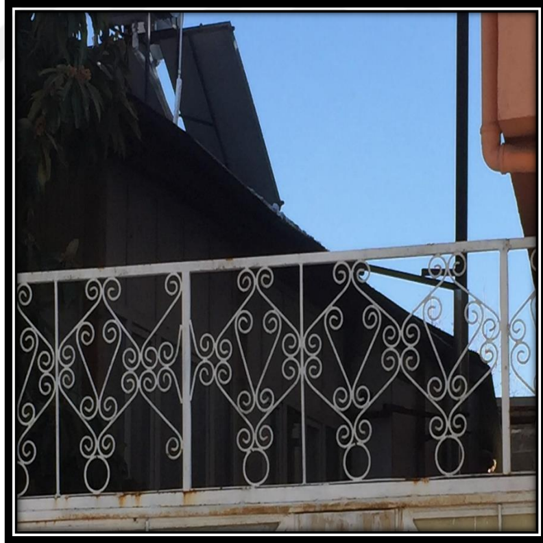
Şekil 4.336. 39 numaralı konutun onarım esnasında kapatılan dış sofası
