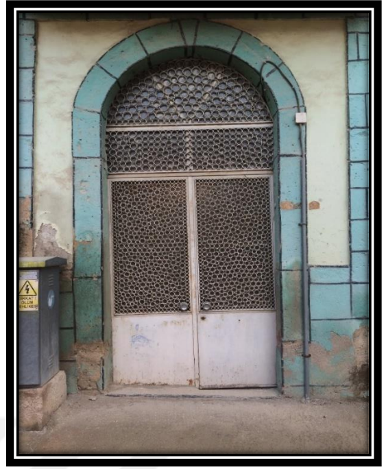
Şekil 4.9. Geleneksel Burdur Evleri'nde ahşap ve demir malzemeli giriş kapısı örnekleri
