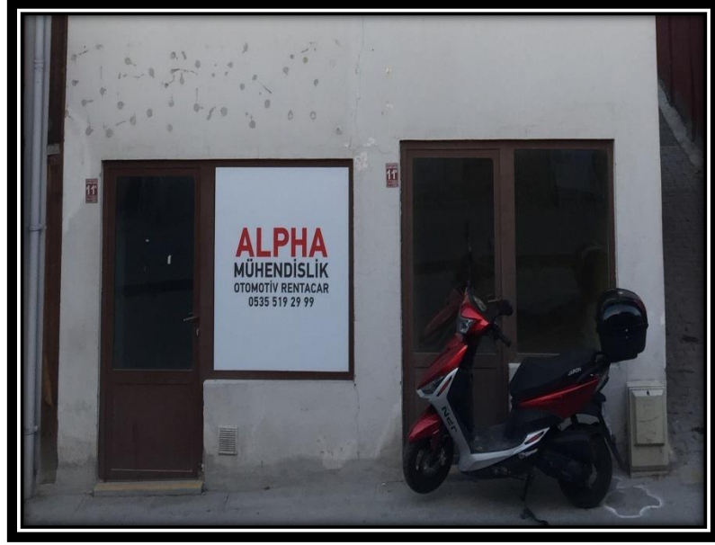
Şekil 4.454. 56 numaralı konutun zemin katında yer alan dükkan
