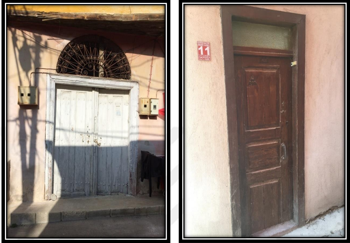
Şekil 4.11. Geleneksel Burdur Evleri çift ve tek kanatlı konut giriş kapısı örnekleri
