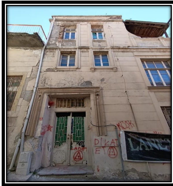
Şekil 4.502. 63 numaralı konutun dođu cephesinde ana giriş kapısının yer aldığı kısım
