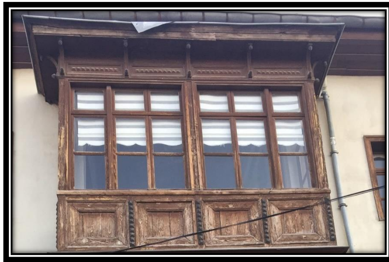
Şekil 4.403. 48 numaralı konutta kuzey cephesinde yer alan ahşap çıkmanın cephe süsleme örnekleri
