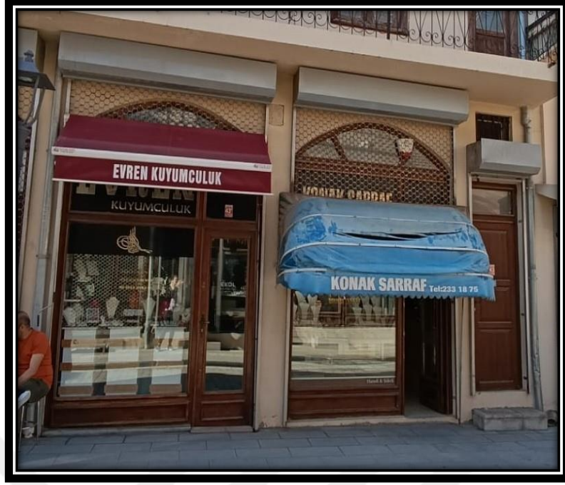
Şekil 4.514. 65 numaralı konutun zemin katında yer alan dükkan
