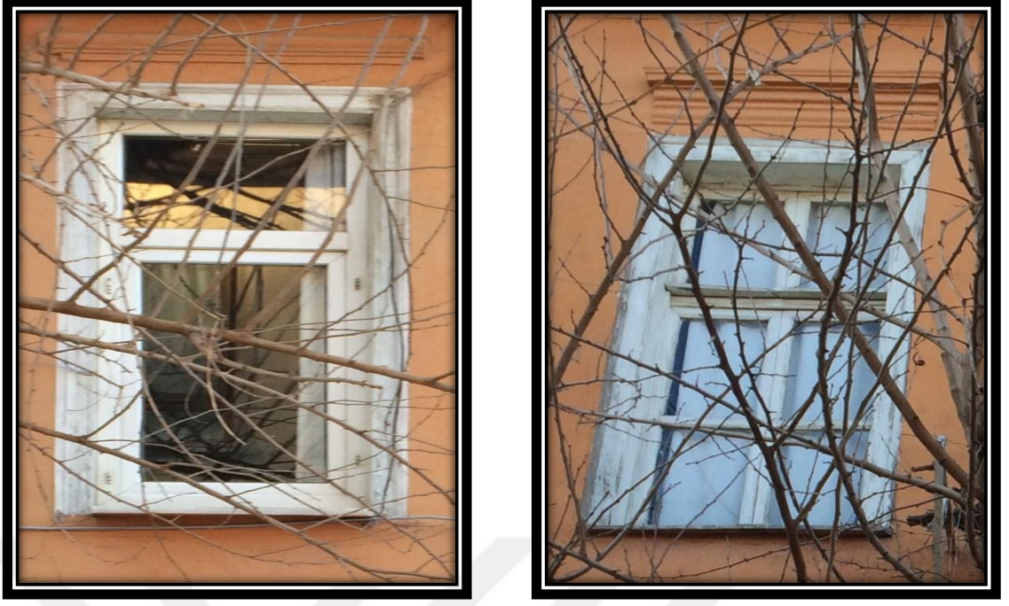
Şekil 4.202. 20 numaralı konutun zemin (solda, PVC ile değiştirilmiş) ve birinci kat (sağda) pencere örnekleri
