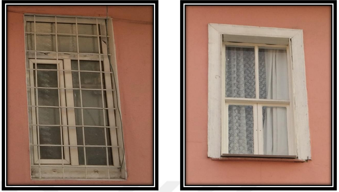
Şekil 4.340. 40 numaralı konutun zemin (solda, PVC ile değiştirilmiş) ve birinci kat (sağda) pencere örnekleri
