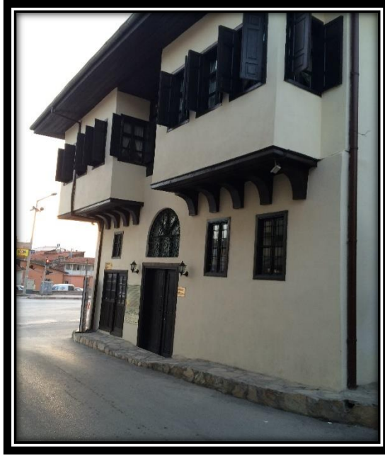
Şekil 4.53. Geleneksel Burdur Evleri'nde ahşap kepenk örnekleri
