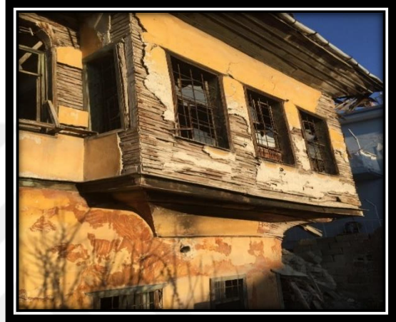
Şekil 4.31. Geleneksel Burdur Evleri'nde düz formlu çıkma örnekleri
