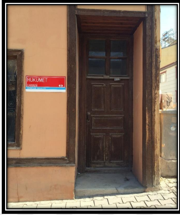
Şekil 4.439. 54 numaralı konutun giriş çıkış sağlayan ikinci kapısı
