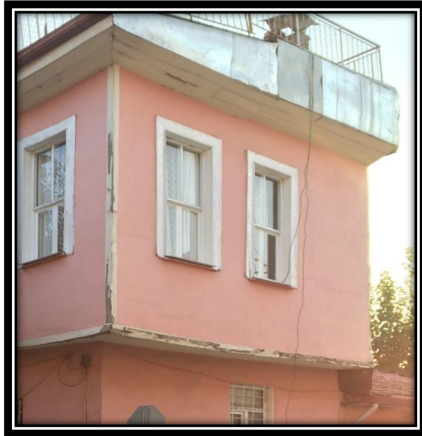
Şekil 4.341. 40 numaralı konutun kuzey cephesinde yer alan çıkması
