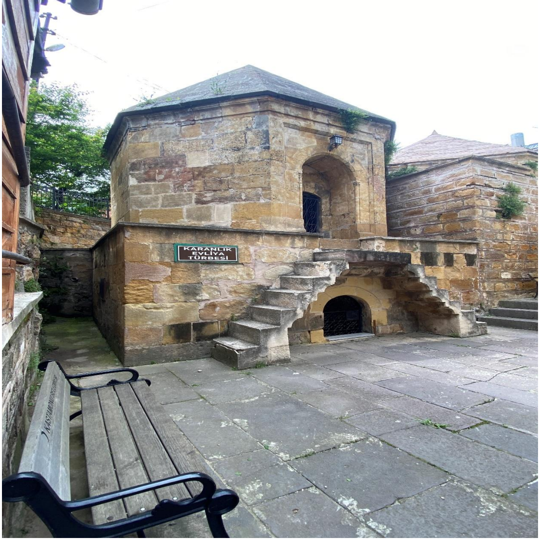
Fotoğraf 3.20 Karanlık Evliya türbesi dış görünüş
