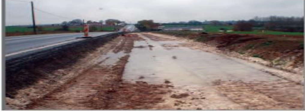
Şekil 2.21 Zayıf ıslak zemin örneği (Road Research Center Brussels 1965)
