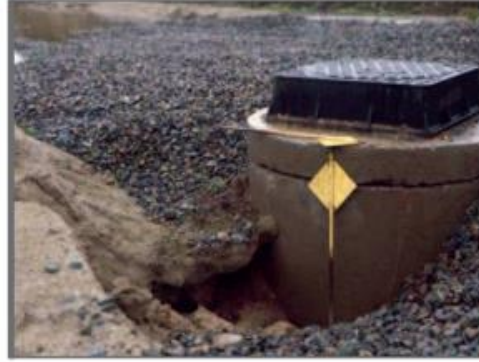
Şekil 2.29 İç erozyon (Road Research Center Brussels 1965)
