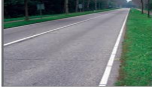
Şekil 2.25 Pompalama olgusu (Road Research Center Brussels 1965)
