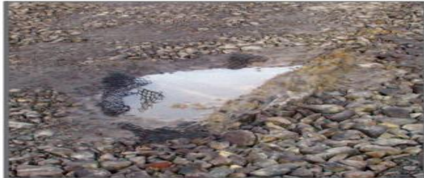
Şekil 2.22 İnce parçacıkların yükselişi (Road Research Center Brussels 1965)
