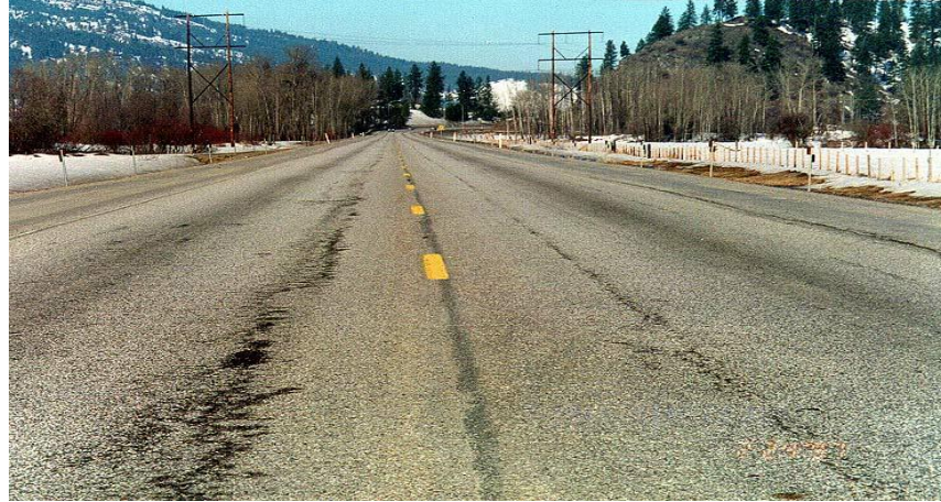
Şekil 2.42 Düşük yoğunluk nedeniyle çözülme (IOSR-JMCE 2015)
