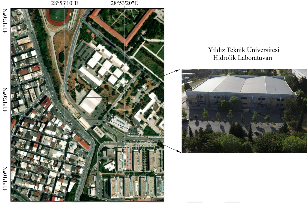
Şekil 6.1 Yıldız Teknik Üniversitesi Davutpaşa Kampüsü İnşaat Fakültesi Hidrolik Laboratuvarı
