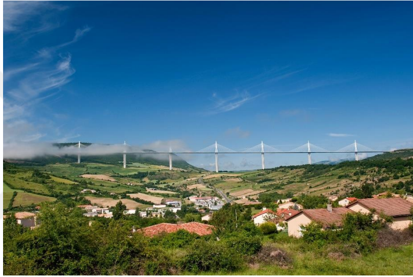
Şekil 2.6 : UHPC teknolojisi kullanılarak Fransa’da inşa edilen Millau Viyadüğü (URL 9)
