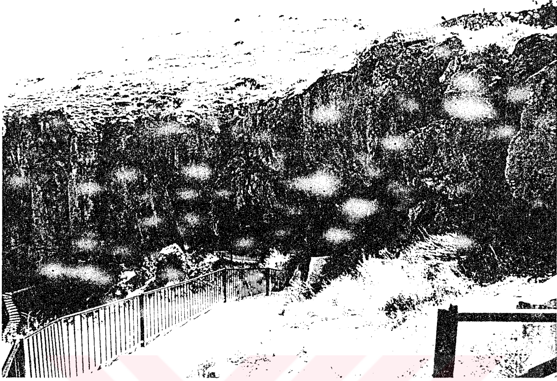
Şekil 9. Vadi Başı Bakı Noktasında Kaya Bloklarının Mevcut Tehlikeli Konumu.
