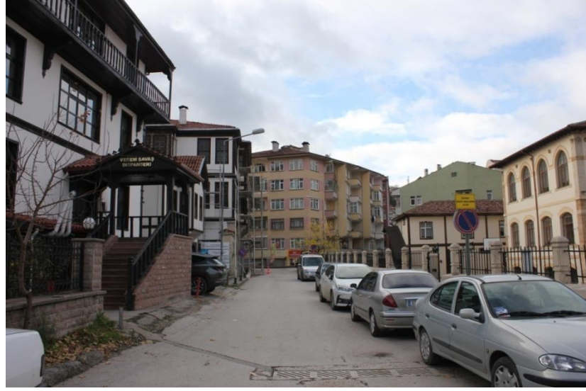
Şekil 4. 28 Liva Paşa Konağı (G5)
