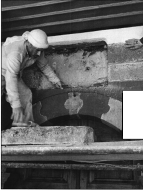
Fotoğraf 3-4 : Söküm sonrası ve Kitabenin tekrar yerine takılmış hali
