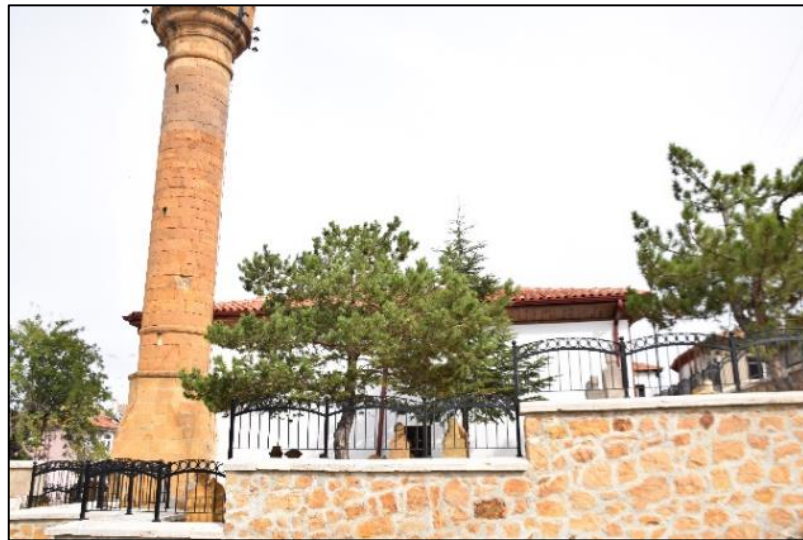
Fotoğraf 52. Arapdede Cami, Batı Cephe, Genel Görünüm, 2022 (Coşkun Özer).
