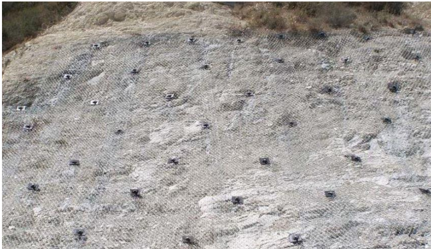
Şekil 4.27. Ankrajlı çelik kafes.
