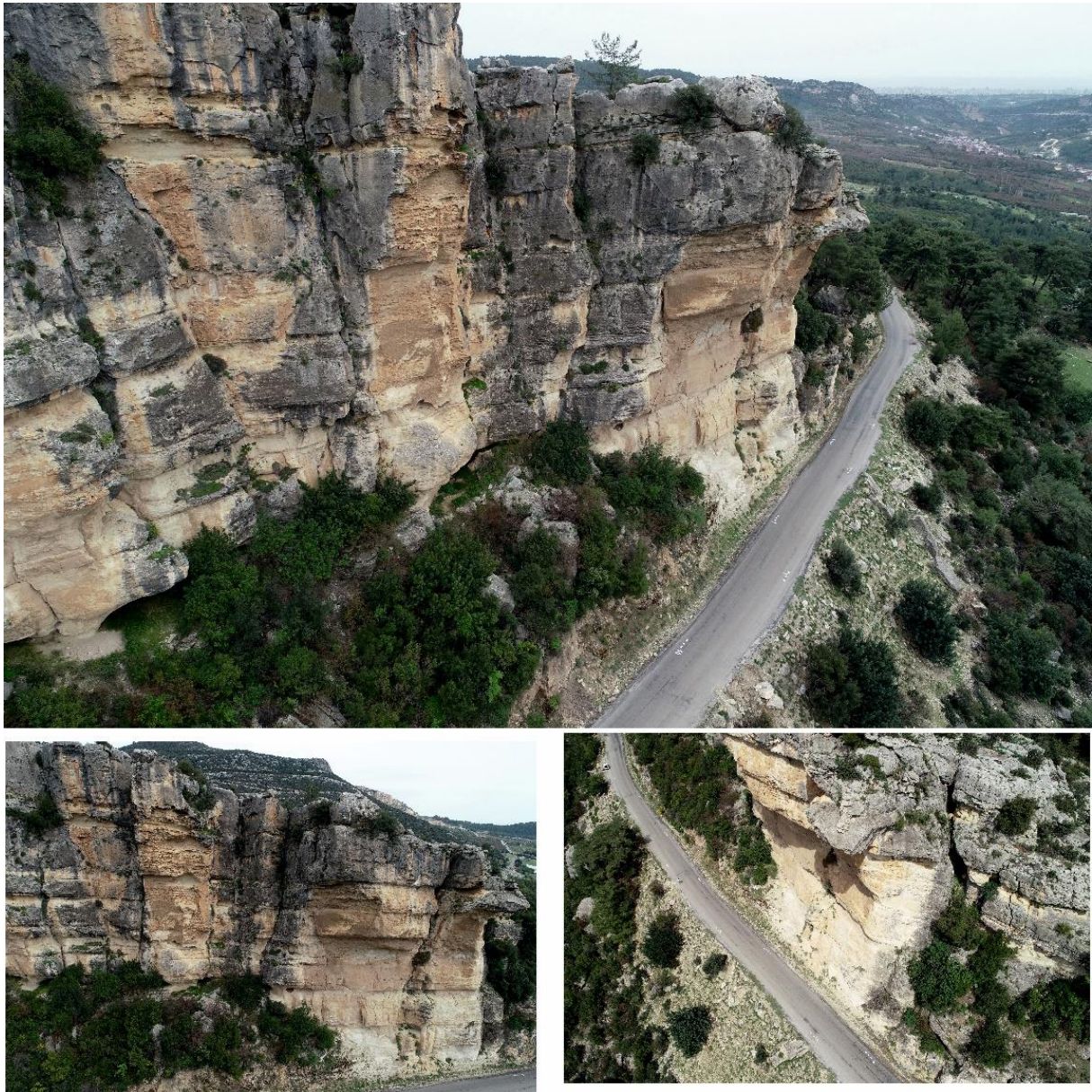
Şekil 3.11. Emirler-Değirmençay Yolu kaya düşmesi bölgesi.
