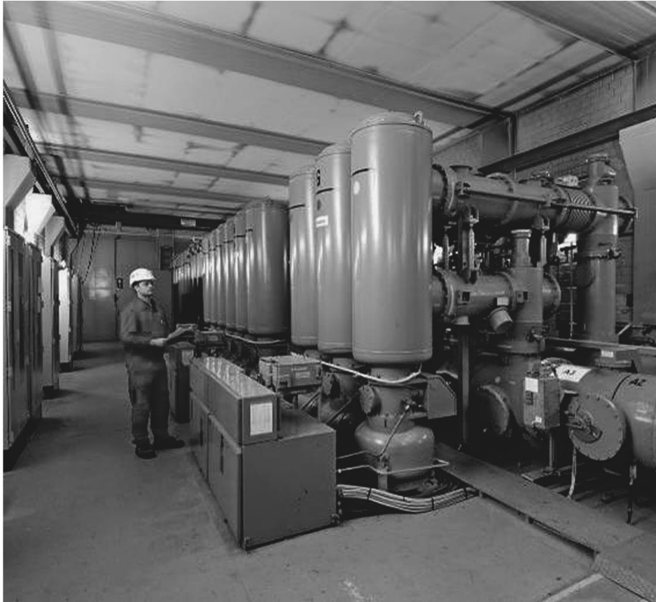
Resim 4.1. 1968' de Berlin, Almanya'da Wittenau Trafo Merkezinde 110 kV anma gerilimi için kurulan ilk GIS
