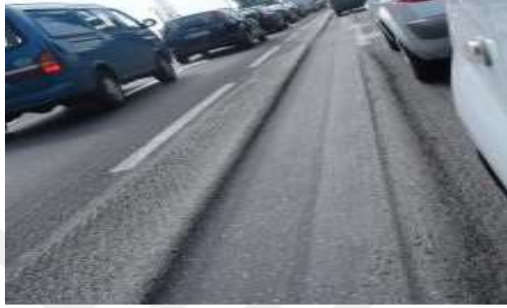
Şekil 3.10. Esnek kaplamada oluşan tekerlek izi deformasyonu
