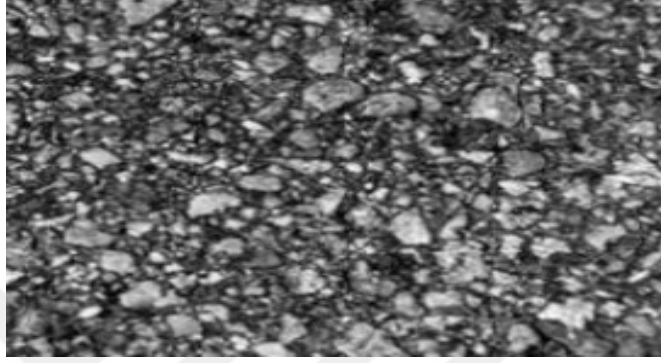
Şekil 3.28. Esnek kaplamada oluşan cilalanma
