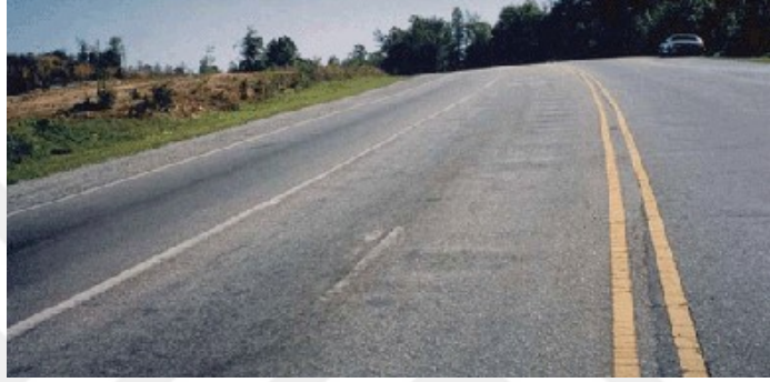
Şekil 3.13. Esnek kaplamada oluşan dalgalanmalar
