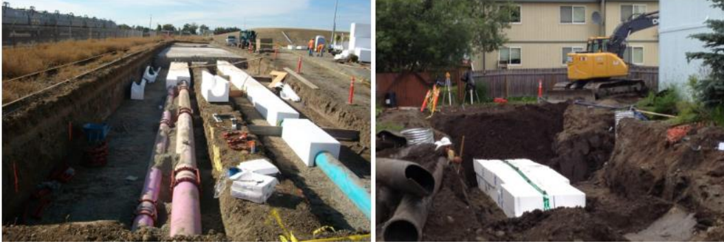
Şekil 7.4 Sığ gömülü boru sistemlerinde EPS Geofoam'un kullanımına dair arazi görselleri ( https://geofoamintl.com )
