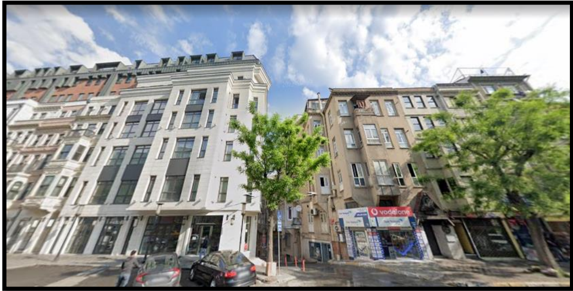
Şekil 2.17 Tarlabası Kentsel Dönüşüm Projesi Tarlabası Bulvarı'na 1. Parselde Bulunan, Yenilenmiş Yapı (Solda) ve Sınır Dışındaki Eski Yapı (Sağda) (Google Earth Sokak Görünümü 3)
