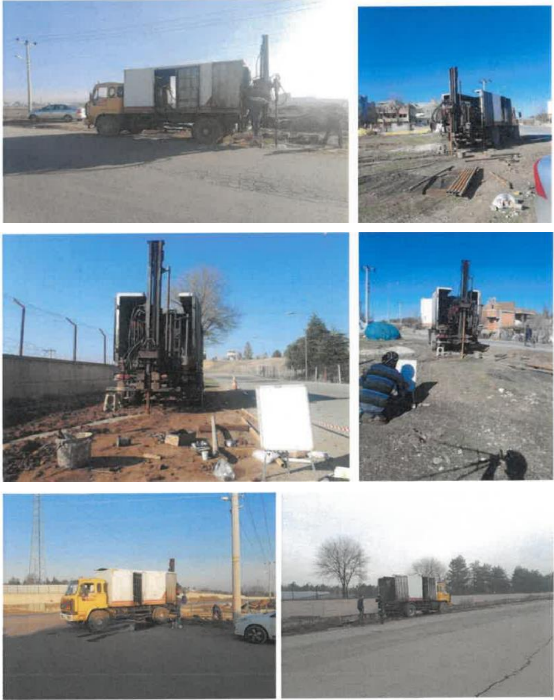
Şekil 3.14 Sondaj kuyularının açılmasına ait saha çalışması görselleri (Batman Belediyesi Arşivi, b.t.)
