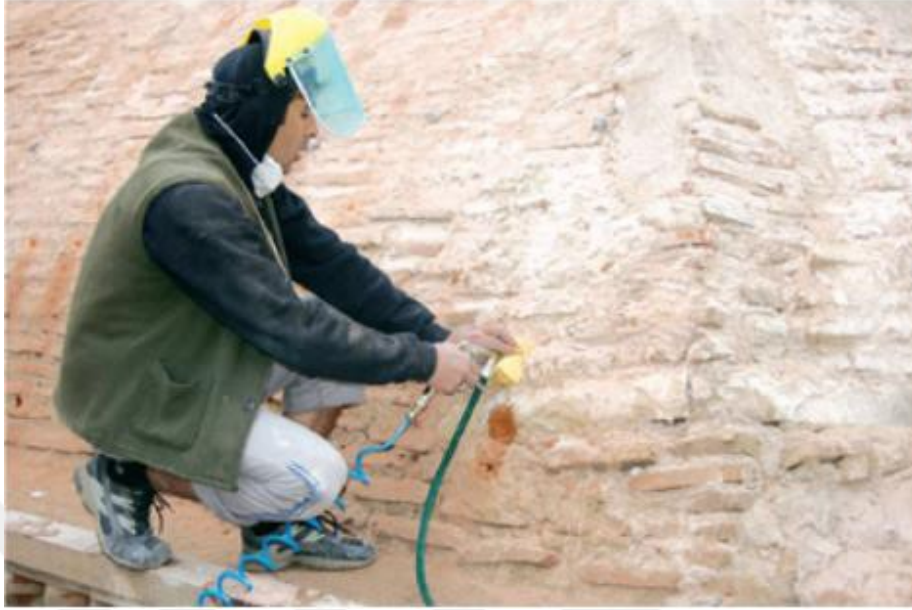
Şekil 3.21. Kubbe çatlaklarına enjeksiyon uygulanması (Küçük, 2010).
