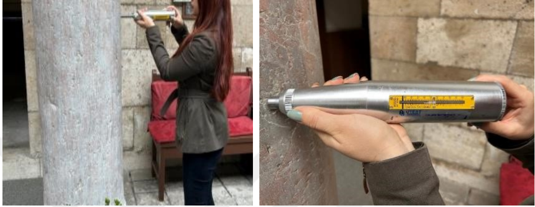
Şekil 4.12. Sütuna Schmidt çekici ile vuruş yapılması
