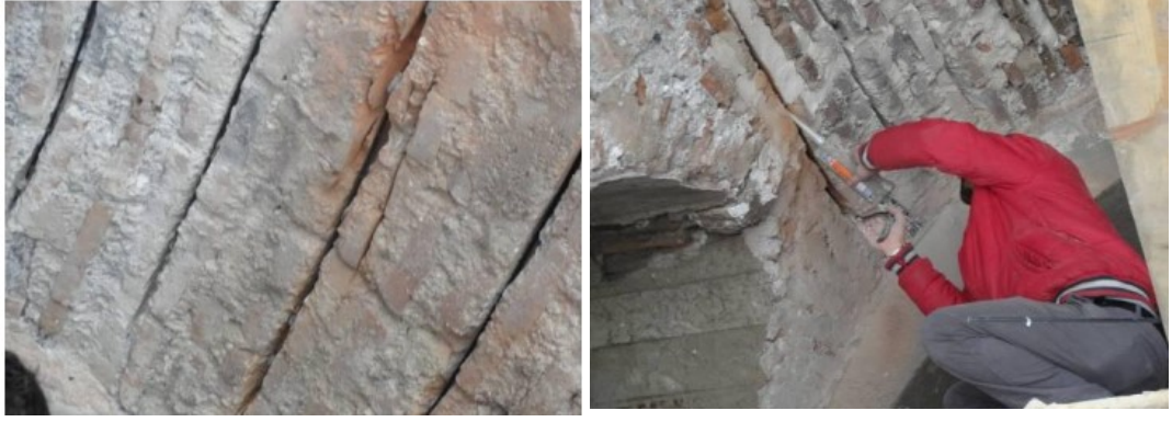
Şekil 3.17. Tonoz derzlerine metal lama uygulanması (Pergel,2013).
