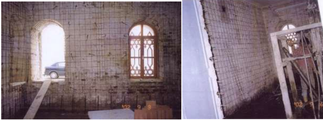
Şekil 3.7. İstanbul, Kabataş Erkek Lisesi duvarlara çelik hasır ve ankrajların yerleştirilmesi ve püskürtme betonunun tamamlanması (Saraç,2003)
