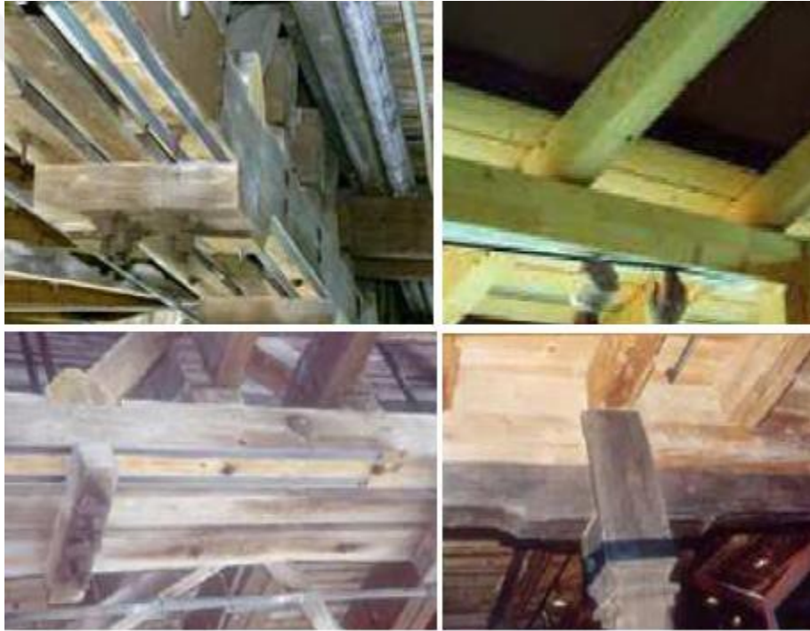
Şekil 3.23. Ahşap elemanların FRP ile güçlendirilmesi (Steiger, 2003)
