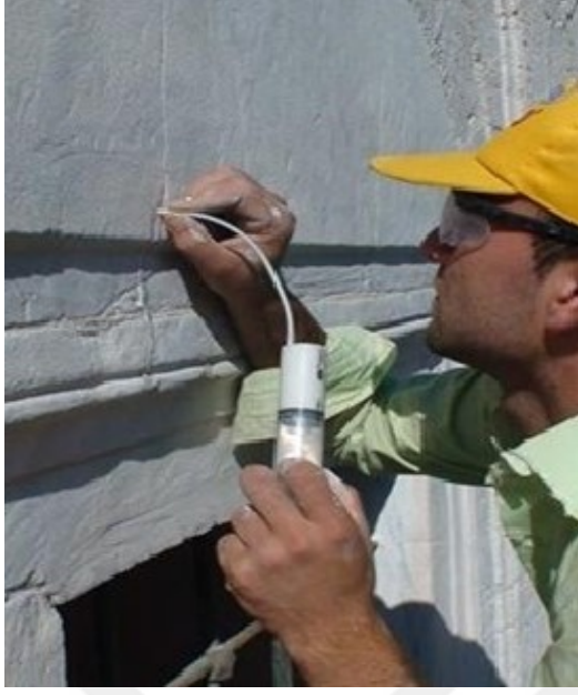
Şekil 3.2. Hidrolik kireç enjeksiyonu uygulanması ( http://www.starcephe.com/hidrolik_kirec_enjeksiyon.html )
