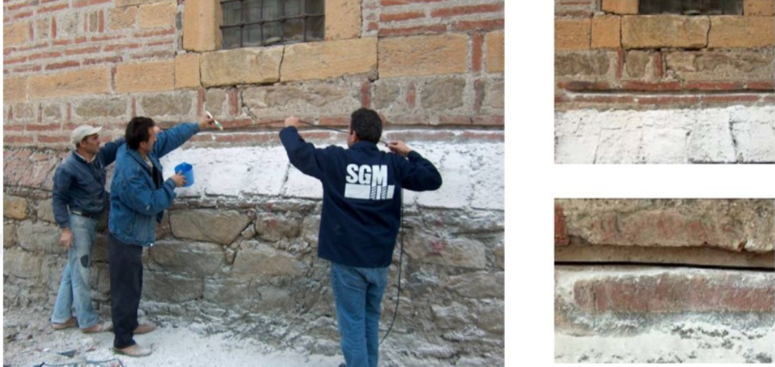
Şekil 3.8. Abide Hatun Cami'nin FRP çubuklarla güçlendirilmesi (Bayraktar, 2006)
