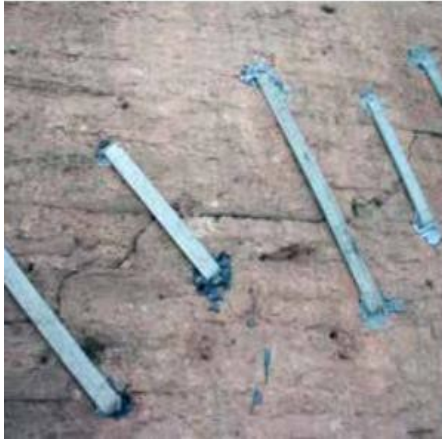
Şekil 3.22. Kubbe çatlaklarında metal dikiş uygulanması (Çılı ve Yıldız, 2013)
