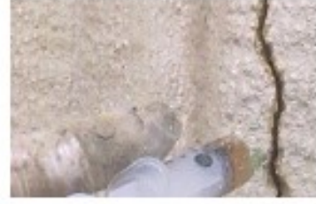
Şekil 3.2. Hidrolik kireç enjeksiyonu uygulanması ( http://www.starcephe.com/hidrolik_kirec_enjeksiyon.html )
