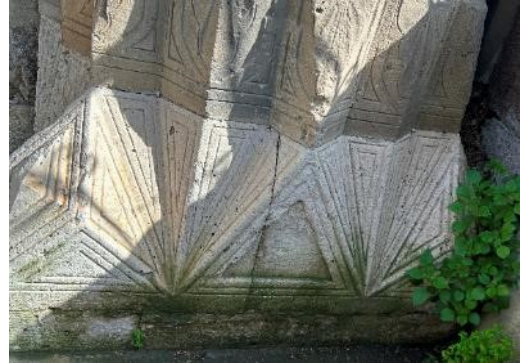
Şekil 2.22. Bimarhane'nin kuzey cephesi duvar altlarındaki bitki oluşumları
