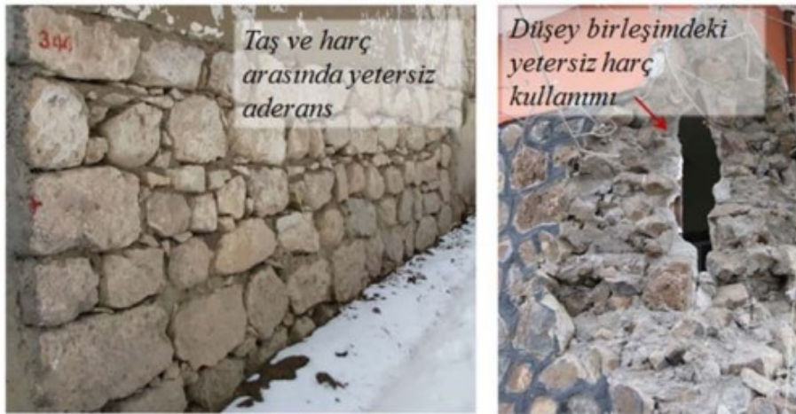
Şekil 2.11. Taş ve harç arasında yetersiz aderans (Oyguç,2017)
