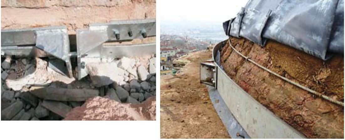
Şekil 3.19. Mihrimah Sultan Camii Kubbede çekme çemberi uygulaması (Sav ve diğ,2010)
