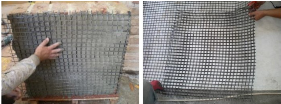
Şekil 3.9. Karbon ızgara ile donatılı harç uygulaması (Mezrea ve diğerleri, 2013)
