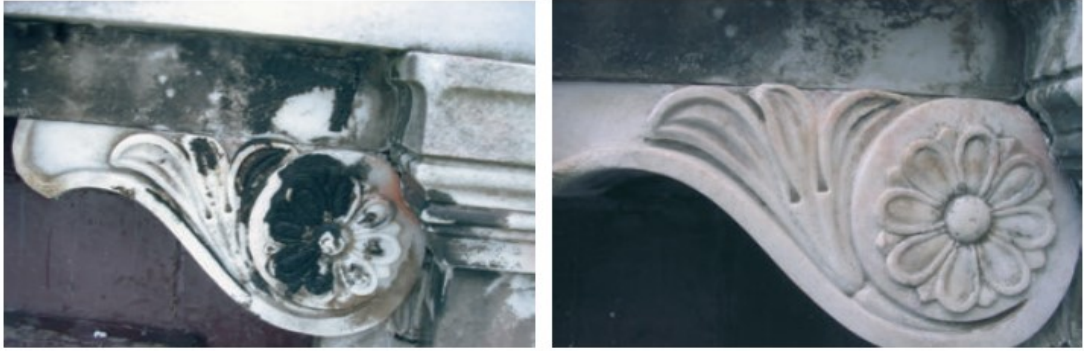
Şekil 3.34. Ayasofya Müzesi cephe taş temizliği öncesi ve sonrası
