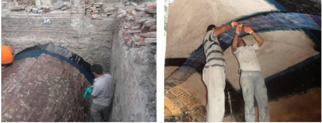
Şekil 3.18. Tonozlara FRP uygulanması
