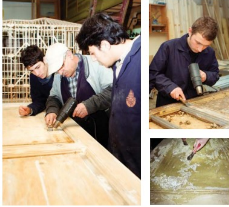
Şekil 3.35.Ahşap yüzeylerindeki boya sökümü işlemleri (Köroğlu ve Kudde, 2011)
