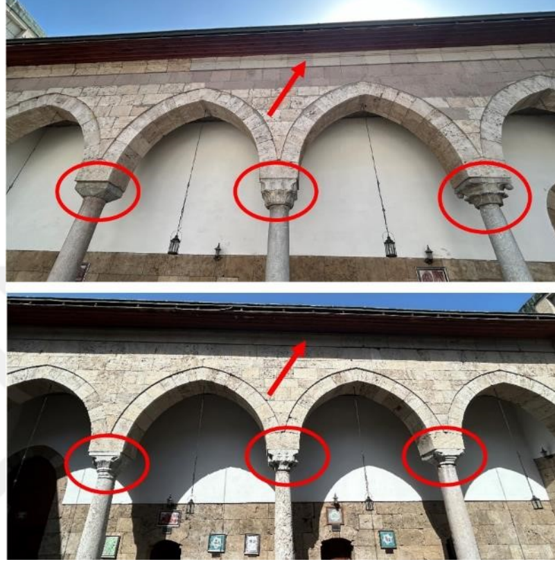
Şekil 5.58.Revaktaki sütun, sütun başlarının ve revak duvarındaki taşların farklı olması
