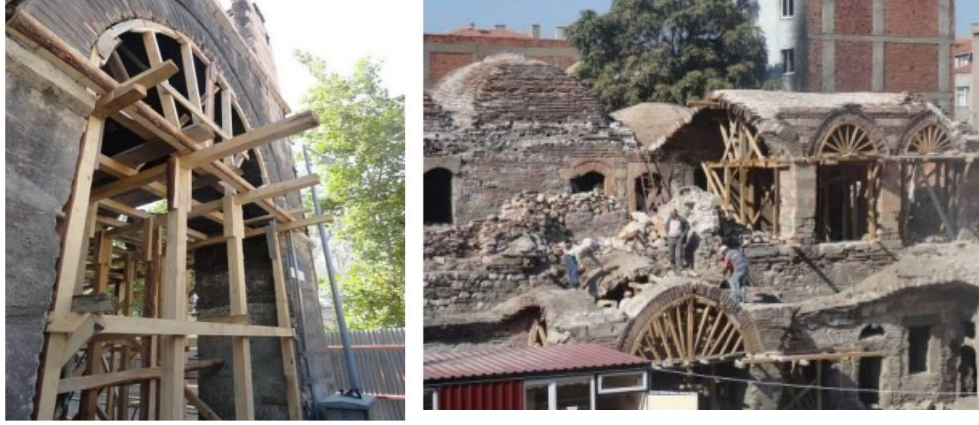
Şekil 3.14. Amasya Taşhan giriş tonozunun askıya alınma işlemi (Pergel,2013)
