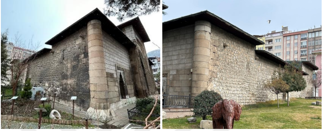
Şekil 4.7. Bimarhane'nin ön cephesi kesme taş, diğer cepheleri ise kaba moloz taş duvar
