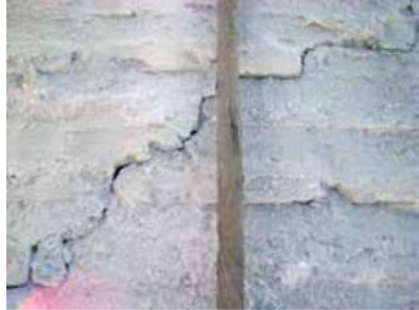
Şekil 3.22. Kubbe çatlaklarında metal dikiş uygulanması (Çılı ve Yıldız, 2013)
