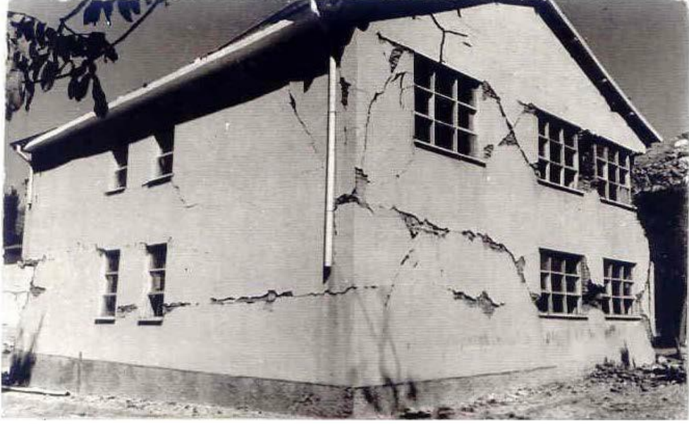
Şekil 2.5. 1975 Lice Depremi sonrası boşluk oranı fazla ve az olan komşu iki duvarın farklı hasar düzeyleri (Bayülke, 2011)
