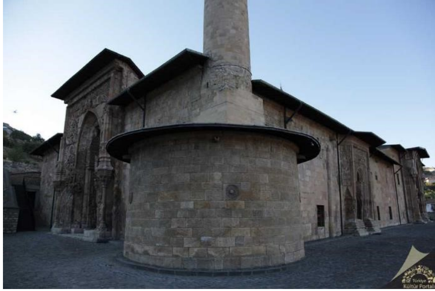
Şekil 3.6. Sivas Divriği Ulu Camii minare kaidesinde genişletme- Görsel Sahibi: Sivas İl Kültür ve Turizm Müdürlüğü
