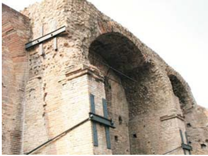
Şekil 3.16. Kemerlerde gergi ve mesnetlerin sabitlenmesi (Sesigür ve diğ.,2007).
