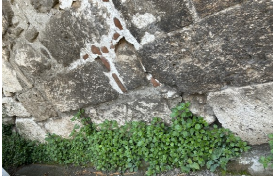
Şekil 2.22. Bimarhane'nin kuzey cephesi duvar altlarındaki bitki oluşumları
