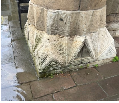
Şekil 2.21. Bimarhane duvar diplerinde zemindeki sudan kaynaklı görülen yosunlaşmalar
