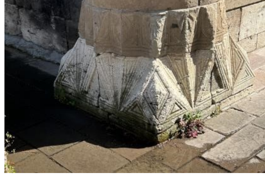
Şekil 2.21. Bimarhane duvar diplerinde zemindeki sudan kaynaklı görülen yosunlaşmalar
