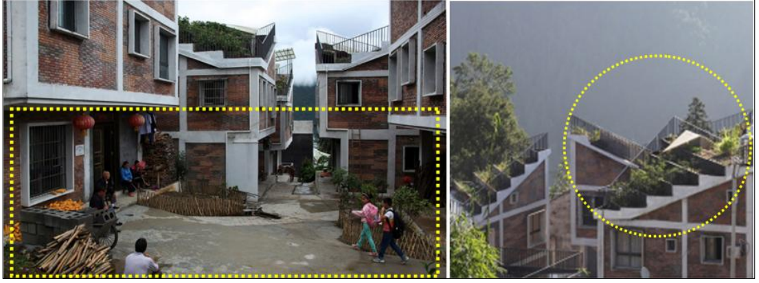
Şekil 3.4 : Konutlardaki Atölyeler ve Yeşil Çatı Uygulaması (URL-8).
