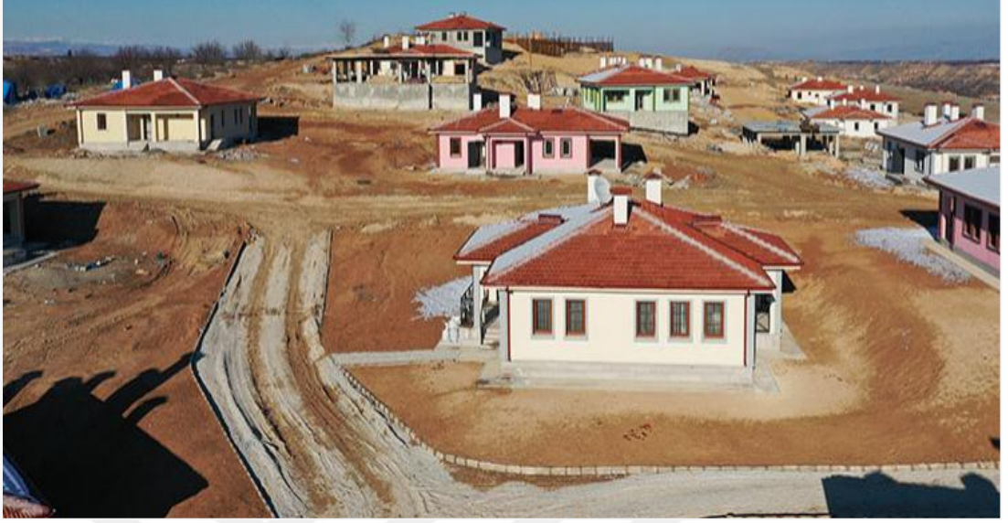
Şekil 4.15: Kahramanmaraş Depremi Sonrası Birbirine Benzer Köy Tipi Tek Katlı Afet Konutları (URL-26).
