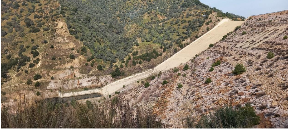
Şekil 4.4. İkizdere Barajının dolusavaęı.
