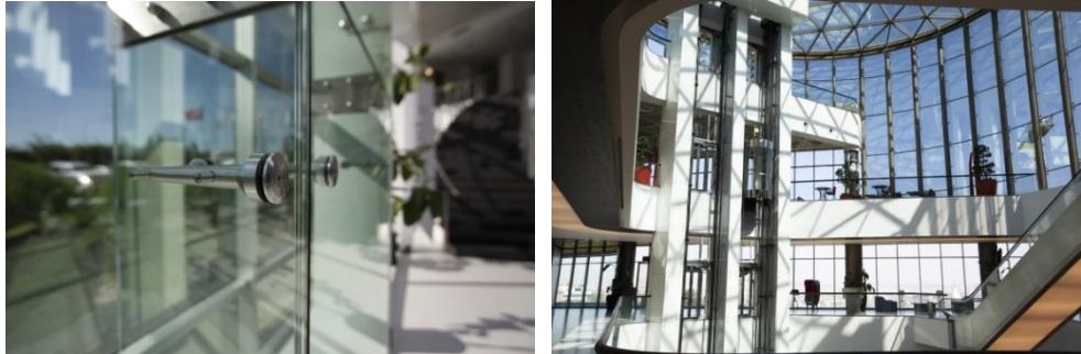
Şekil 2. 1 :Noktasal taşıyıcılı sistem cam (Url-2).
