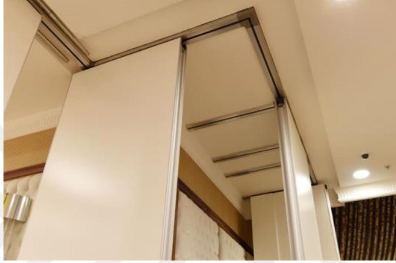
Şekil 3. 8 : Hareketli panel duvar ray sistemi (Url-12).
