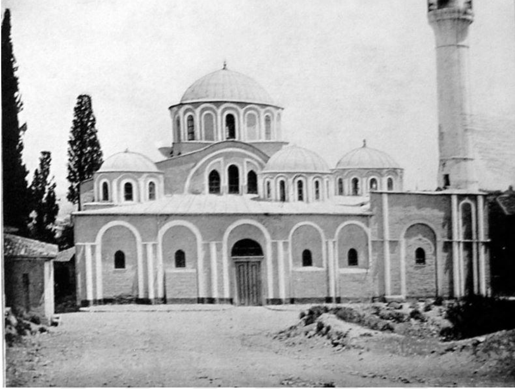
Görsel 3 : Kariye Camii - ön cephe fotoğrafı 1912
