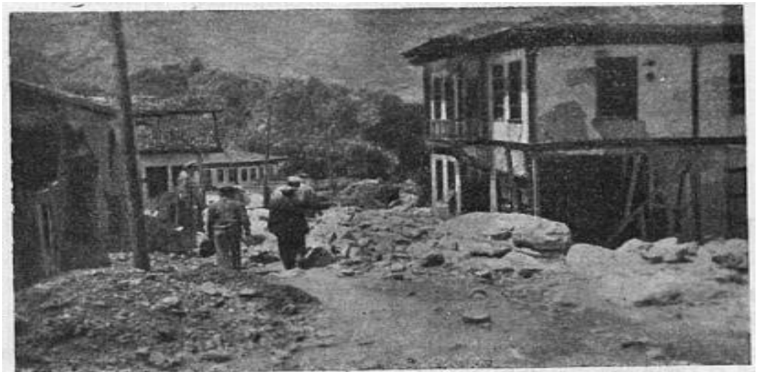
Yukarıda yangın yeri mevkiinde çadırlarda barınanlar, aşağıda sellerin getirdiği büyük kayalar ve yıkılan evlerin enkazının kaldırılması
