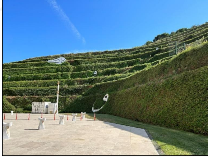
Şekil 4.15: Geosentetik donatılarla 10 katmandan oluşturulmuş dolgu alanı, Çamlıca Cami, 2023.
