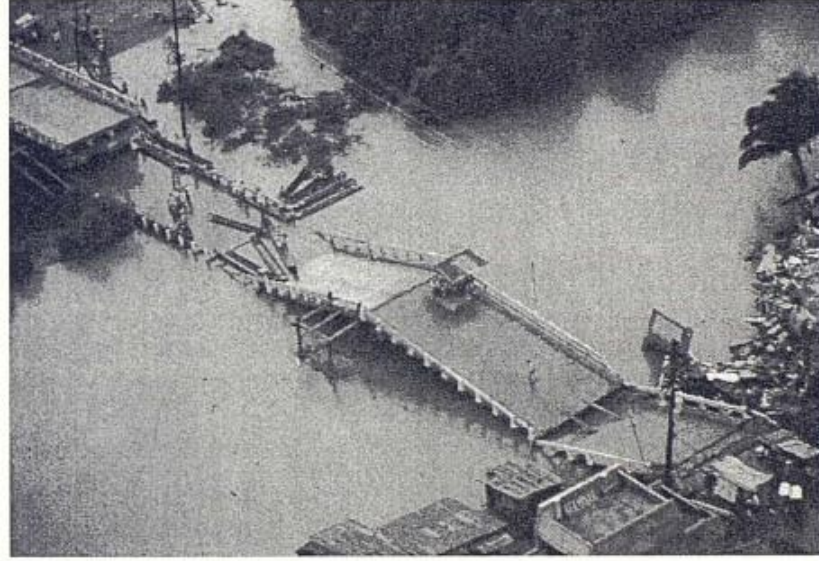
Şekil 4.9 1990 Luzon depreminden sonra Dagupan'daki Magsaysay Köprüsü'nün çöküşü. {EEFIT'in izniyle, Birleşik Krallık)
