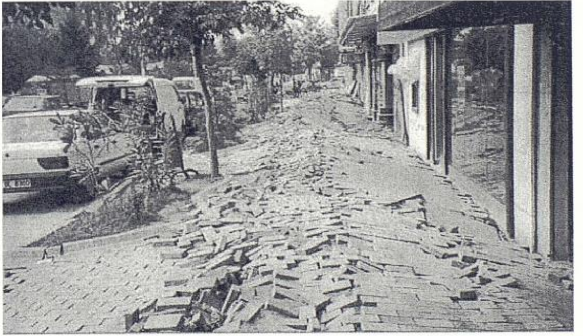
Şekil 4.1 Yerleşik binanın bitişiğindeki zeminin şişmesi, Adapazarı, Türkiye, 1999. Nezaket Deprem Mühendisliği Saha Araştırma Ekibi (EEFIT), İngiltere
