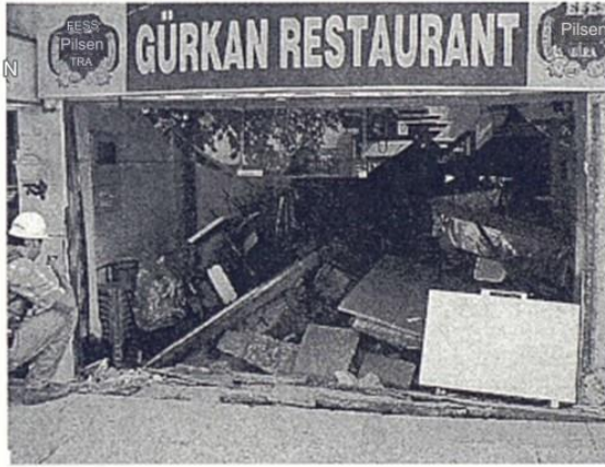
Şekil 6.4 (a) Kolonların oturması nedeniyle iç döşemede yapısal olmayan hasar ve altta yatan toprağın şişmesi, (b) Zeminin şematik gösterimi Adapazarı, Türkiye (Bray & Stewart, 2000)
