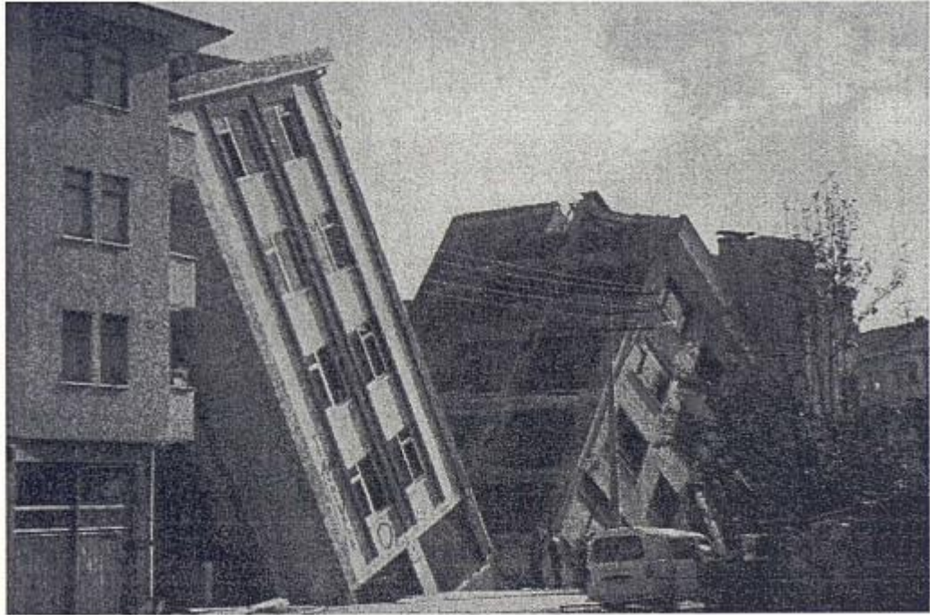
Şekil 5.1 Adapazarı merkezde sıvılaşma nedeniyle yana yatmış bina. {Deprem izniyle Mühendislik Saha Araştırma Ekibi (EEFIT), Birleşik Krallık}
