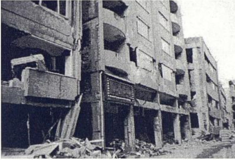
řekil 5.13 ark Bulvarı boyunca yapısal olarak hasar grmř binaların grnm (Hat 1, řekil 6.14) (EEFIT) izniyle, Birleřik Krallık
