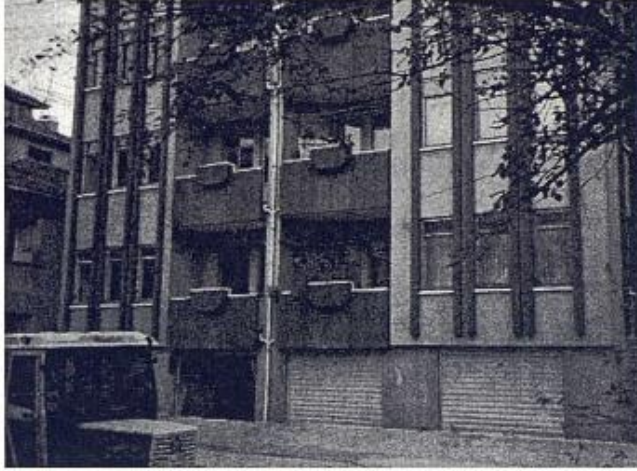
Şekil 6.5 (a) Adapazarı'nda sert temeller üzerinde olduğu anlaşılan bir binanın düzgün yerleşimi ve (b) sert temeller üzerindeki binaların üniformaya tepkisinin şematik gösterimi
