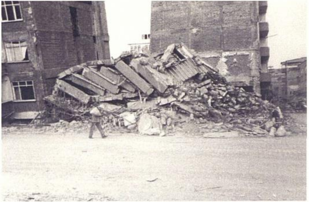
Şekil 5.2 Yer sarsıntısı nedeniyle çökme NATO Caddesi, Adapazarı. (EEFIT'in izniyle, Birleşik Krallık)
