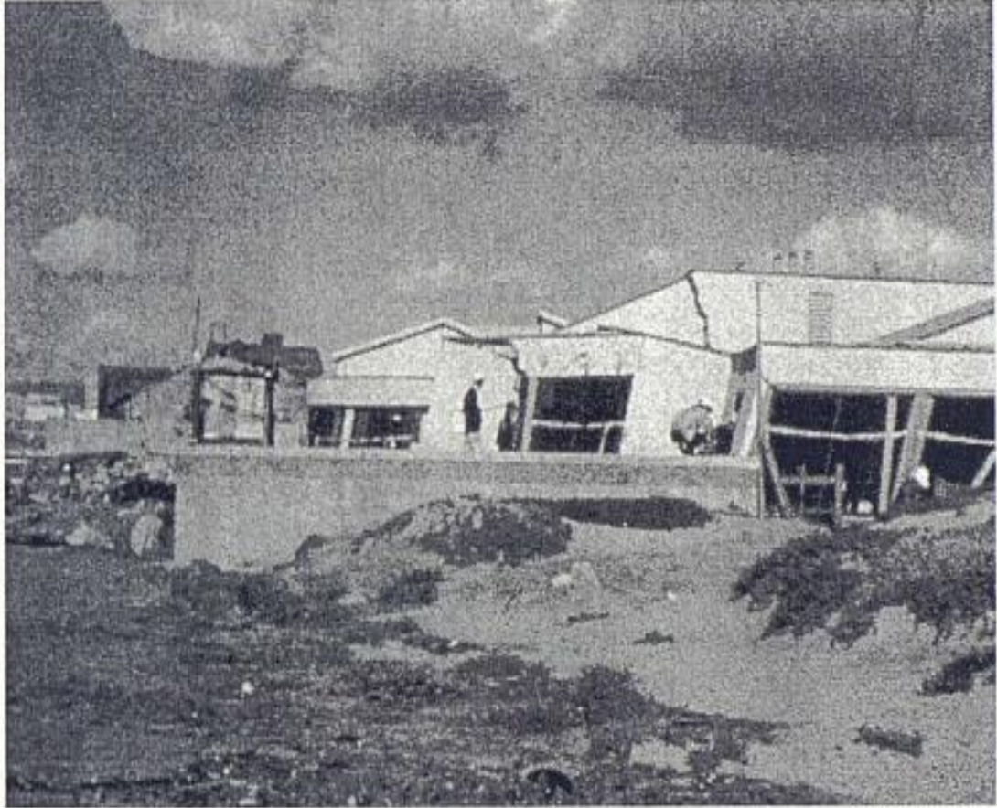
Şekil 4.6 California Moss Landing'deki Marina Araştırma Tesisinde sıvılaşmanın neden olduğu hasar
