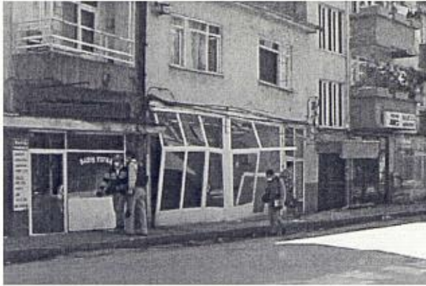
Şekil 6.11 Adapazarı'nda sığ temeller üzerinde olduğu düşünülen ahşap ve tuğladan yapılmış bir yapı
