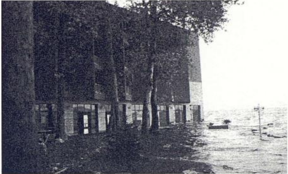
Şekil 4.3 Sıvılaşmanın neden olduğu Sapanca Oteli'nin su baskını, Türkiye, 1999 (EEFIT'in izniyle, Birleşik Krallık)
