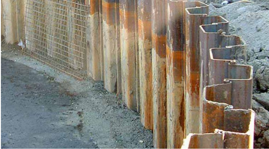
Şekil 2.21. Palplanş perde sistemleri ("İnsapedia" web sitesi, 2018)
