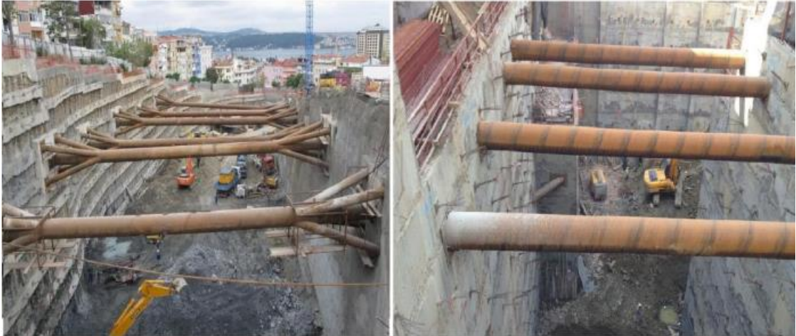
Şekil 2.26. Boru destek iksa sistemleri
