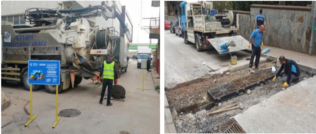
Şekil 4.8 : Osmangazi'de Atıksu/Yağmursuyu Hatlarının Temizlenmesi (Kaynak: BUSKI Faaliyet Raporu, 2022).
