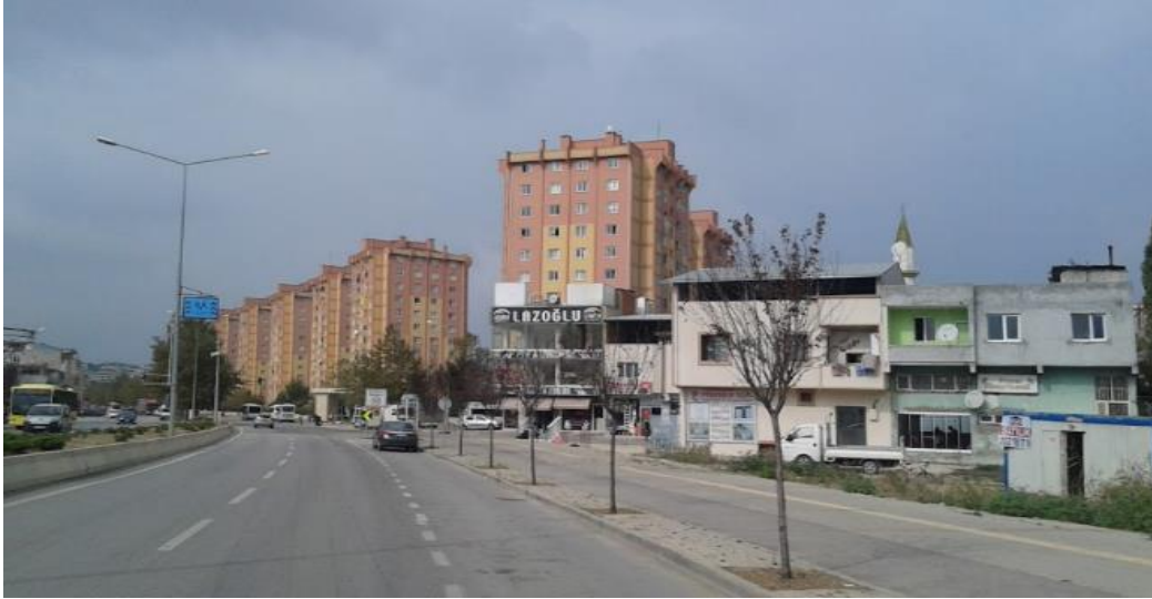
Şekil 4.9 : Yunuseli Mahallesi, Osmangazi ilçesi (Kaynak: Url-21).
