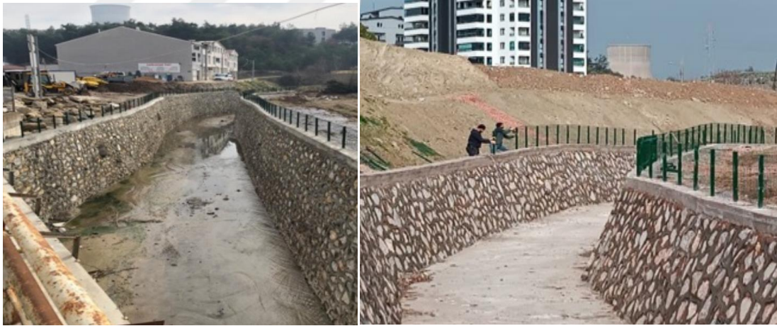
Şekil 4.6 : Osmangazi İlçesi Akçaköy Deresi Islahı İnşaatı Projesi (Kaynak: BUSKI Faaliyet Raporu, 2022).
