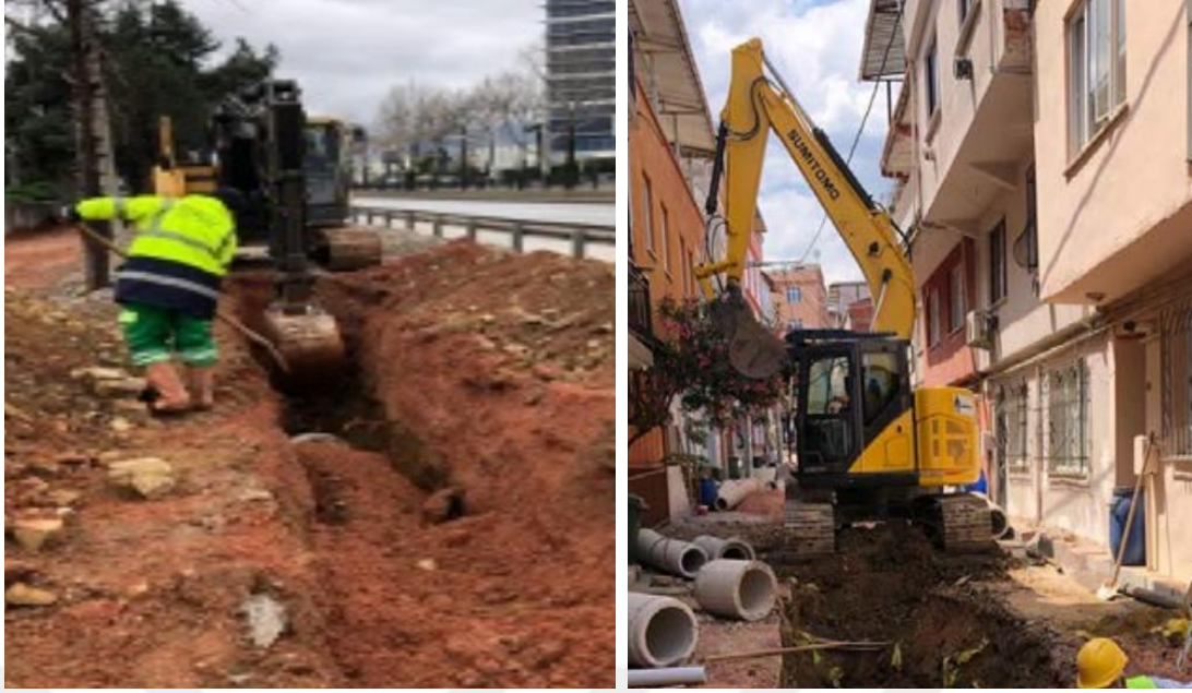
Şekil 4.5 : Kanalizasyon ve Yağmursuyu Altyapı İnşaatı (Kaynak: BUSKI Faaliyet Raporu, 2022).
