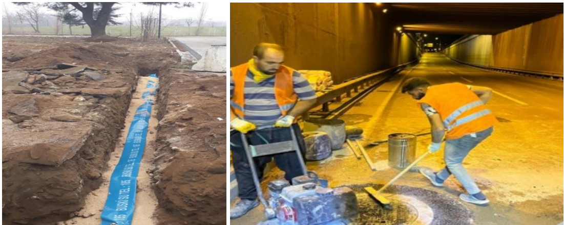
Şekil 4.3 : Osmangazi'de içme suyu hatları montajı (Kaynak: Buski Faaliyet Raporu, 2022).
