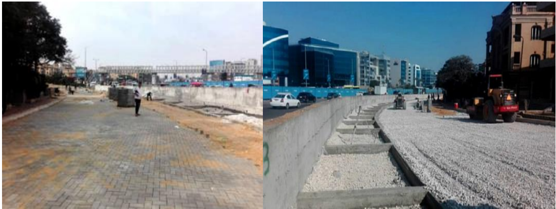
Şekil 2.3 : Kilitli karoların ve çakıl havuzunun uygulanması (El-zafarany, 2018).
