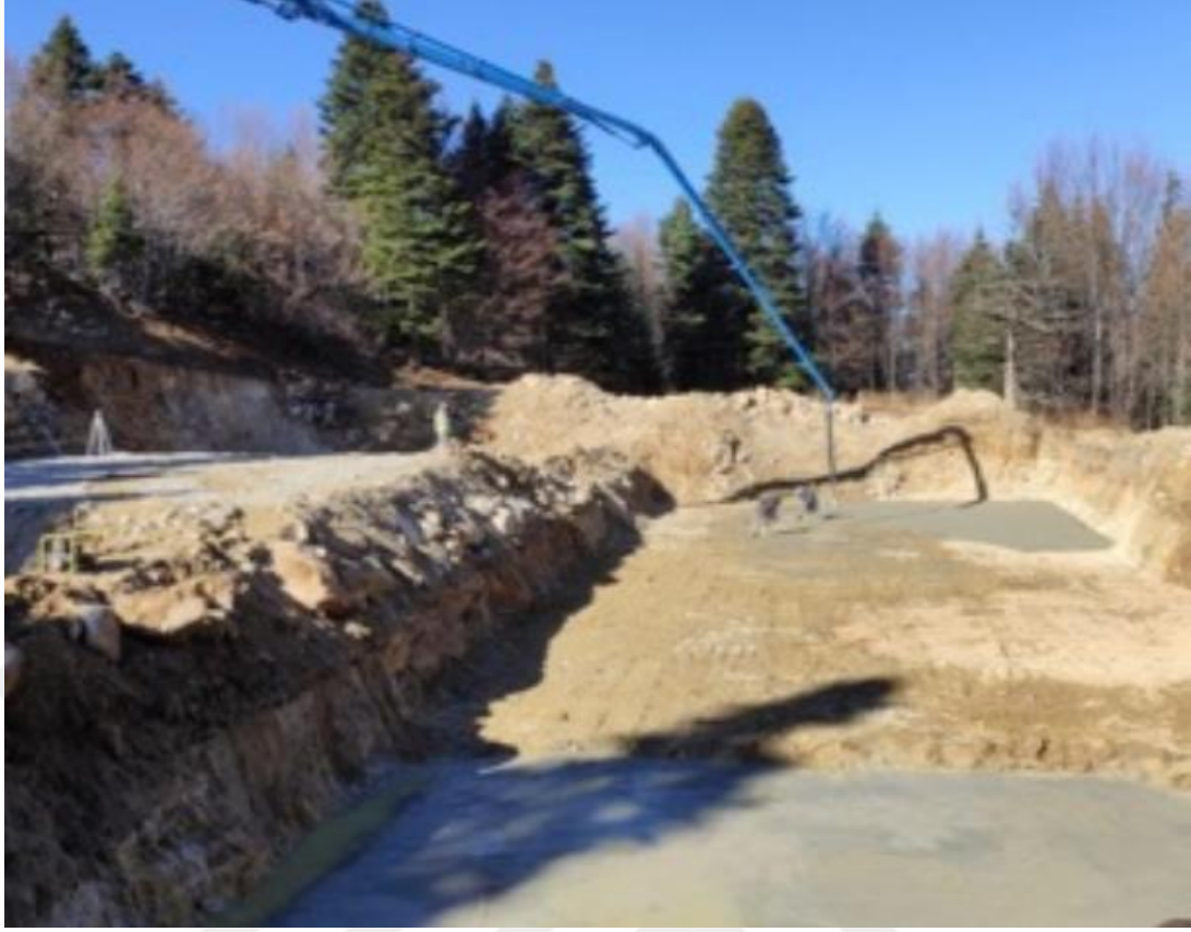
Şekil 4.7 : Uludağ Atıksu Arıtma Tesisi İnşaatı Projesi (Kaynak: BUSKI Faaliyet Raporu, 2022).
