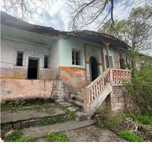
Fotoğraf 4.16 KV28 Vekse Köyü Okulu
