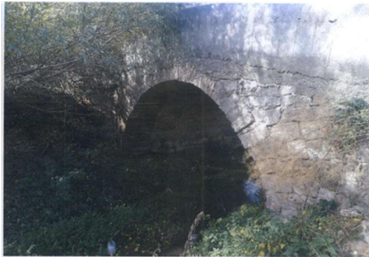
Fotoğraf 4.90 KV26 Vekse Köyü Köprüsü (T.C. Kültür ve Turizm Bakanlığı Kayseri Kültür Varlıklarını Koruma Bölge Kurulu, 2021)
