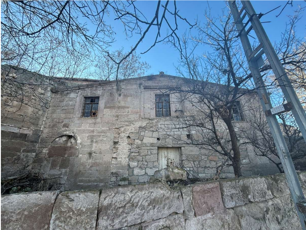
Fotoğraf 4.87 KV27 Vekse Köyü Panagia Rum Kilisesi
