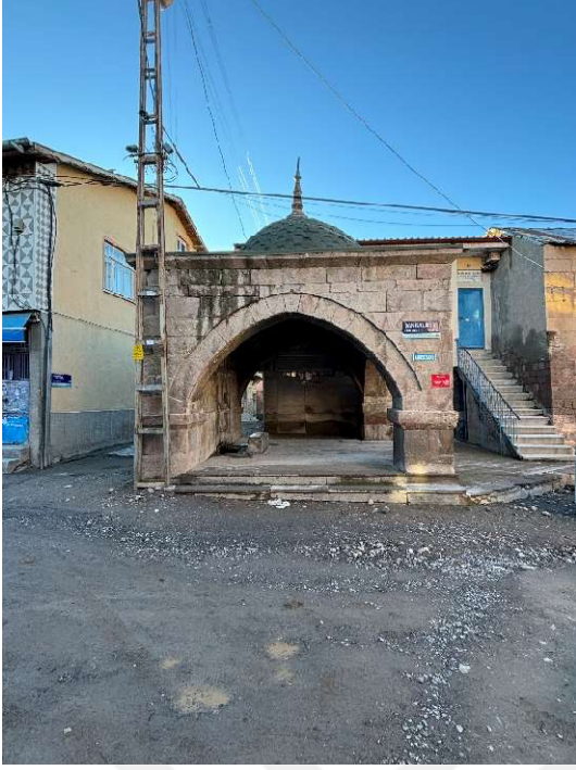
Fotoğraf 4.84 KV73 B.Bürüngüz Köyü Meydan Çeşmesi
