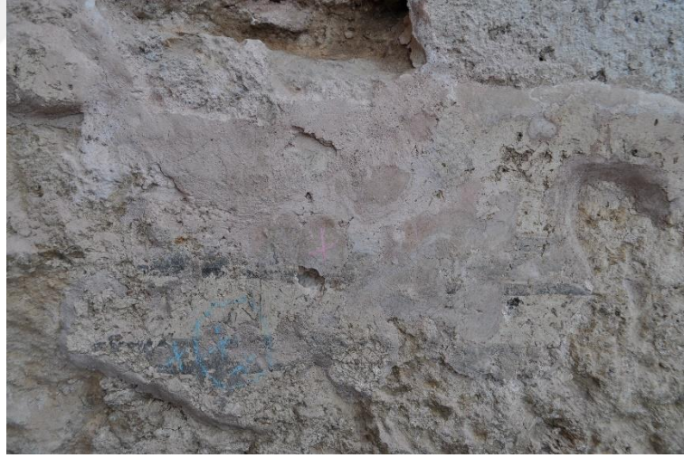
Resim 80: Geçmiş Onarım Müdahalelerinde Duvar Resminin Yüzeyine Harç Sürülerek Kapatılması (Büşra Al'ın Arşivi 2023)
