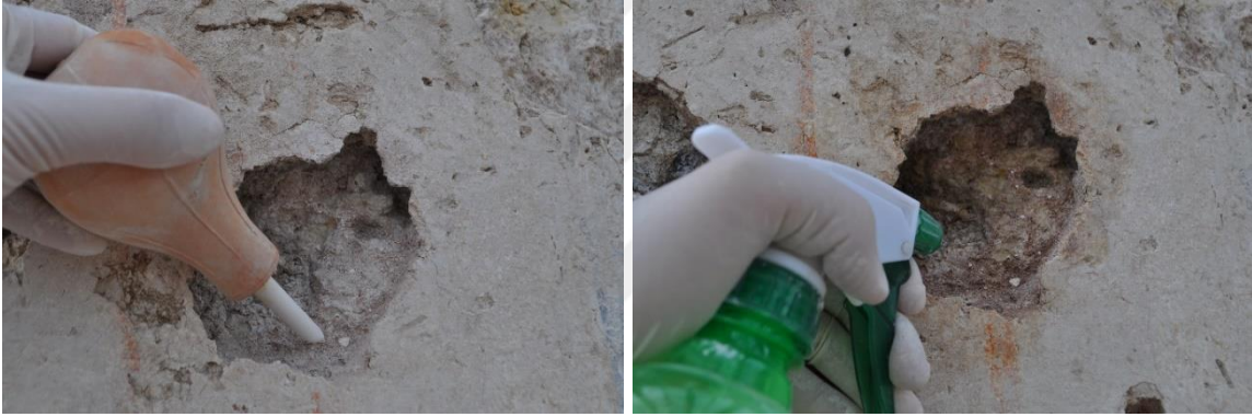
Resim 127-128: Harç Yapılacak Lakuna Alanının Temizlenmesi ve Islatılması (Büşra Al'ın Arşivi 2023)
