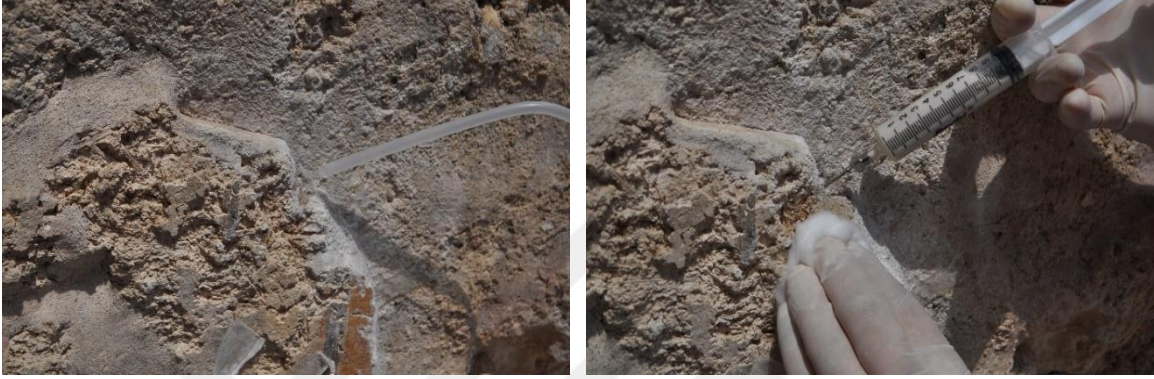
Resim 116-117: Enjeksiyon İçin Kanalların Alkol-Su (1:1) İle Temizlenmesi, Ardından PLM-A Harcı İle Enjeksiyon Uygulaması (Büşra Al'ın Arşivi 2023)
