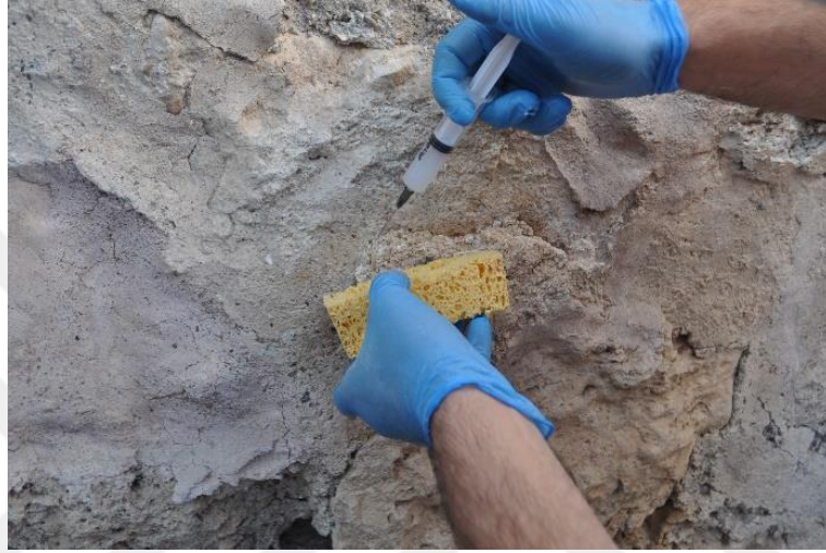
Resim 118: CaLoSiL E 25 ile Sağlamlaştırma (Büşra Al'ın Arşivi 2023)
