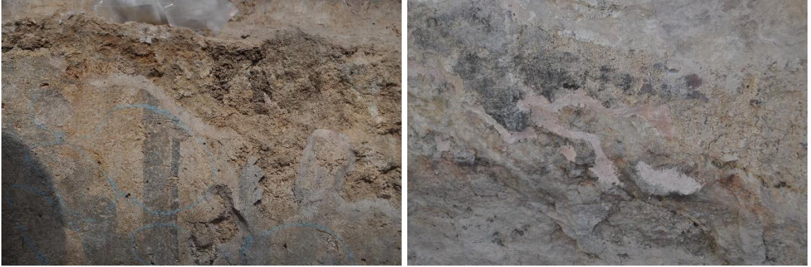
Resim 85-86: Gri Harç Kullanılan Alan ve Pembe Harç Kullanılan Alan (Büşra Al'ın Arşivi 2023)
