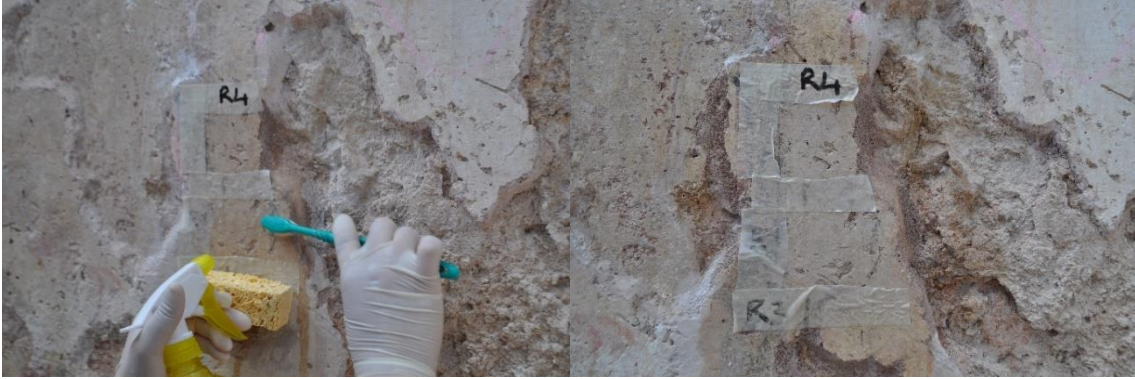
Resim 96-97: Kimyasal Paketleme Sonrası Duvarın Fırçalanması (Büşra Al'ın Arşivi 2023)
