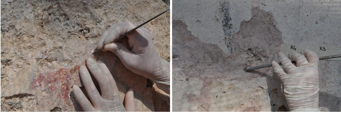
Resim 87-88: Eski Bordür ve Lakuna Harçlarının Bistüri-Murç İle Sökülmesi (Büşra Al'ın Arşivi 2023)
