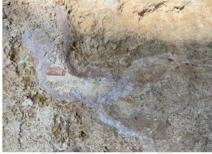
Resim 121: Bordür Onarımlarının 45 Derecelik Açılı İle Uygulanması (Büşra Al'ın Arşivi 2023)
