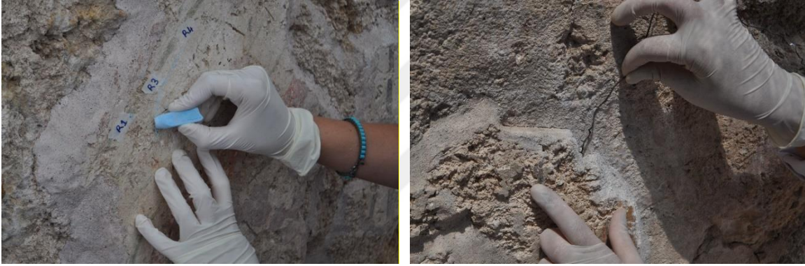
Resim 114-115: Enjeksiyon Yapılacak Alanların Tebeşir İle İşaretlenmesi ve Tel İle Kanalların Açılması (Büşra Al'ın Arşivi 2023)
