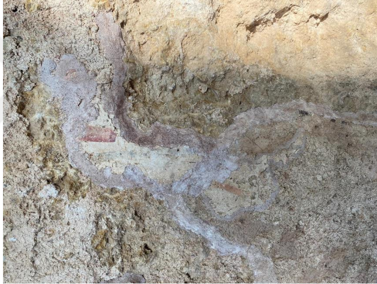
Resim 81: Bordür Onarımlarının Sıva Yüzeyine Kadar Çıkması (Büşra Al'ın Arşivi 2023)
