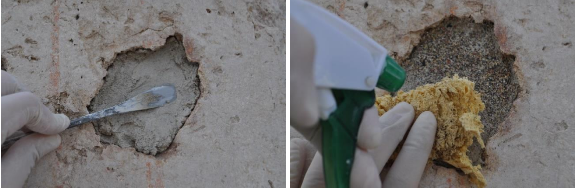
Resim 129-130: Spatül ile Harç Uygulaması ve Sünger İle Tampon Yapılması (Büşra Al'ın Arşivi 2023)
