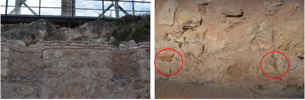
Resim 60-61: Oda-4 Tuğla Örgülü Nişler ve Resim Tabakasının Arka Kısımında Kullanılan Tuğla (Büşra Al'ın Arşivi 2023)
