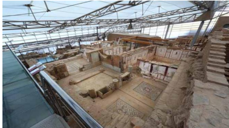
Resim 133: Koruma Çatısı Altında Yamaç Evler 2 (Ladstatter vd., 2016, s. 438)
