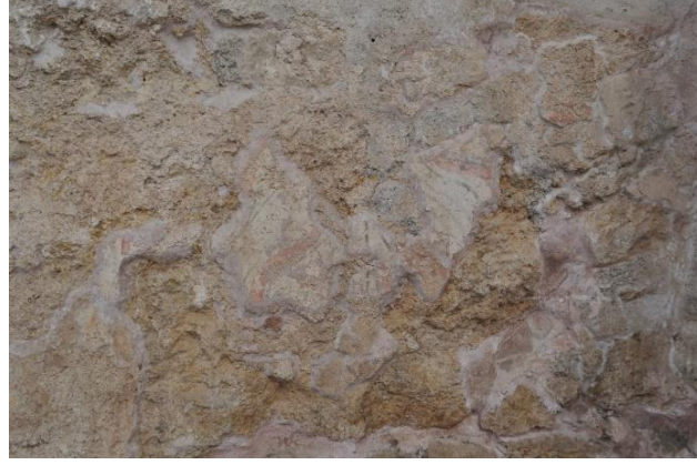
Resim 82: Farklı Renklerde Yapılan Harç Onarımları (Büşra Al'ın Arşivi 2023)
