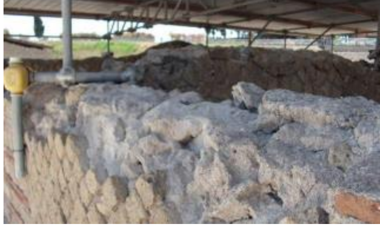
Resim 135: İtalya/Pompeii, Kalıntılar Üzerine Doğrudan Oturtulan Çatı Kapatması (Kocaman Pavlovic, 2020, s.141)
