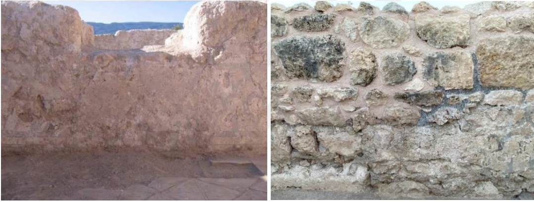
Resim 48-49: Oda-3 Güney Duvarı Duvar Resimleri (Orta pano) (Patacı, 2012, s. 274; Büşra Al'ın Arşivi 2023)
