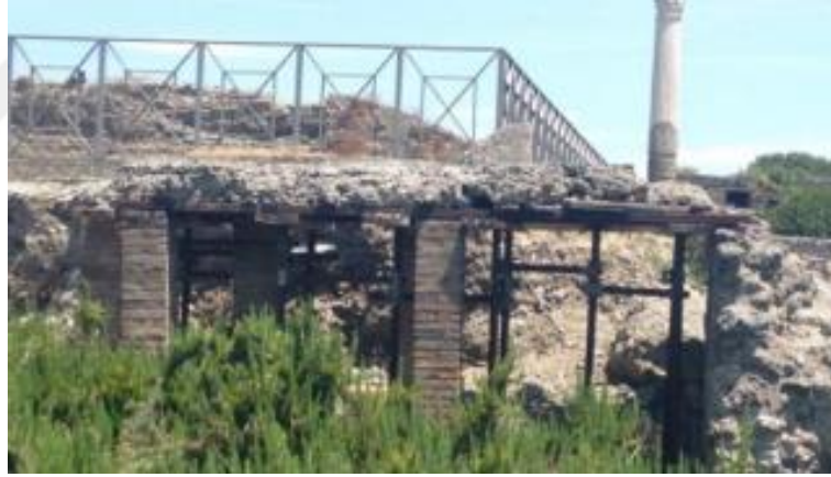
Resim 136: İtalya/Pompeii, Kalıntıların Üzerine Yapılan Yaya Yolu Nedeniyle Meydana Gelen Çökme (Kocaman Pavlovic, 2020, s.142)
