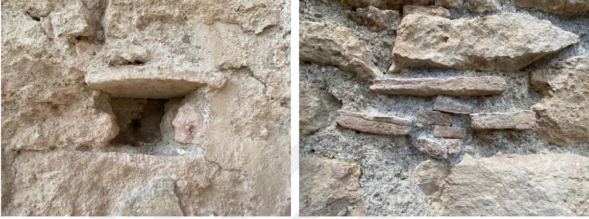
Resim 58-59: Oda-3'te Batı ve Kuzey Duvarlarında Tuğla Kullanımı (Büşra Al'ın Arşivi 2023)
