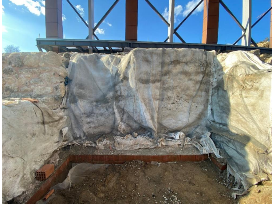
Resim 141: Oda-3 Jeotekstil ve Sinek Teli ile Geçici Kapatma (Büşra Al'ın Arşivi 2023)
