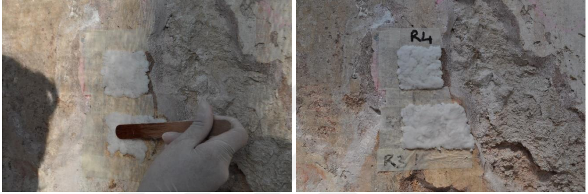
Resim 94-95: Kaęıt Hamuru İle Duvara Yapılan Kimyasal Paketleme Uygulaması (Břra Al'ın Arřivi 2023)
