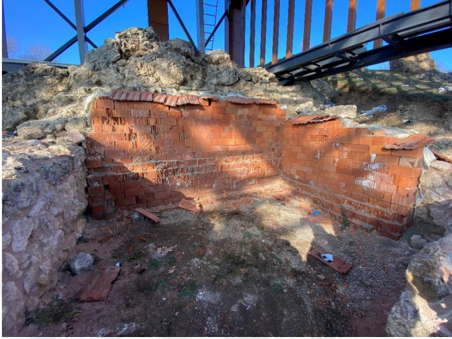
Resim 142: Oda-5 Tuğla ile Geçici Kapatma (Büşra Al'ın Arşivi 2023)
