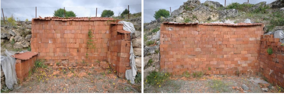
Resim 52-53: Oda-3 ve Oda-5 Duvar Resimlerinin Geçici Tuğla Kapatması (Büşra Al'ın Arşivi 2020)
