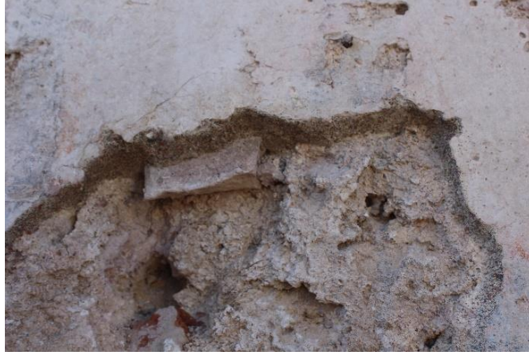
Resim 126: Bordür Onarımı (Büşra Al'ın Arşivi 2023)
