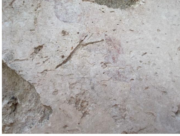
Resim 62: Oda-5 Duvar Resminde Kırıktan (Saman) Kaynaklı Oluşan Bozulmalar (Büşra Al'ın Arşivi 2023)
