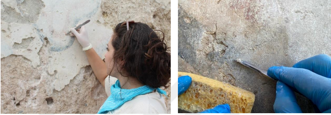
Resim 106-107: Duvar Resmi Yüzeyinde Bistüri İle Mekanik Temizlik (Büşra Al'ın Arşivi 2023)
