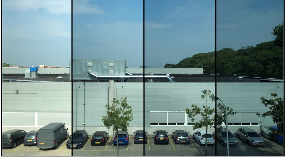
Şekil 3.16 Gelen ışığın şiddetine bağlı olarak koyulaşan fotokromik cam (Thomsaglass, 2023)
