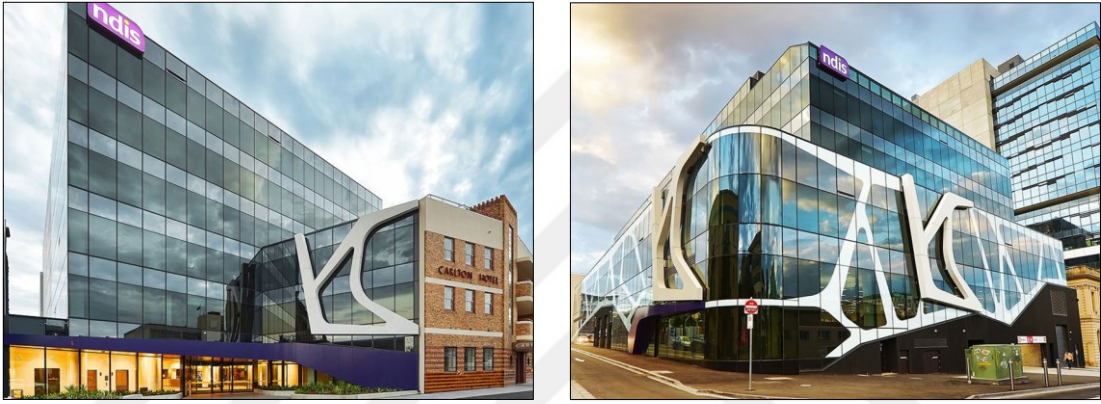
Şekil 3.18 Termokromik cam uygulaması (Suntuitiveglass, 2023)
