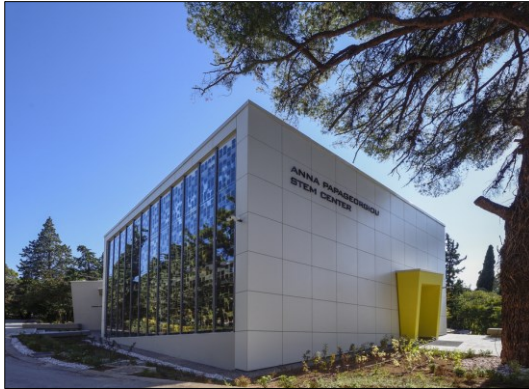
Şekil 3.29 Fotovoltaik cam uygulaması aydınlatma ve perde duvar olarak (Ease Educators, 2023), (Onyxsolar, 2023)
