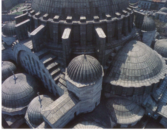
Şekil 3.22. Süleymaniye Camii'nin ana kubbesi ve geçiş elemanları [3].
