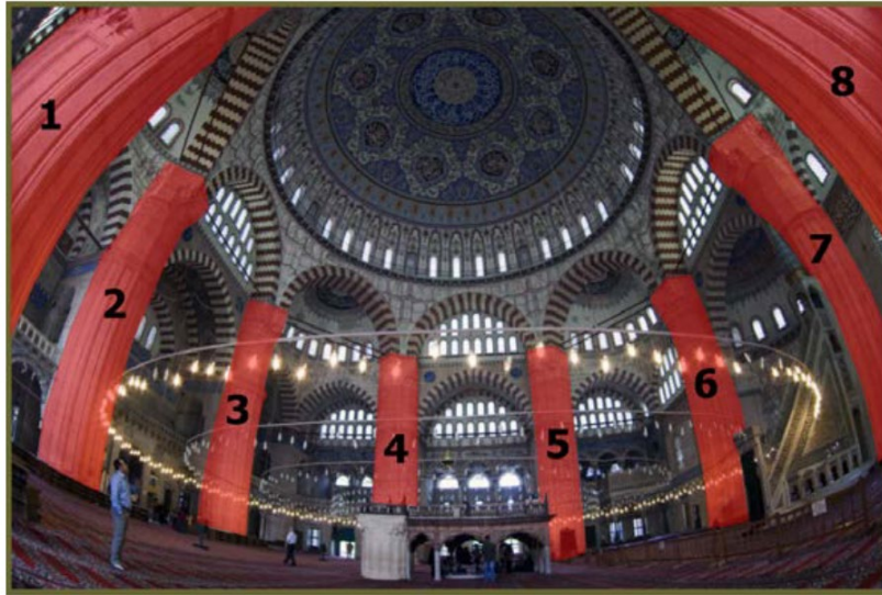
Şekil 2.22. Selimiye Camii ana kubbesi ve kubbeyi taşıyan yivli fil ayakları [54].
