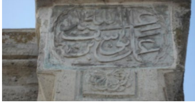
Şekil 2.29. Büyükçekmece Köprüsü üzerinde Sinan Mührü [62].
