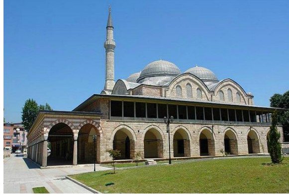
Şekil 2.3. Piyale Paşa Camii [31].
