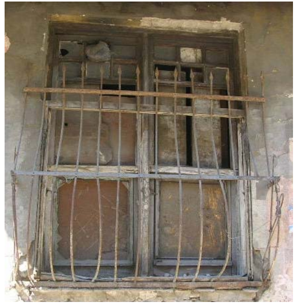
Şekil B39: Ayvansaray'da 19.yy Bir Konuttan Üstü Kare Açıklıklı Çift Giyotin Pencere Detayı.
