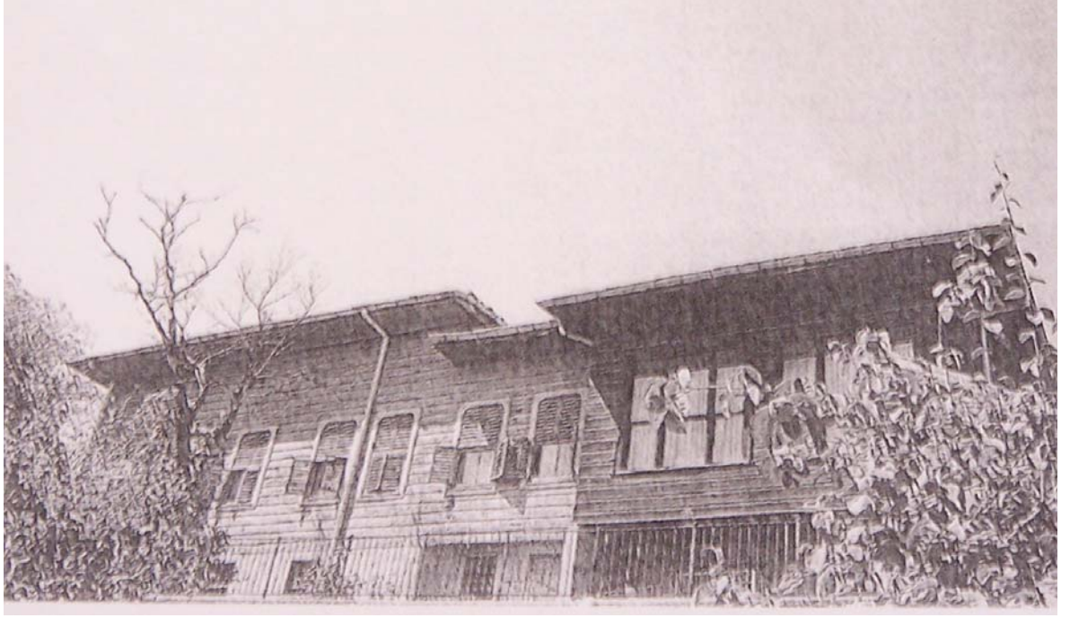
Şekil B37: Selami Efendi Tekkesi Sokak Cephesi [123 ]
