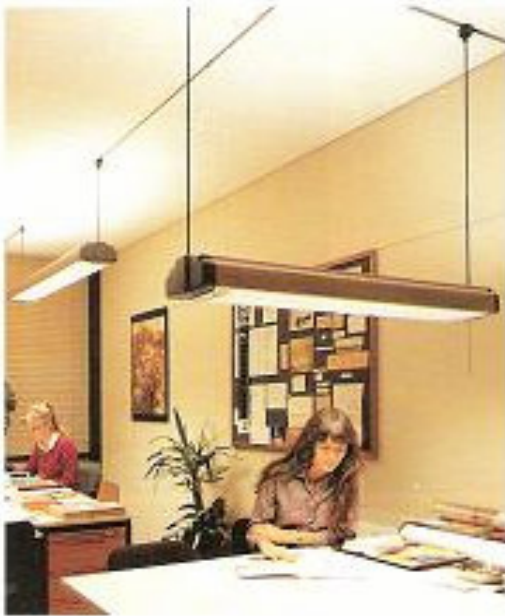
Şekil 2.31 : Oluk armatür iki düzlemde sergilenir. Bu sebepten dolayı düzlem simetrisi olarak adlandırılır.
