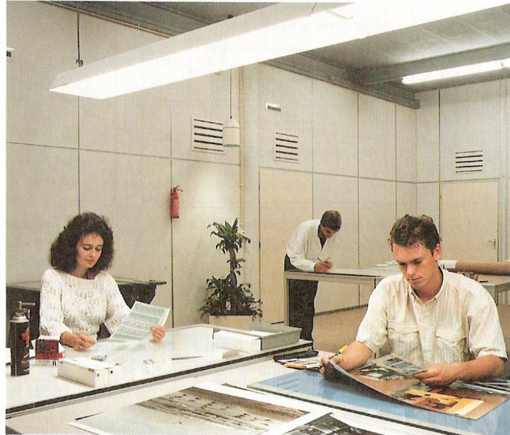
Şekil 2.2 : İzotrop yayınık yansıtıcılar iç aydınlatma armatürlerinde düzgün aydınlatma sağlamak istenen yerlerde kullanılır.
