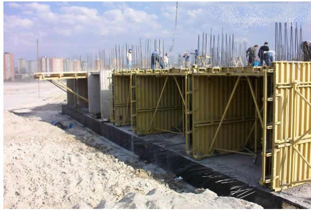
Şekil 2.15: Bodrum Katın Tünel Kalıplarla Yapımının Olanaklı Ve Olanaksız Hali
