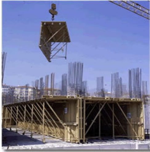
Şekil 2.12 : Tünel Kalıbın Vinçle Yerine Taşınması
