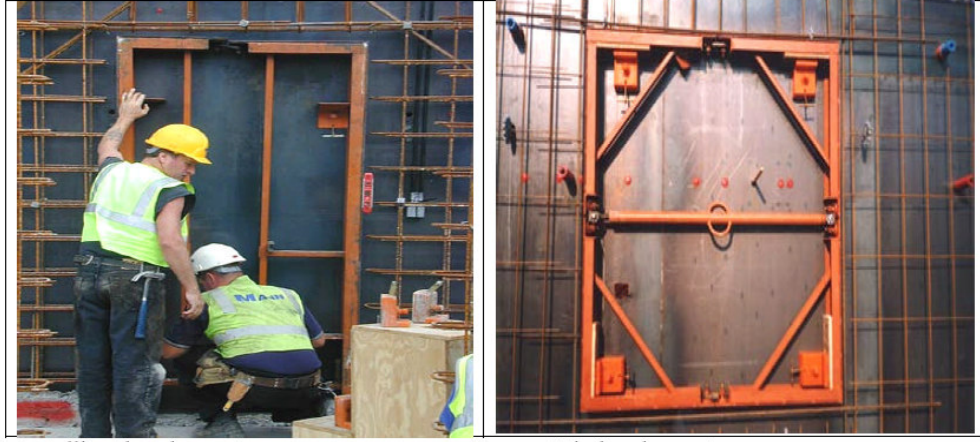
Şekil 2.7 : Tünel Kalıp İle İmalatta Kullanılan Ek Parça Örnekleri
