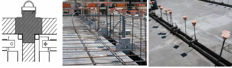
Şekil 2.11 : Aks Betonu Kalıpları
