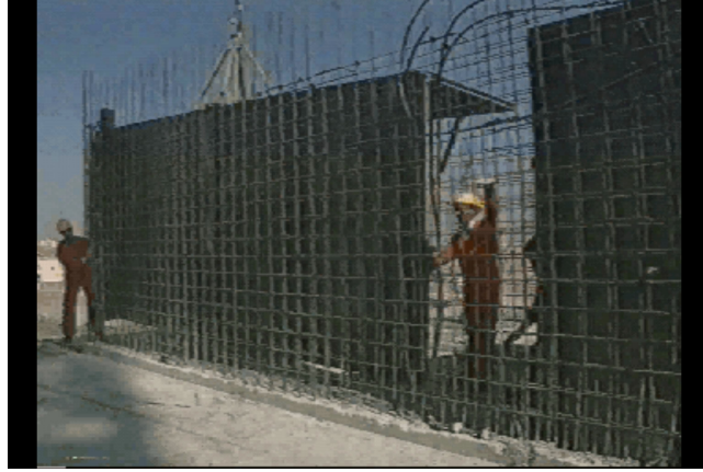
Şekil 2.13: Perdelere Hasır Bağlanmasından Sonra Tünel Kalıbın Yerine Yerleştirilmesi
