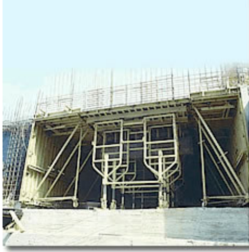
Şekil 2.6 : Tünel Kalıplarda Masa Kalıp Uygulaması
