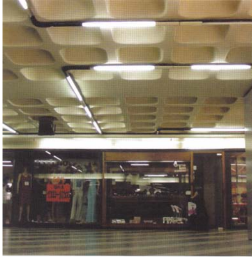
Şekil 3.41: Polipropilen kaset kalıplarıyla nervürlü döşeme uygulamaları [36]
