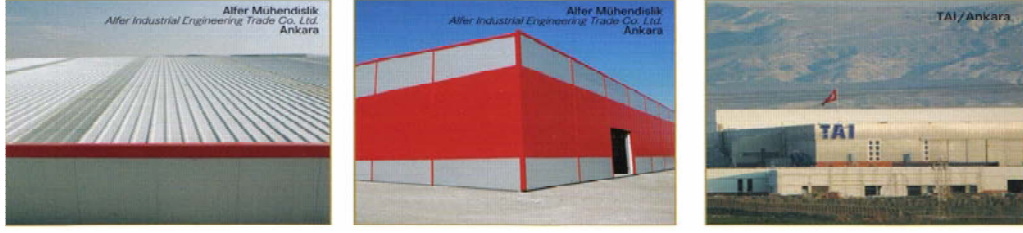
Şekil 3.42: Cephe kaplaması olarak EPS [38]
