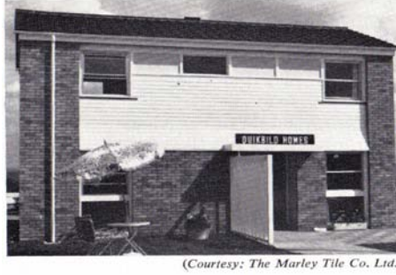
Şekil 3.48-49: PVC dış cephe ve tavan kaplaması[10]
