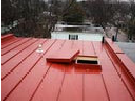
Şekil 3.16: PVDF çatı kaplaması
