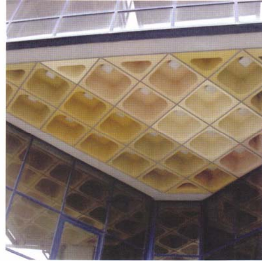
Şekil 3.41: Polipropilen kaset kalıplarıyla nervürlü döşeme uygulamaları [36]
