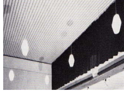
Şekil 3.48-49: PVC dış cephe ve tavan kaplaması[10]
