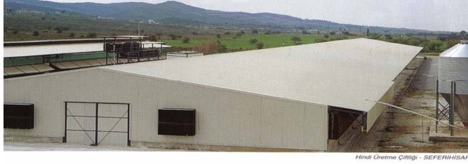
Şekil 3.22: CTP çatı ve cephe kaplaması [29]
