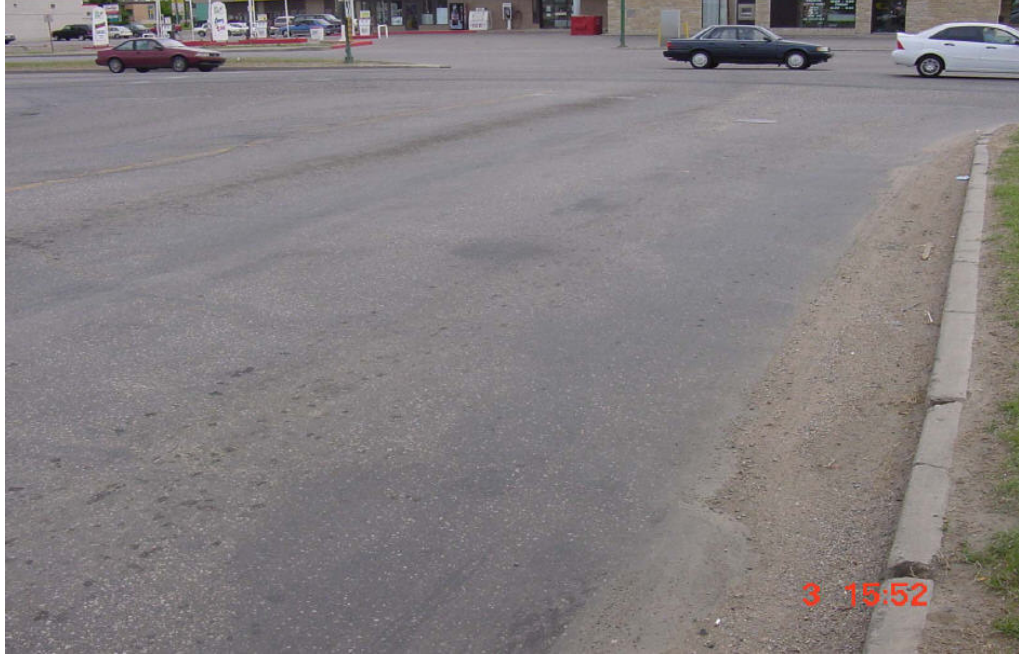
Şekil 2.11 Orta Şiddette Bombelikler (İsfalt, 2002)
