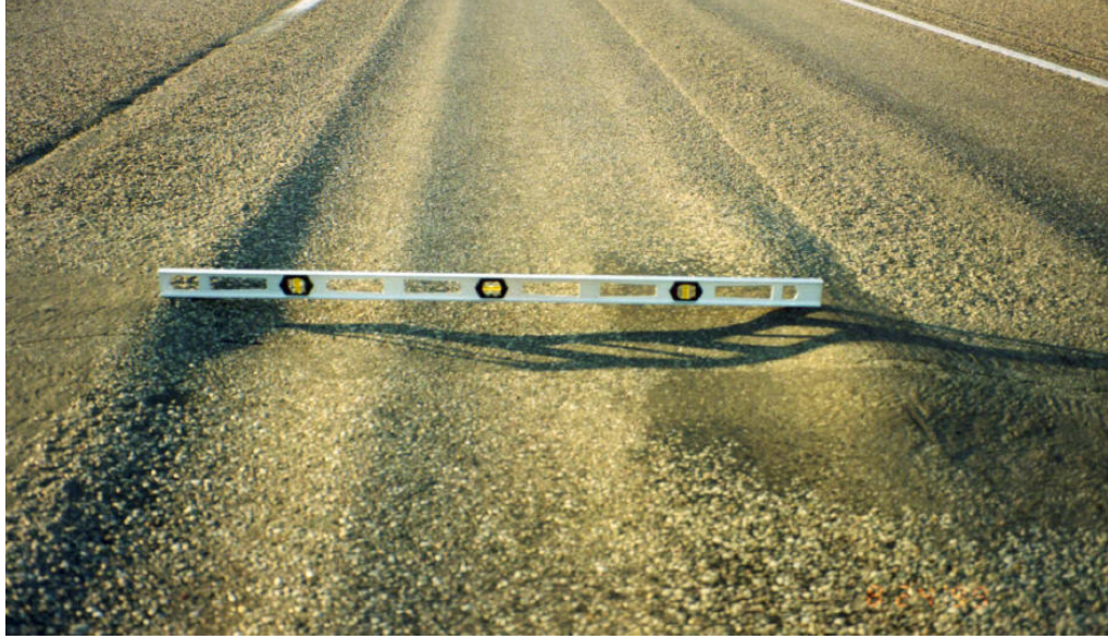
Şekil 2.9 Yüksek Şiddette Tekerlek İzinde Oturmalar (İsfalt, 2002)
