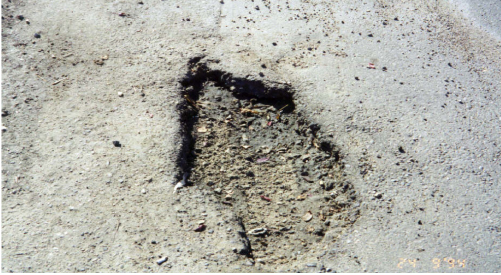
Şekil 2.12 Orta Şiddette Çukur (İsfalt, 2002)
