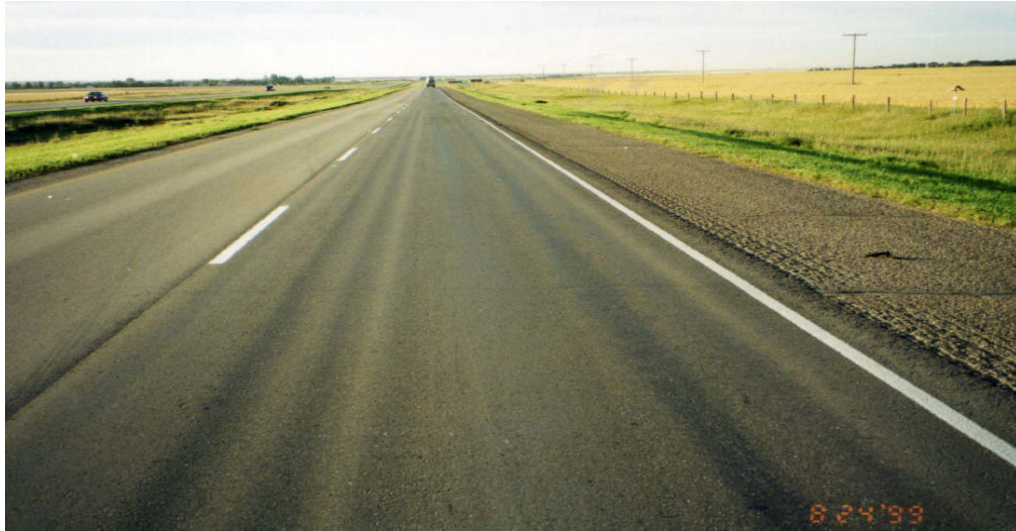
Şekil 2.8 Orta Şiddetli Tekerlek İzinde Oturma (İsfalt, 2002)
