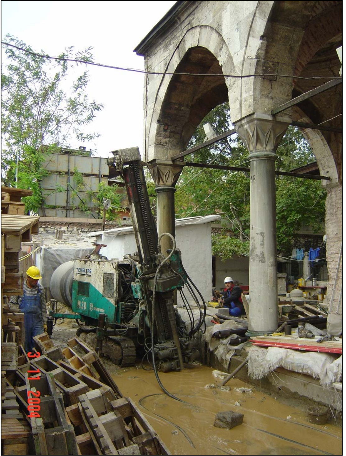
Şekil 4.7 : Casagrande M3D ile tarihi binada temel takviyesi uygulaması
