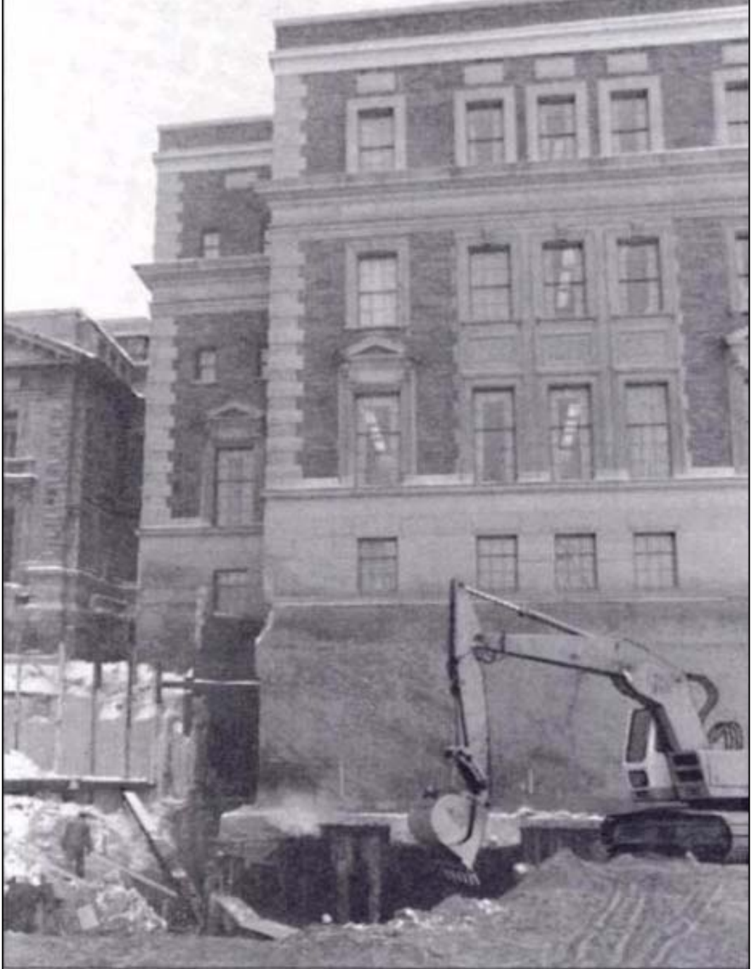
Şekil 2.42 : Jacked tipi temel takviye kazığı yapım çalışması
