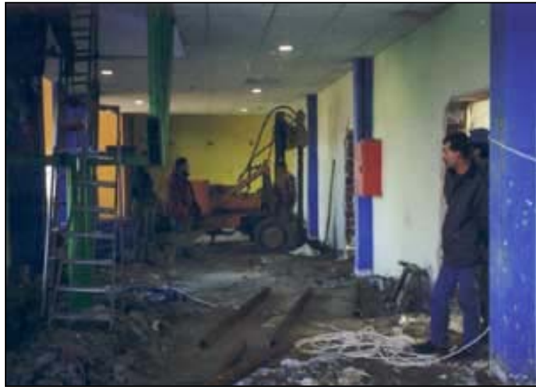
Şekil 4.9 : Kemer Kolej mini kazık uygulaması
