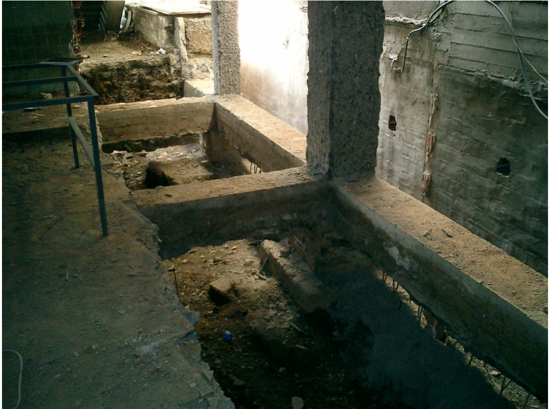
Şekil 4.35 : Temel bölgesi kolon-bağ kirişi birleşim detayı (2)
