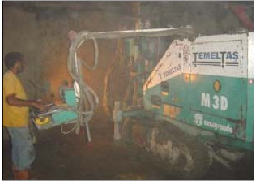
Şekil 4.10 : M3D Mini Kazık makinası ile temel takviye çalışması yapılması
