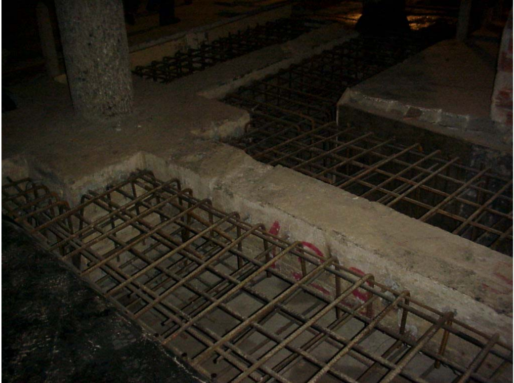
Şekil 4.40 : Yeni temel oluşturulması donatı detayı (2)
