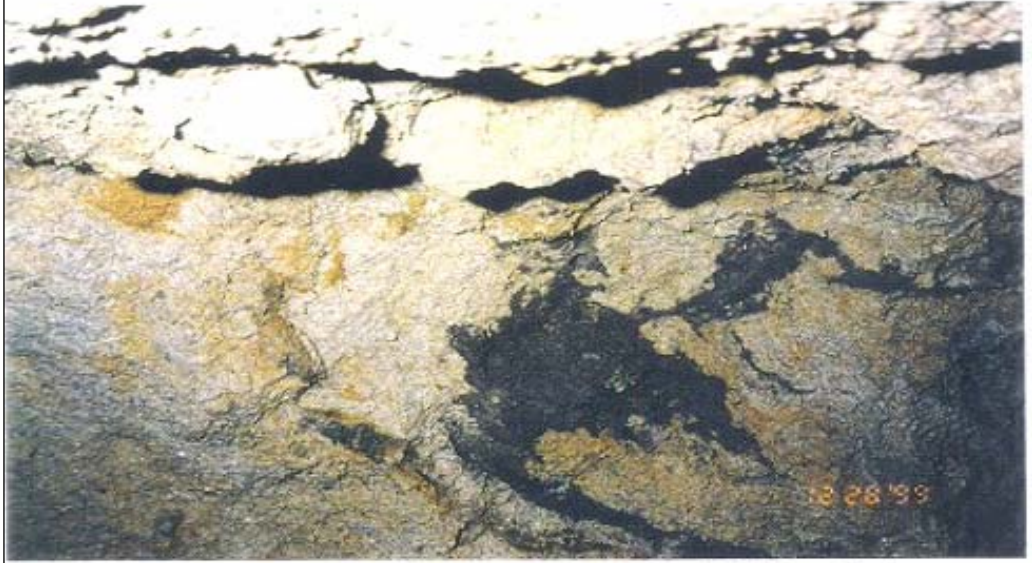
A1 Arařtırma Çukurunda Temel Altındaki Dolgu Zemin
