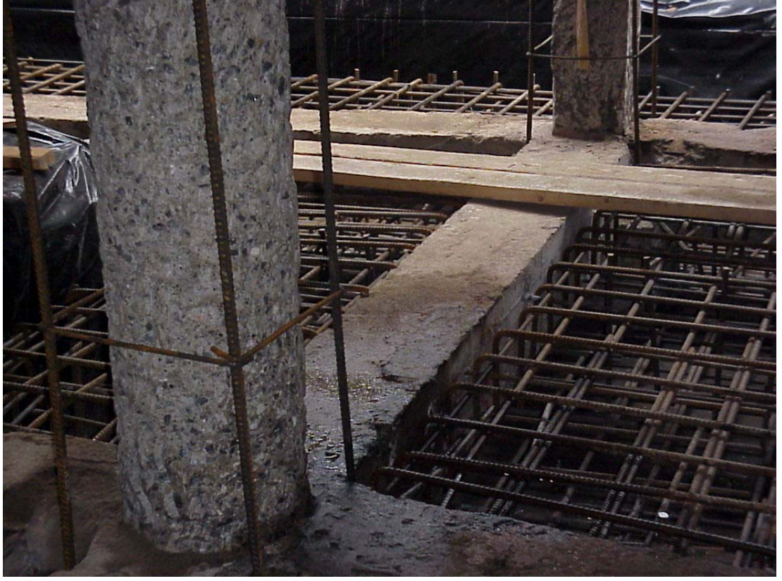
Şekil 4.41 : Yeni temel oluşturulması donatı detayı (3)
