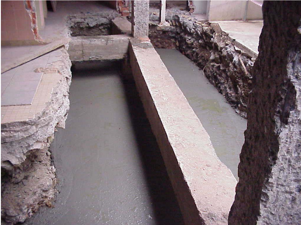
Şekil 4.38 : Bağ kirişi etrafında yeni temel oluşturulması
