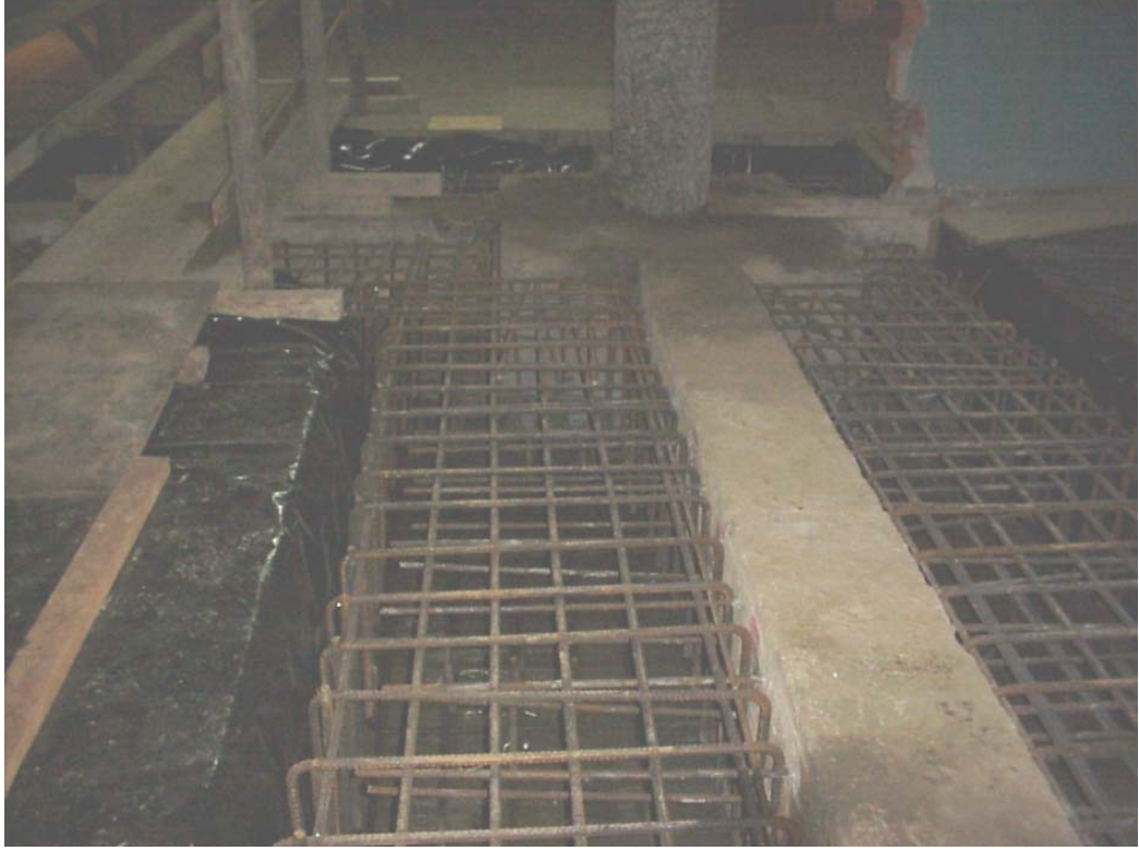
Şekil 4.39 : Yeni temel oluşturulması donatı detayı (1)
