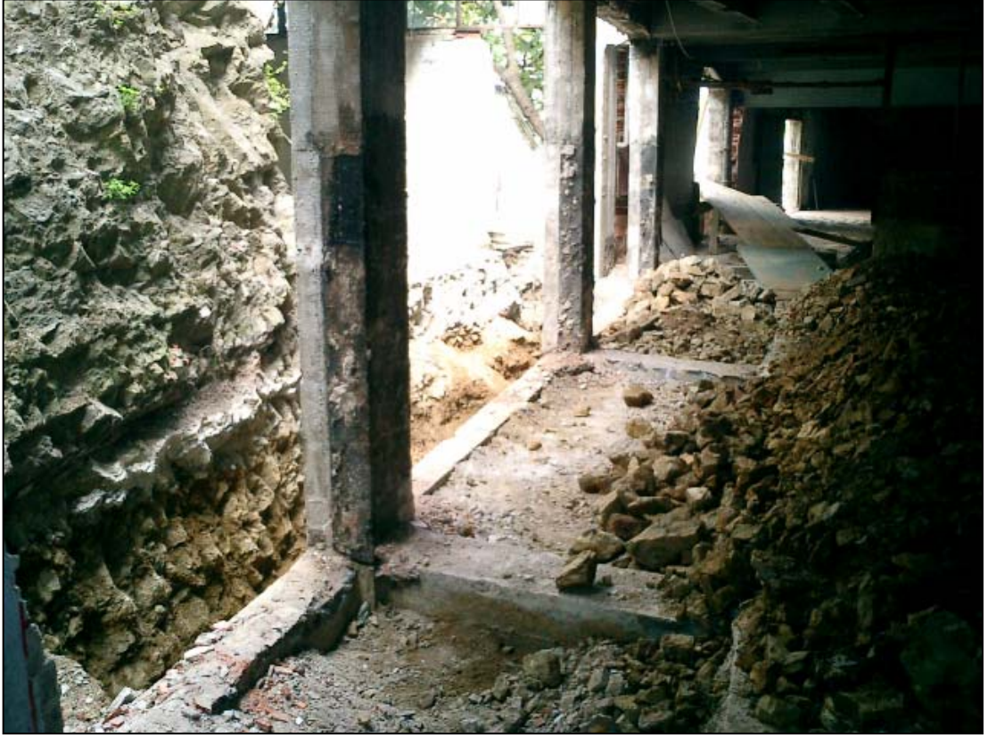
Şekil 4.34 : Temel bölgesi kolon-bağ kirişi birleşim detayı (1)
