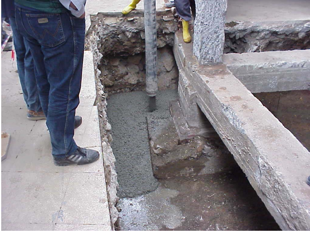
Şekil 4.37 : Temel çevresinde grobeton dökülmesi (2)
