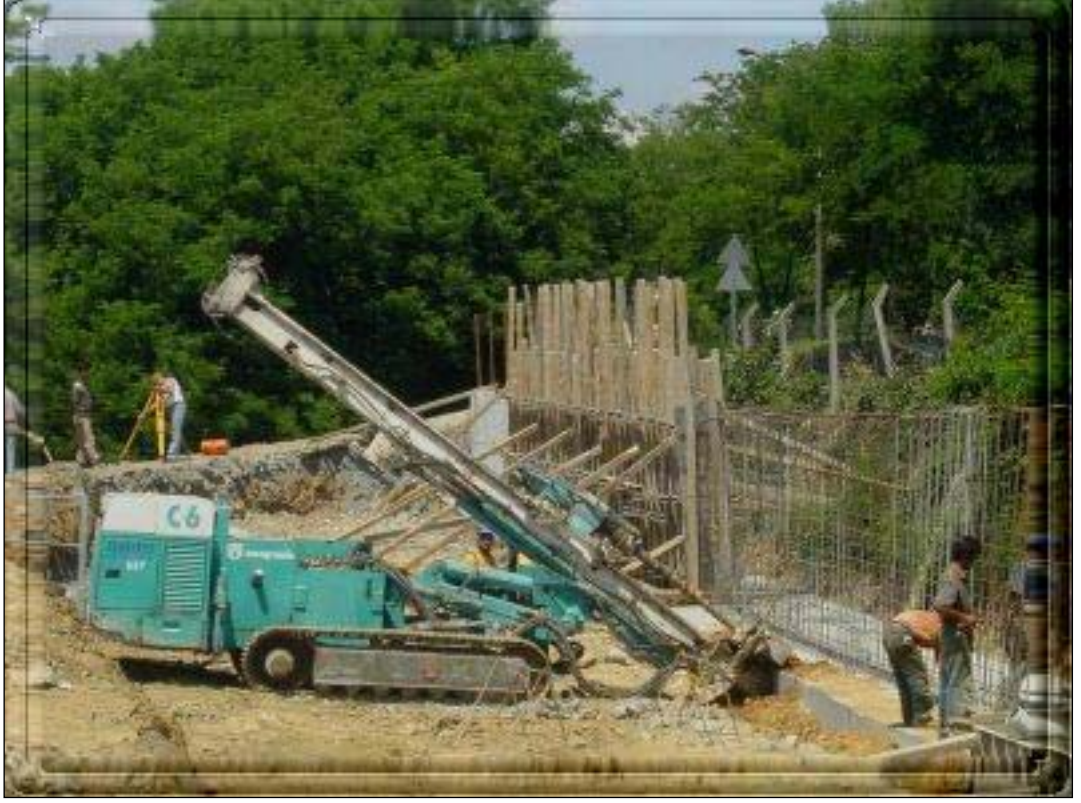
Şekil 4.8 : Casagrande C6 mini kazık ekipmanı
