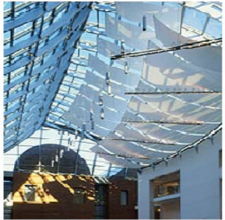
Şekil 3.22: Atriumların Saydam Üst Örtülerinde Uygulanan Gölgeleme Elemanları
