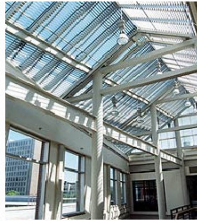
Şekil 3.22: Atriumların Saydam Üst Örtülerinde Uygulanan Gölgeleme Elemanları
