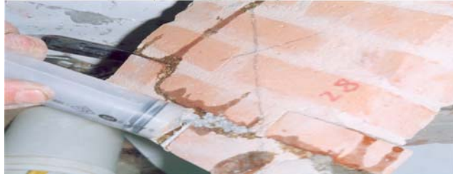
Şekil 5.2: Tuğla Duvarların Örneklerinin Tamir Edilmesi
