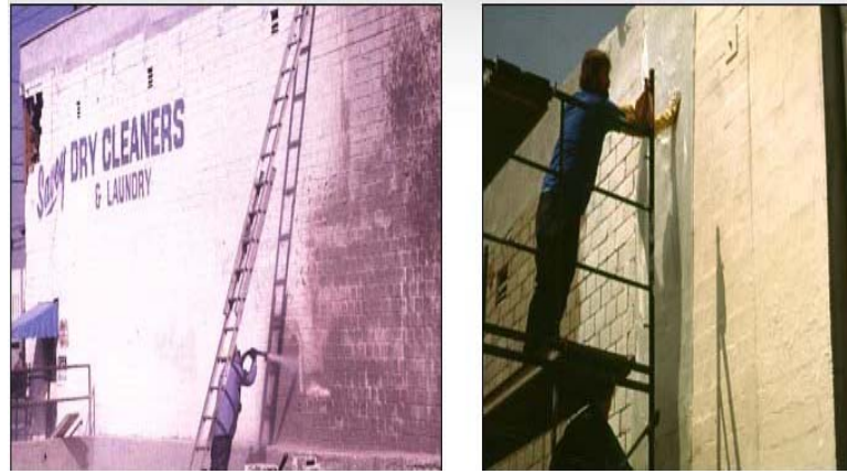
Şekil 2.22: Yığma Yapıda CFRP Uygulaması [18]
