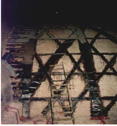
Şekil 2.24: Kemerde FRP Uygulaması-1.
