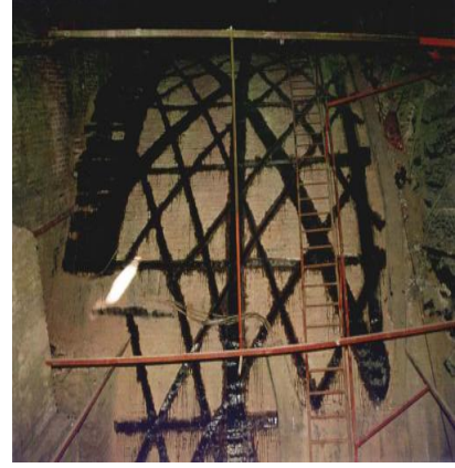
Şekil 2.25: Kemerde FRP Uygulaması-2.
