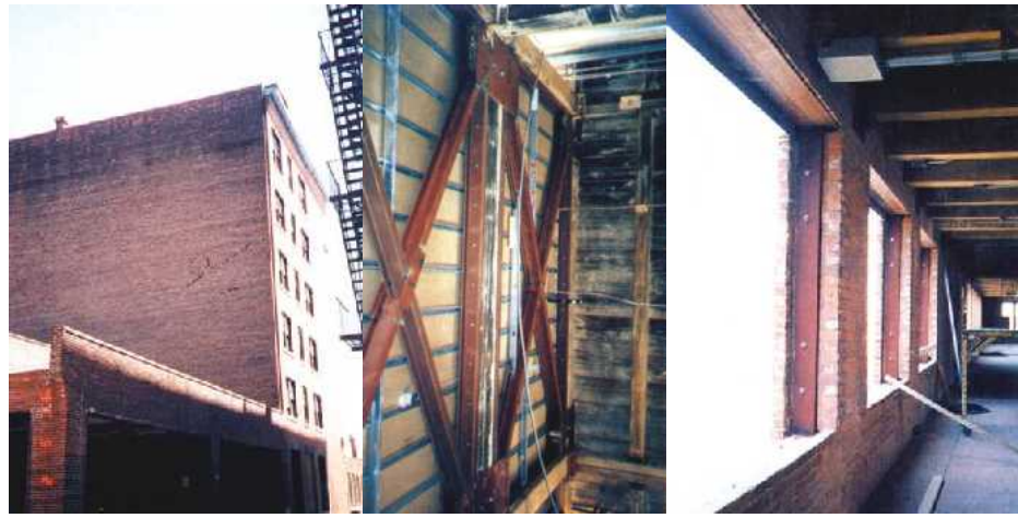
Şekil 2.21: Çelik Çerçevelerle Güçlendirme Örneği (Deri İmalathanesi)
