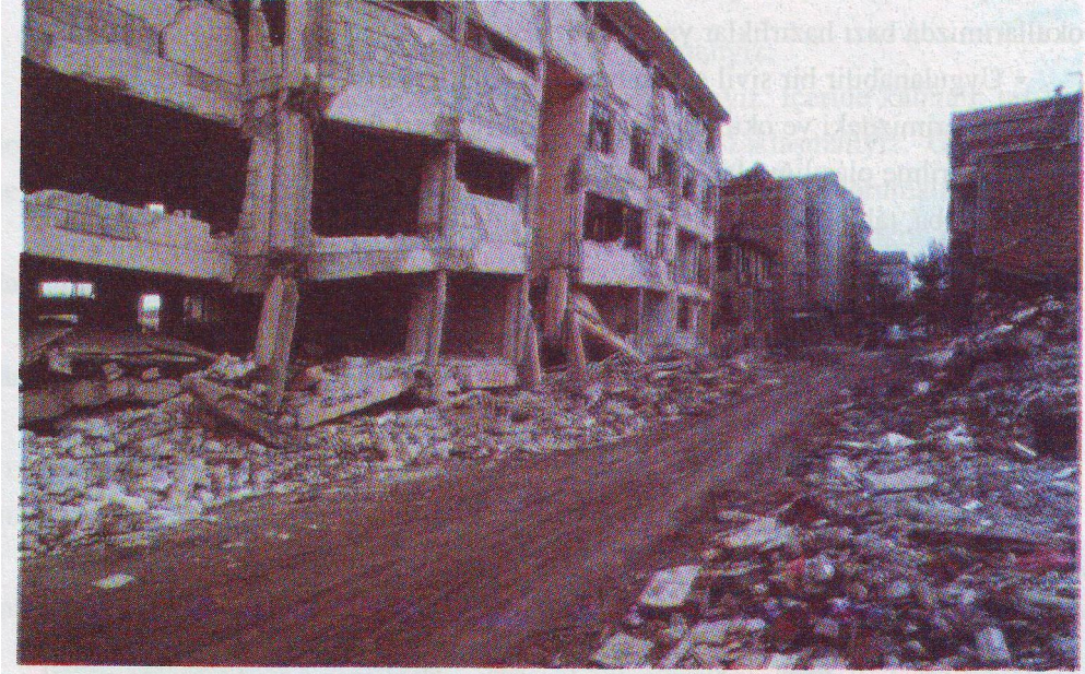
Resim 3.23: Deprem, sağlam yapılmamış binaların hasar görmesine neden olur. Marmara depremi (17 Ağustos 1999)
