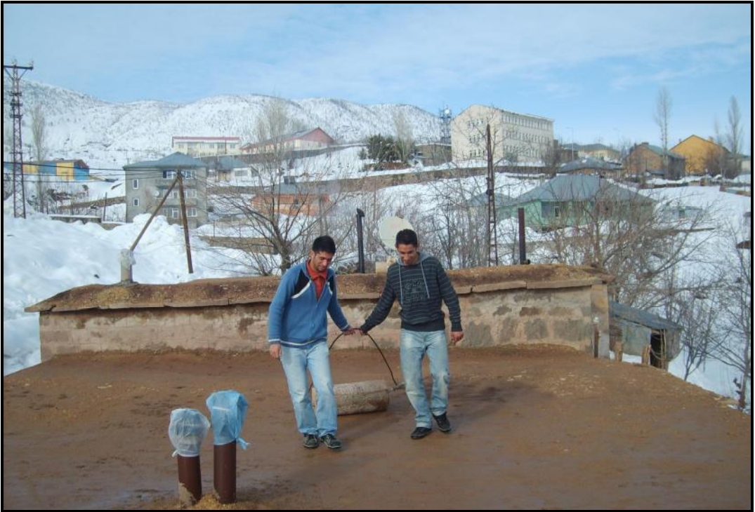
Foto-10. Düz Dam Yapılarda Sızmayı Önlemek İçin Kullanılan “Loğ”
