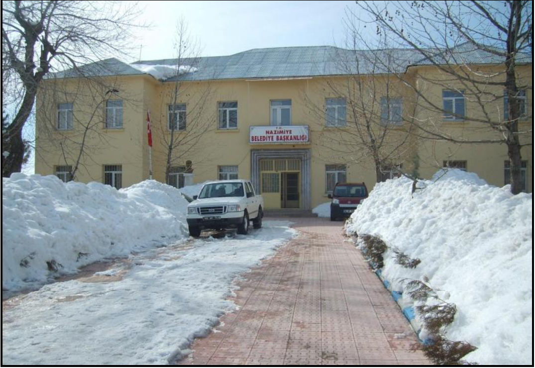
Foto-1. Nazimiye Belediye Binası
