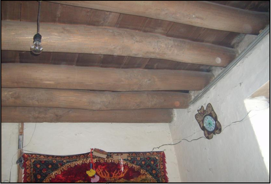
Foto-9. Eski Tip Yapılarda Örtü Sistemlerde Kullanılan Ağaç Malzeme
