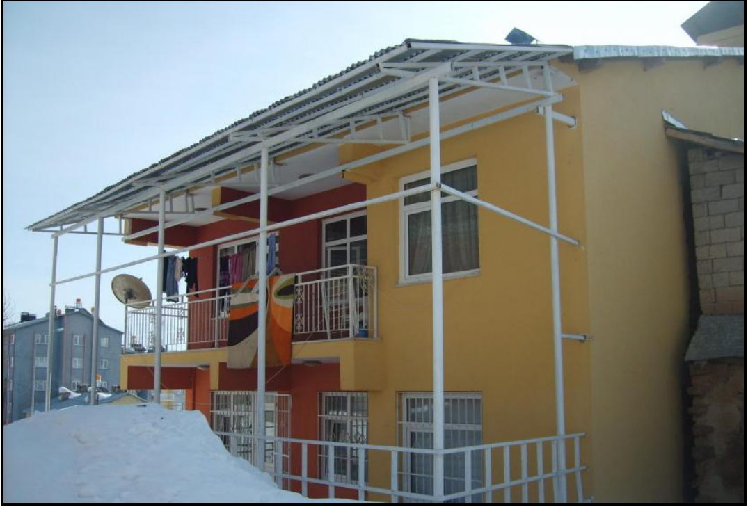
Foto-11. Nazımiye'de Yeni Tip Yapı (Yukarı Mahalle)
