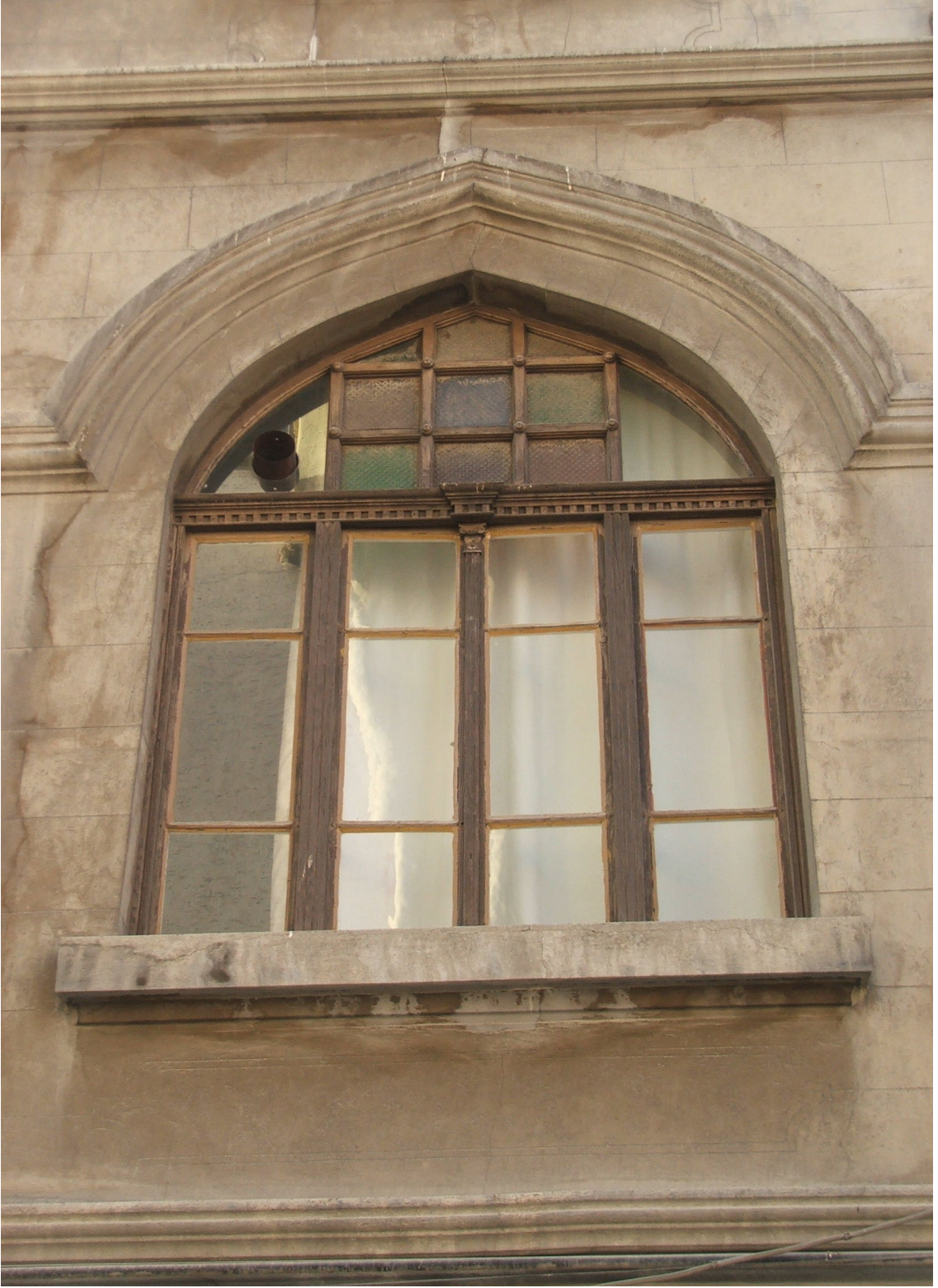
Resim 4: Bozüyük- Kasımpaşa Mah. Hamam Sok. No: 2
