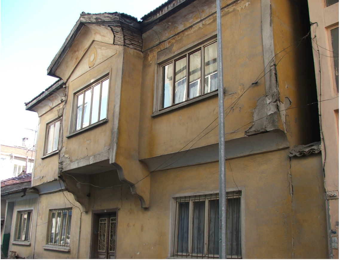
Resim 31: Bozüyük- Yeni Mah. Şevket Usta Sok. No: 24
