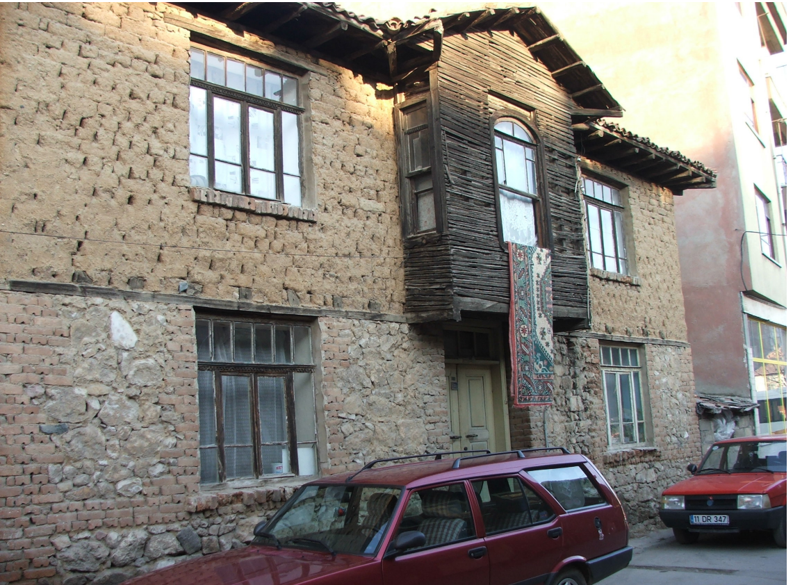
Resim 13: Bozüyük- Kasımpaşa Mah. Hacı İbrahim Sok. No: 2
