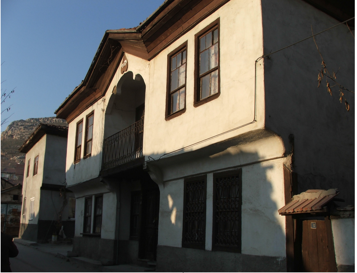
Resim 8: Bozüyük- Kasımpaşa Mah. Hacı İbrahim Sok. No:12
