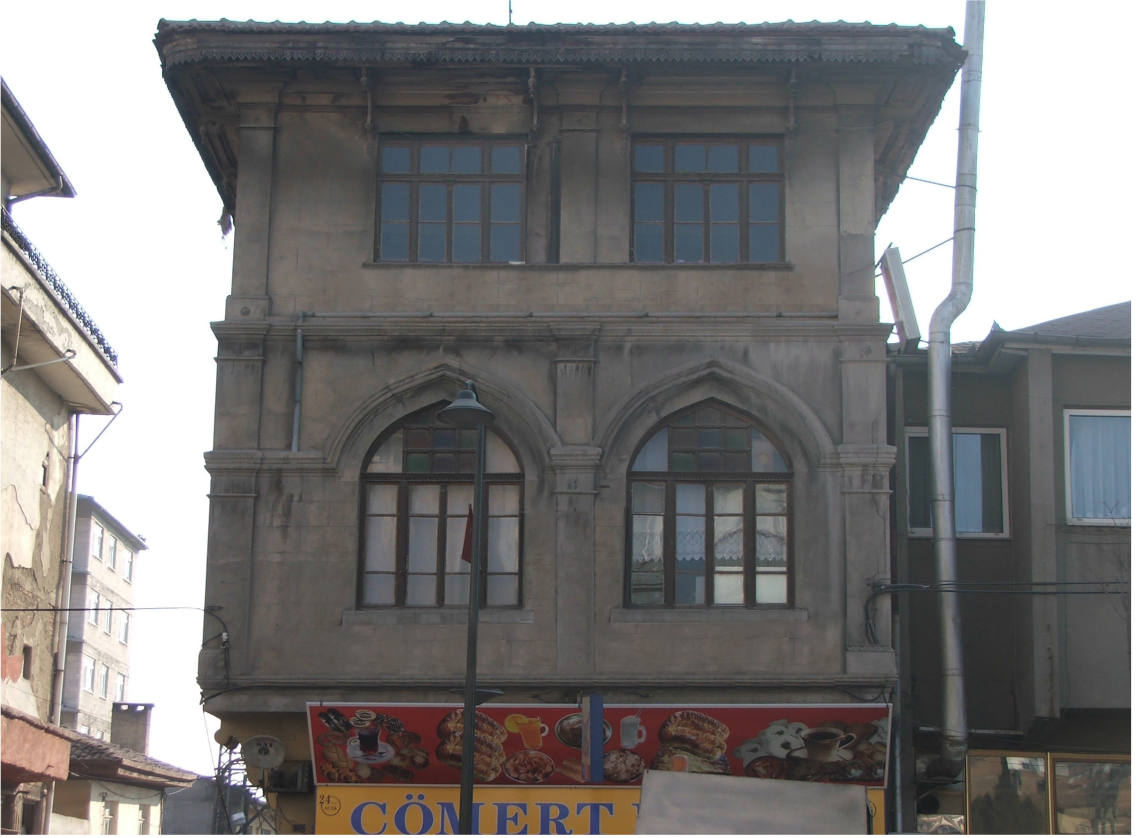
Resim 44: Bozüyük- Kasımpaşa Mah. Hamam Sok. No: 2
