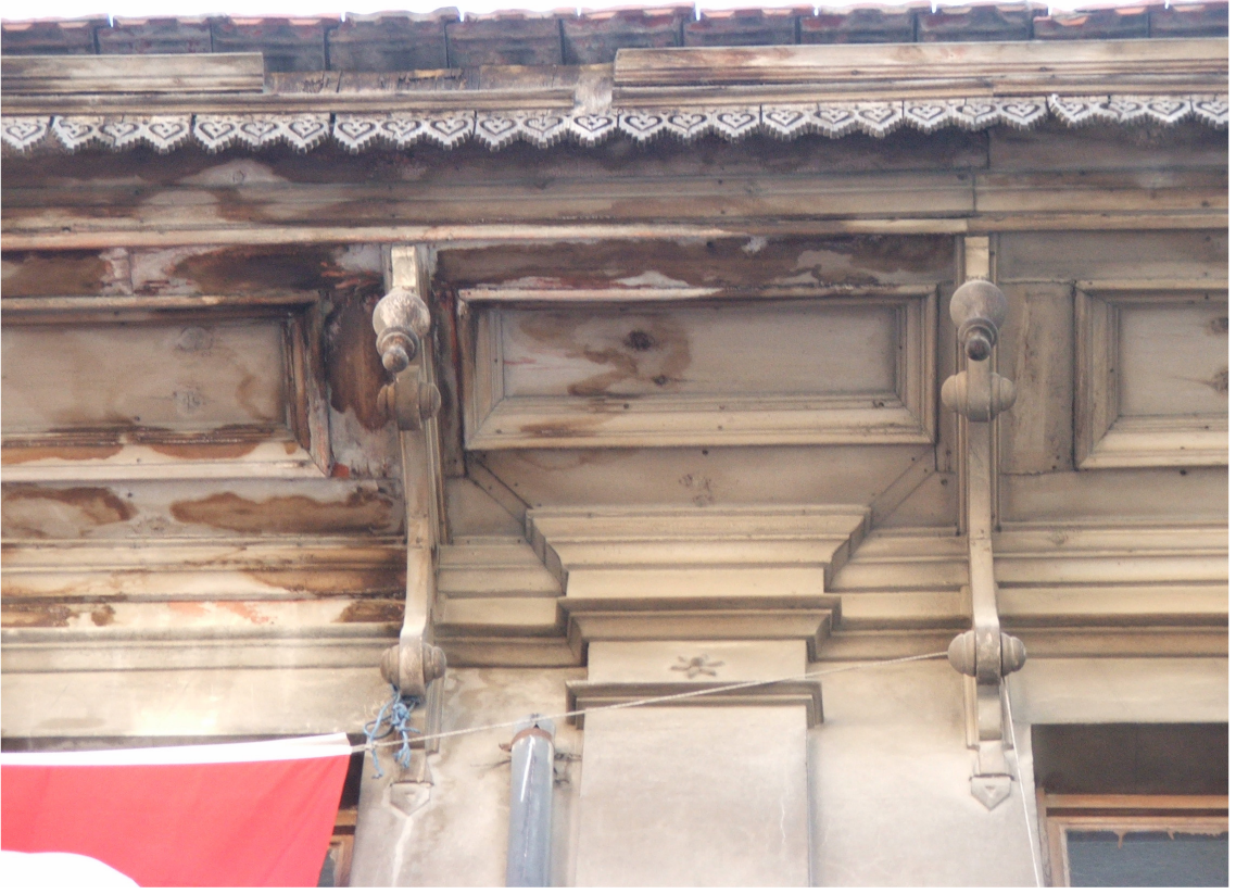
Resim 46: Bozüyük- Kasımpaşa Mah. Hamam Sok. No: 2
