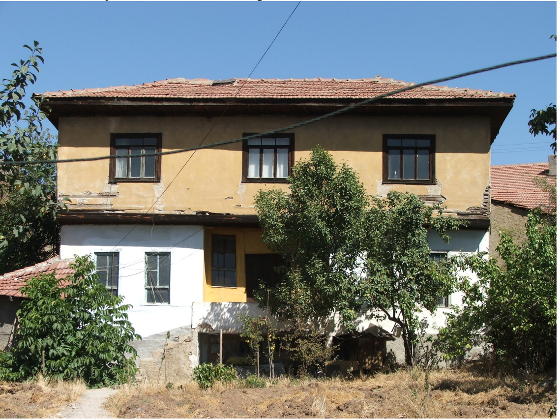
Resim 20: Kasımpaşa Mah. Ayaz Sok. No: 7
