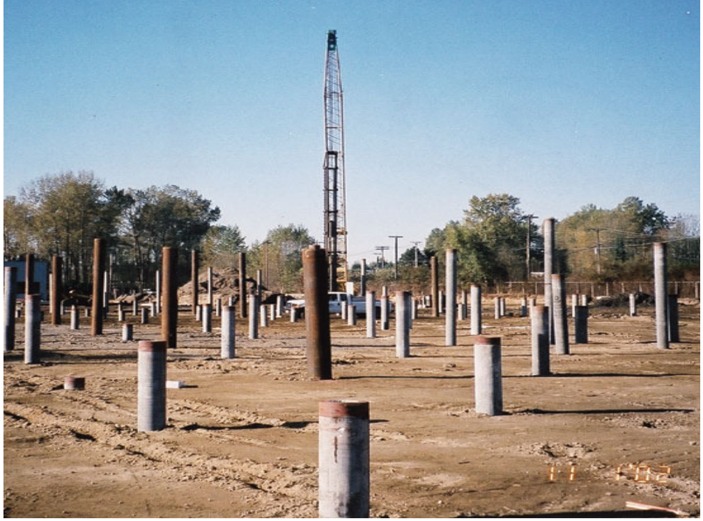
Şekil 2.9: Prekast Çakma Betonarme Kazık ( www.griffithspile.com )
