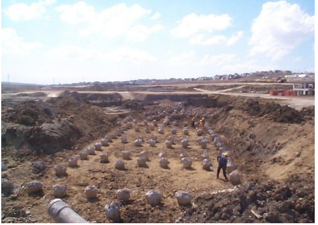
Şekil 5.22: Konutların Altlarında İmal Edilmiş Yerinde Dökme Kazıklar
