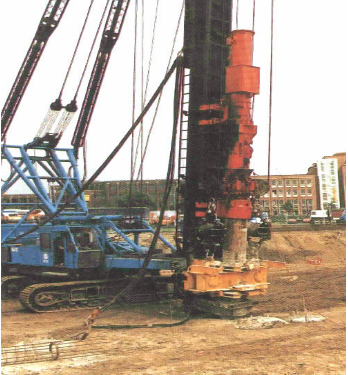
Şekil 2.10 : Yerinde Dökme Betonarme Kazık ( www.pileco.com )
