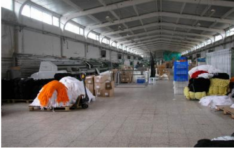
Şekil 4.39. Fabrikadan genel bir görünüm
