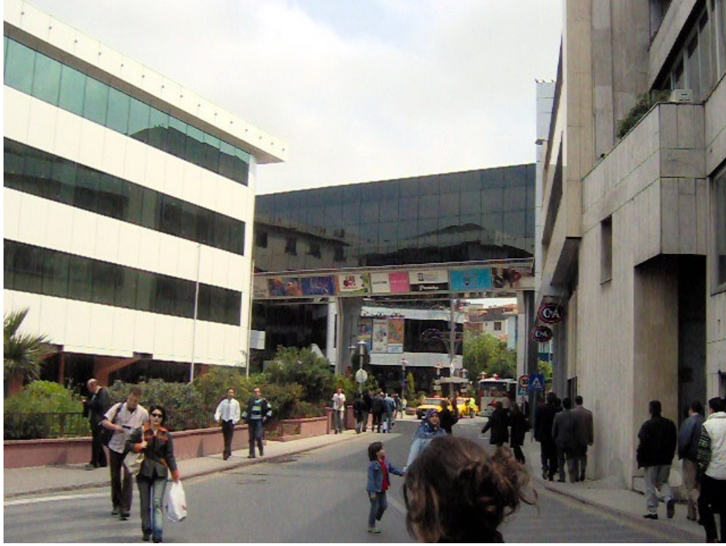
Şekil 6.14: Profilo Alışveriş Merkezi ile Profilo Elektronik Sanayi ve Ticaret A.Ş. Yönetim Binası Arasından Geçen Yol
