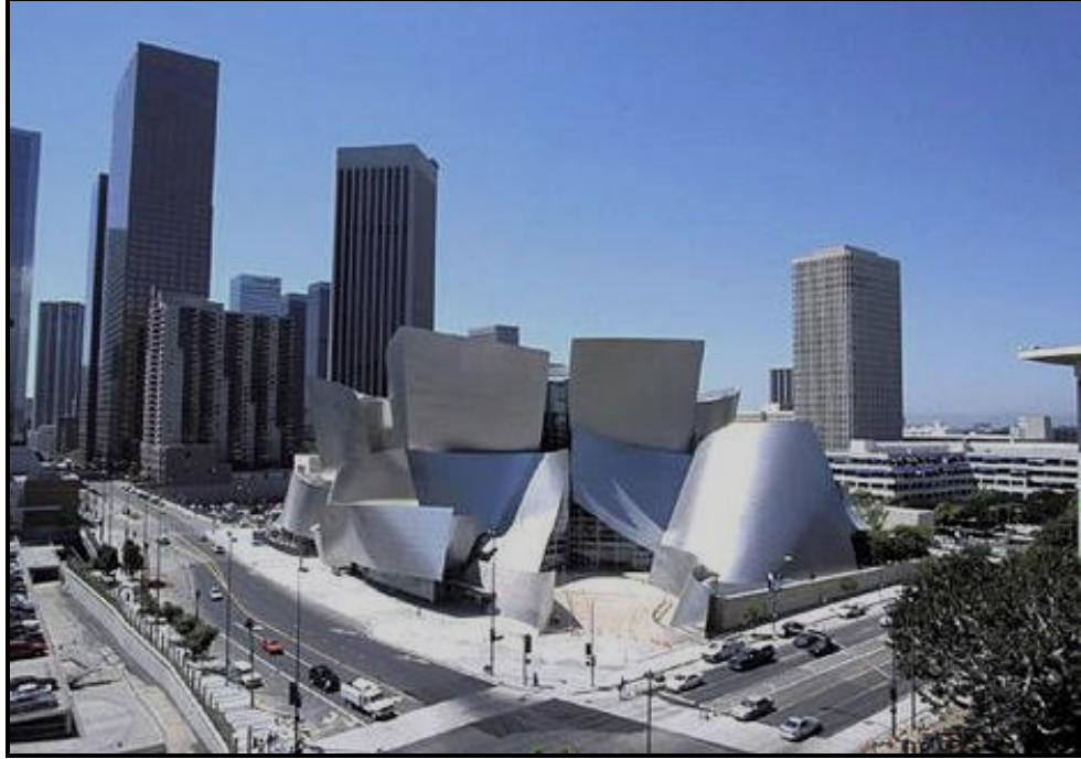
Şekil 5.11. Walt Disney Konser Salonu Görünüşü [41]
