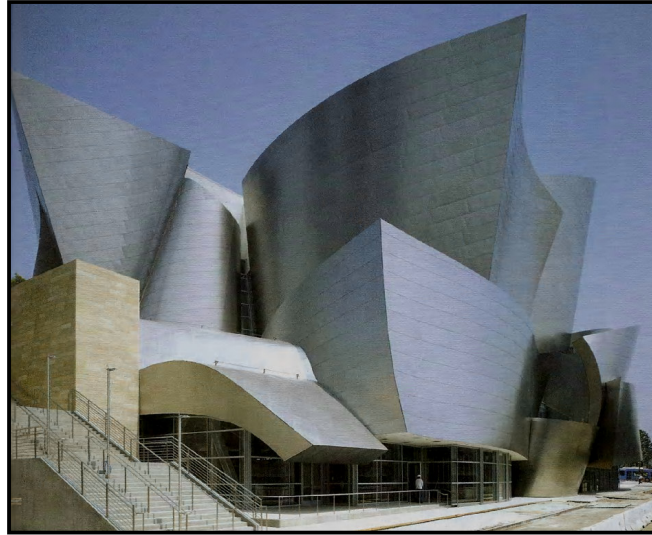
Şekil 5.13. Walt Disney Konser Salonu Giriş Cephesi [40]
