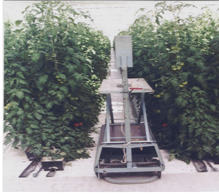
Şekil 3.12. Bergama'da jeotermal enerjiyle ısıtılan ve ısıtma borularının aynı zamanda ray olarak kullanıldığı seralar (Teknoser, 2007)
