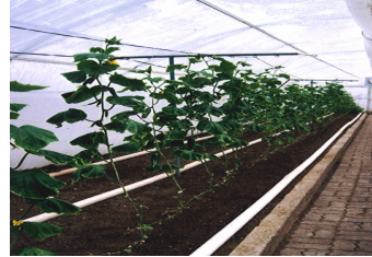
Şekil 3.23. Poietilen ısıtma borularıyla ısıtılan seralar (Teknoser, 2007)
