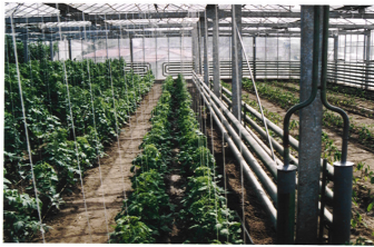
Şekil 3.24. Metal ısıtma borularıyla ısıtılan seralar (Teknoser, 2007)
