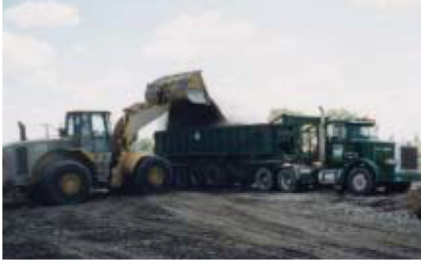
Şekil 5.5 : Atık Döküm Kumunun Yol Tabanında Kullanımı (US Federal Highway Administration, 2004)
