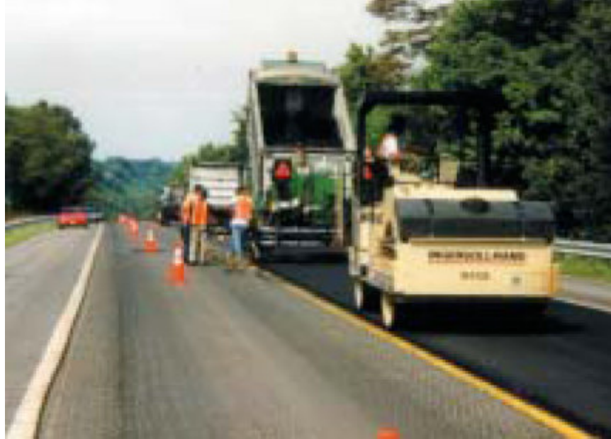
Şekil 5.6 : Sıcak Asfalt Karışımla Yol Kaplaması (US Federal Highway Administration, 2004)
