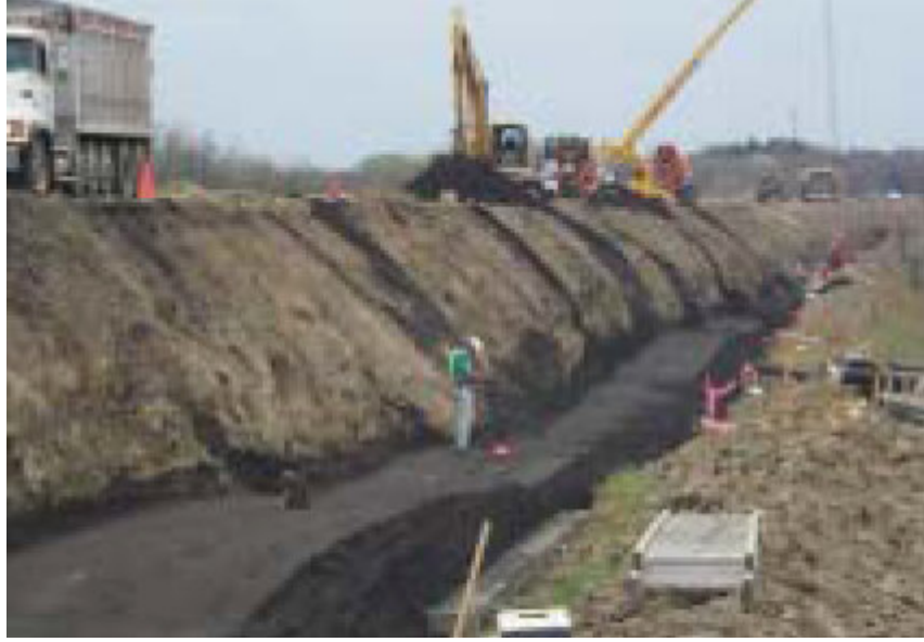
Şekil 5.3 : Atık Döküm Kumunun Yol Dolgusunda Kullanımı(US Federal Highway Administration, 2004)
