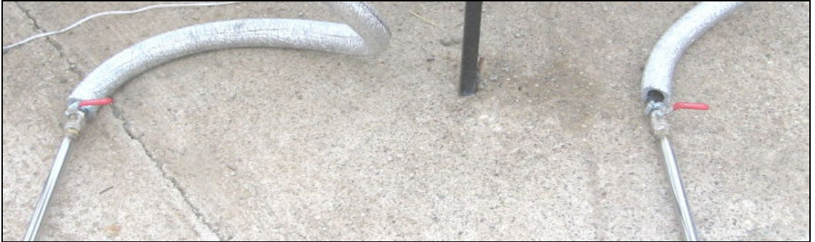
Şekil 3.10. Küresel vanaların borular üzerine yerleştirilmesi
